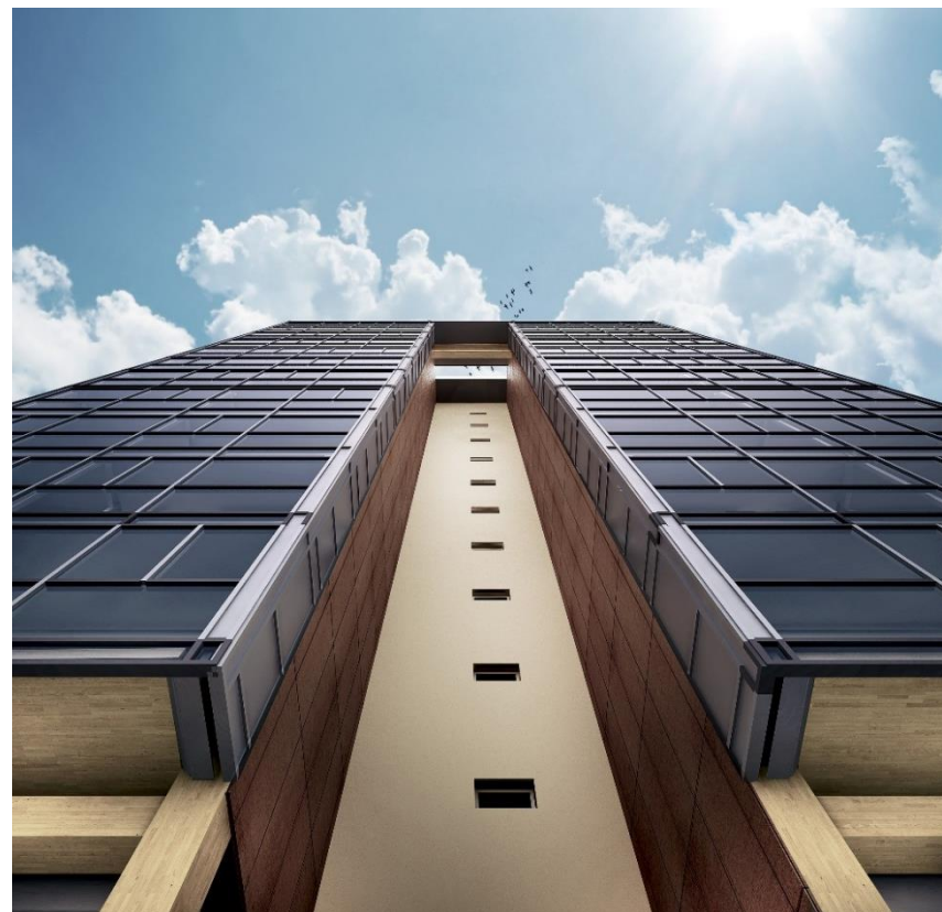
Figur: "Treet" i Bergen. Bygget er konstruert som trebygg med limtrebjelker som ytre og indre skjelett, og har 14 etasjer over sokkelen i betong som blant annet inneholder parkering og tekniske hovedinstallasjoner. Foto: Sweco
