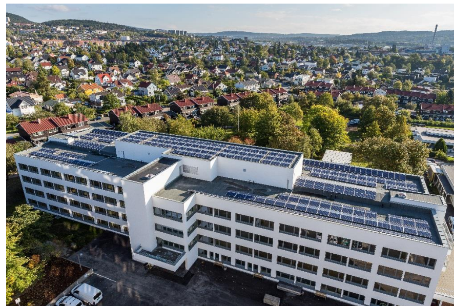
Figur: Drøye 800 kvm med solceller fikk plass på taket når Økern sykehjem skulle rehabiliteres, tilsvarende en installert effekt på 130 kWp, og en årlig forventet produksjon på rundt 94.000 kWh. Også byggingen av Oslos største solcelleanlegg var en del av rehabiliteringen av Økern sykehjem. Målet var å redusere energibruken for bygget med 68 % til omtrent 120 kWh per kvadratmeter årlig. Klimagassutslippene for Økern sykehjem «som prosjektert» kan vise til 33,5 prosent lavere utslipp enn et referansebygg beregnet etter TEK10. (Kilde, Sweco)
