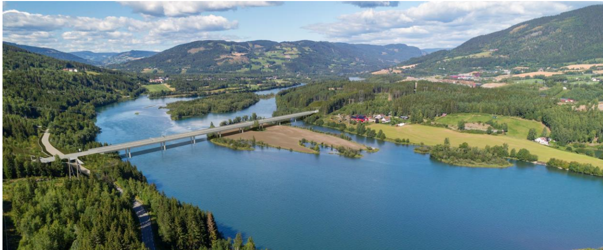
Figur 10. Modellutsnitt av betongkassebru over Lågen. Til venstre i bildet vises tunnelpåhugg, omlagt fylkesvei og terrengtilpasning av bru på Trosset.
