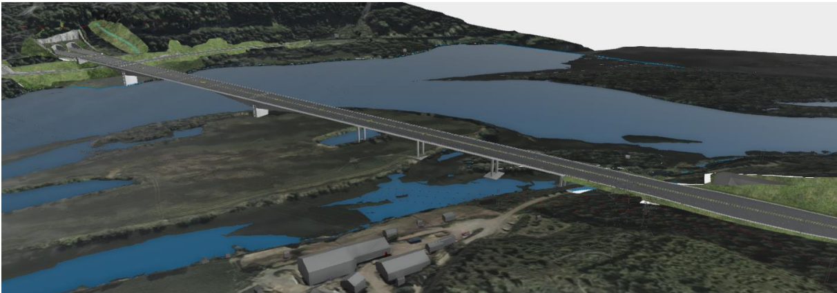
Figur 1-14. Lågen bru i justert linje, fritt frembygg-bru
