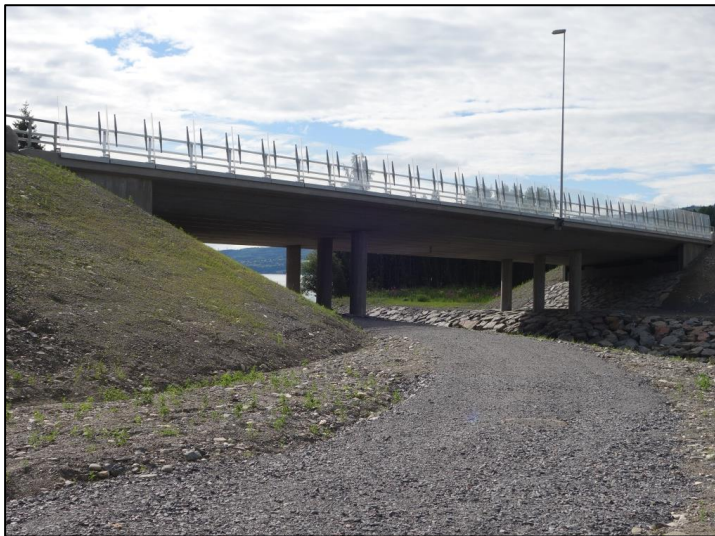
Figur 24: Eksisterende bru E6 over Rinda, sett fra oppstrøms side (Bilde fra Brutus)
