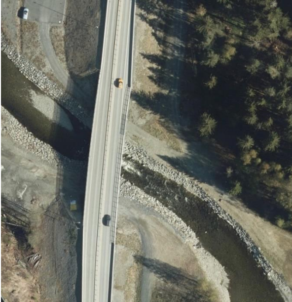
Figur 27: Flyfoto dagens bru E6 over Rinda
