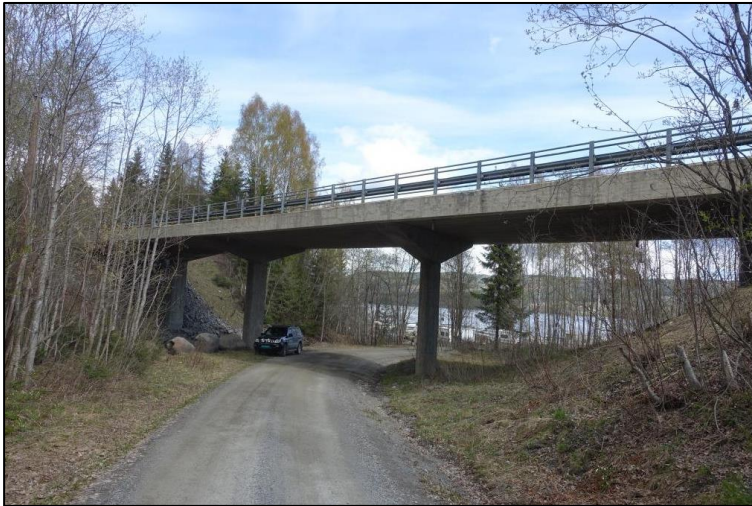
Figur 16: Eksisterende bru E6 over Kalverudelva, sett fra oppstrøms side (Bilde fra Brutus)
