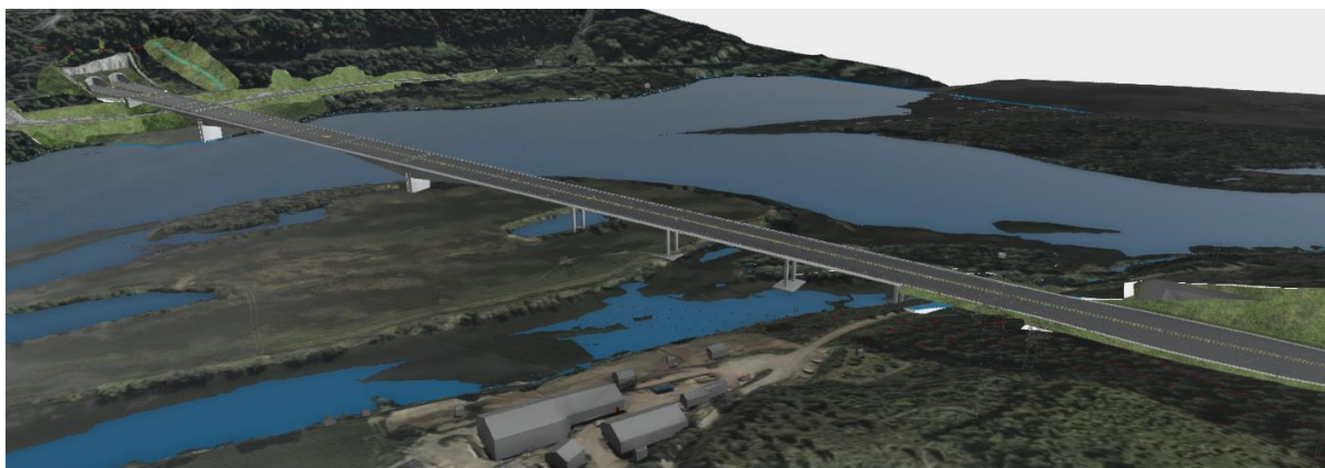
Figur 1-14. Lågen bru i justert linje, fritt frembygg-bru
