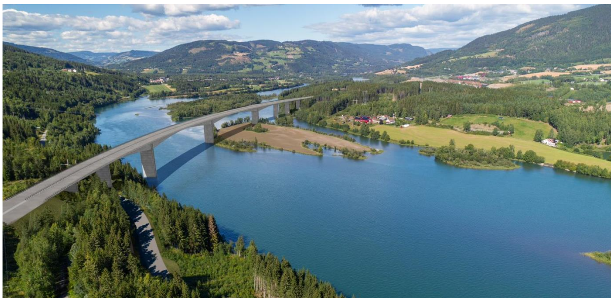
Figur 1-15. Lågen bru i kommunedelplanlinjen, fritt frembygg-bru
