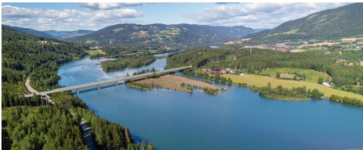
Figur 1-13. Lågen bru i justert linje, betongkassebru
