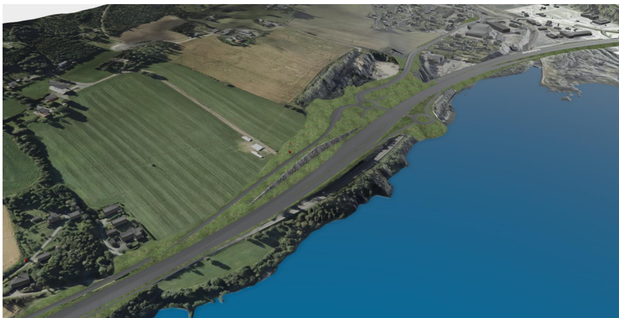
Figur 1-5. Vingrom kryss sør, ved Jevne
