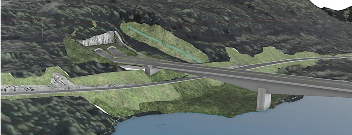
Figur 5-108 Bilde fra modell med frittrem-bygg bru som viser området der brua treffer land på Trossetsiden. Brua treffer land på oppsiden av fylkesveien. Lokalveien som senkes noe under brua. Tiltaket medfører ingen vesentlig fylling i Lågen.
