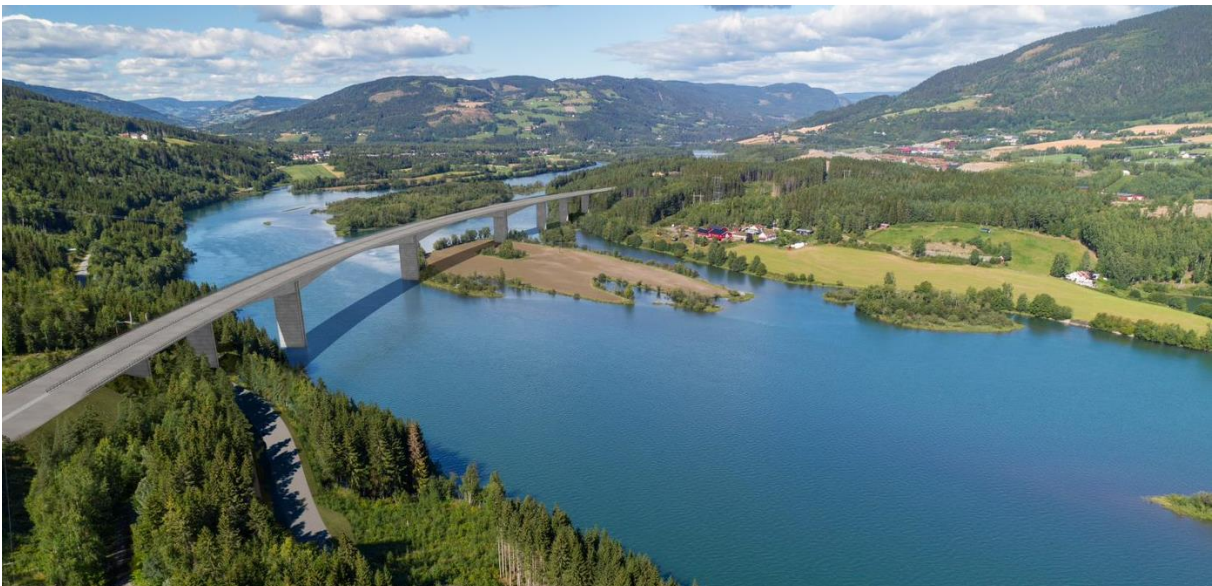
Figur 1-15. Lågen bru i kommunedelplanlinjen, fritt frembygg-bru
