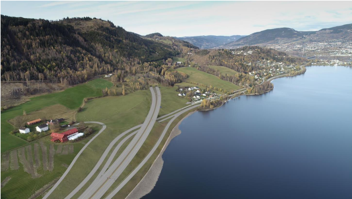
Figur 5-75 Illustrasjon som viser halvt kryss i Øyresvika, arrondering for jordbruksarealer ved Bulung gård og portalområdet etter at ny vegetasjon er etablert.
