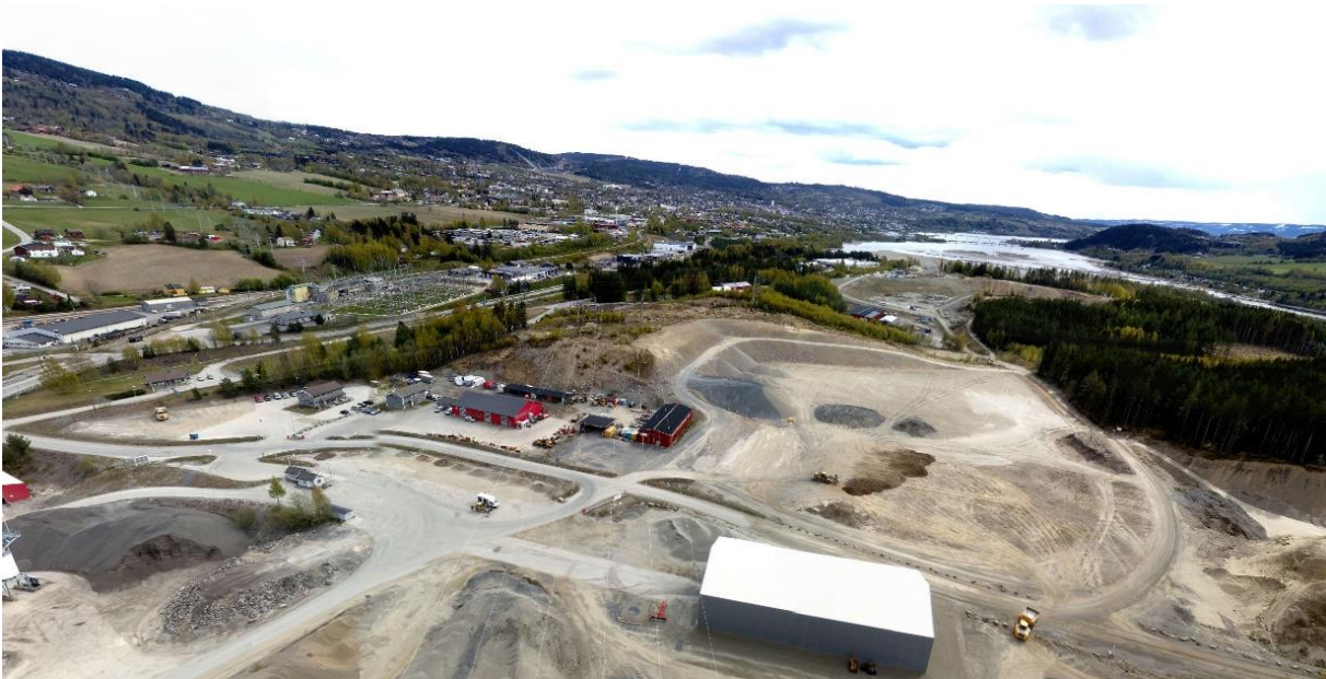
Figur 5-98 Bilde av næringsarealene sett mot sør med Lillehammer by og Lågendeltaet bak i bildet. I tillegg til grusuttak og andre næringsarealer, er området sterkt preget av kraftanlegg. (Dronebilde AF 2020)
