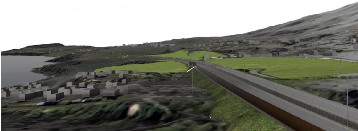
Figur 5-21 Bilde sett fra Stranda og sørover som viser ny veifylling og støyskjerming forbi Stranda og Furuodden camping
