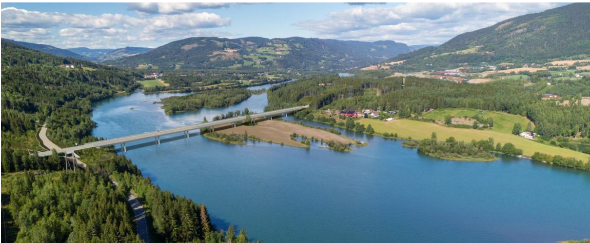
Figur 1-13. Lågen bru i justert linje, betongkassebru
