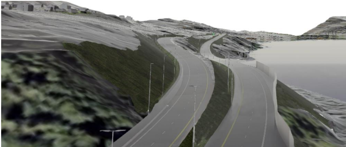
Figur 5-18 Bilde fra modell som viser bruer over Bjørnstadelva i forkant av bildet, støyskjerming langs campingplassen og høy skjæring på østsiden av veien nord for brua. Nord for bruene starter terrassert løsning mellom sør- og nordgående felt på E6.
