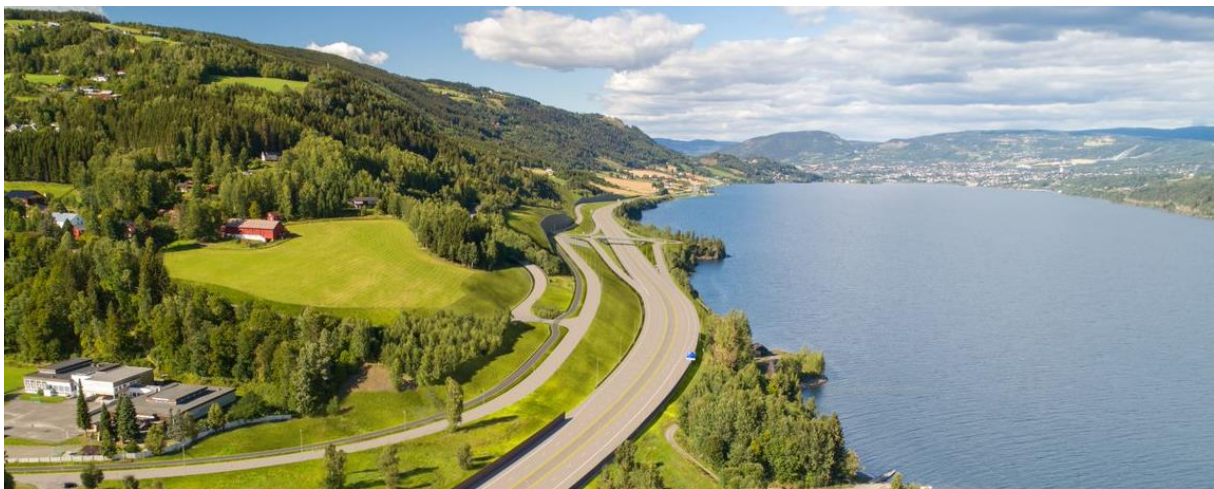
Figur 5-60 Illustrasjon med kryss nord og Vingrom i forkant av bildet. Tursti/ tråkk langs Mjøsa er ikke lagt inn i illustrasjonen.
