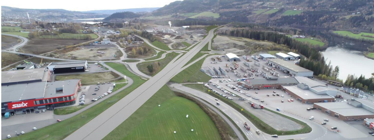
Figur 5-118 Illustrasjon som viser ny E6 med kryss midt ved næringsarealene på Storhove sett fra nord.
