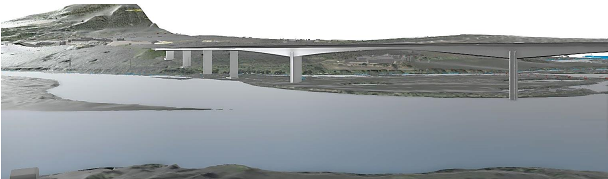
Figur 5-125 Bilde av brua fra modell fra nord sett fra Jøstadmogvegen.
