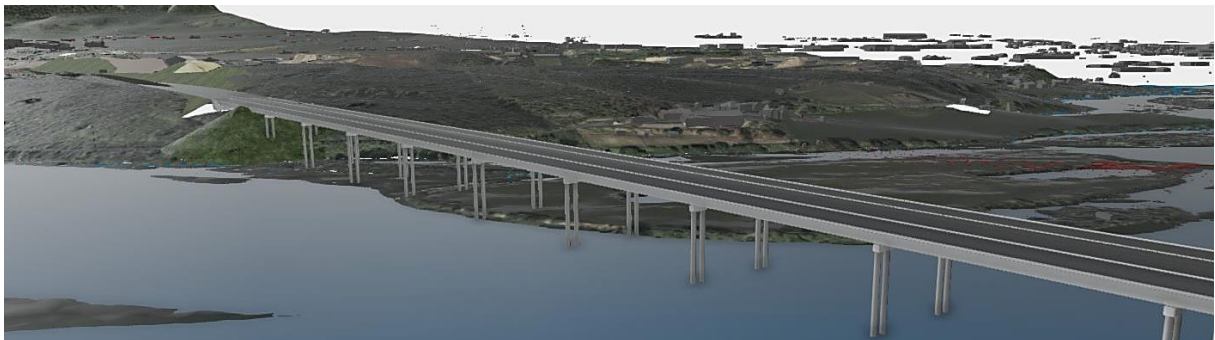
Figur 5-133 Bilde fra modell sett fra Kolberg som viser hvordan bru etter planprogramlinjen treffer land på Hovemosiden. Veilinje treffer elveskråningen mere skrått og vesentlig høyere enn ved justert linje. Dette kan gi et større område med inngrep som er eksponert mot elva.
