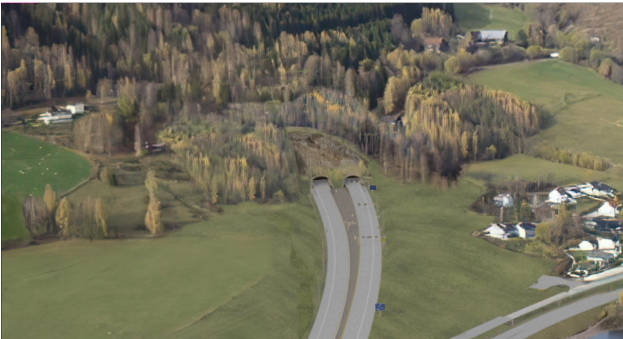
Figur 5-76 Bilde fra modell som viser påhugg, portaler og de store løsmassekjæringene ved portalen i Øyresvika.
