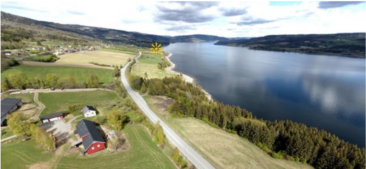
Figur 5-4 Bilde fra Birstrand og sett nordover. Plantet granskog langs Mjøsa. Eksisterende E6 ligger i hovedsak godt i terrenget, med mindre skjæring og fyllinger langs veien. (Dronebilde AF 2020)
