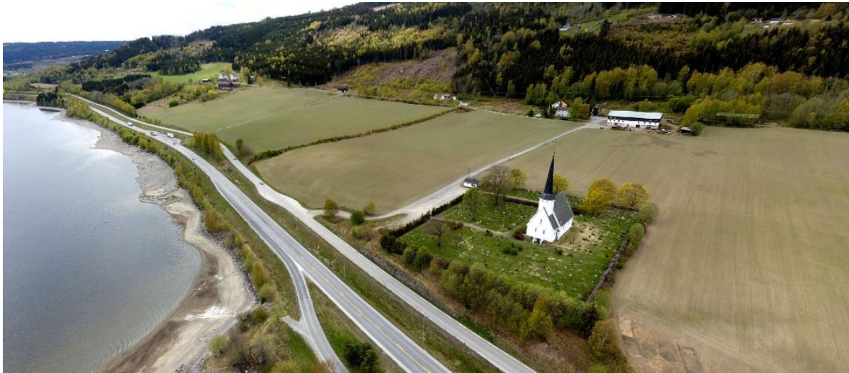
Figur 5-42 Bilde av området fra Røyne (gården oppe i lia til venstre i bildet) til Vingrom kirke. E6 ligger langs strandkanten med sparsomt med vegetasjon i strandlinja. På denne strekningen er det også lite vegetasjon langs eiendomsgrensene og landbruksarealene er svært åpne. (Dronebilde AF 2020)
