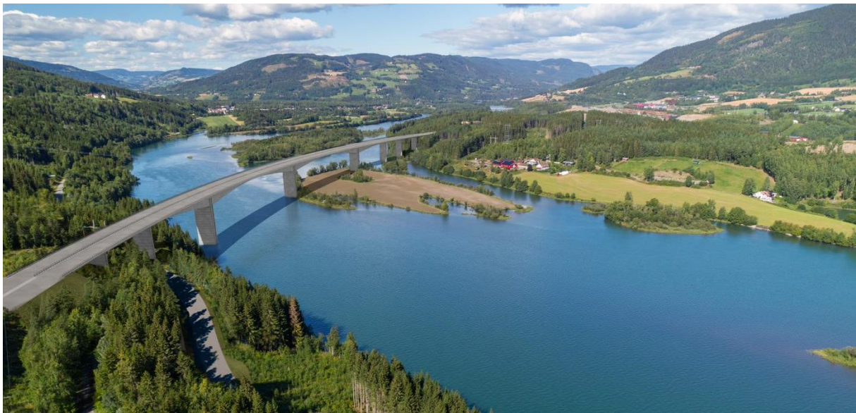
Figur 1-15. Lågen bru i kommunedelplanlinjen, fritt frembygg-bru
