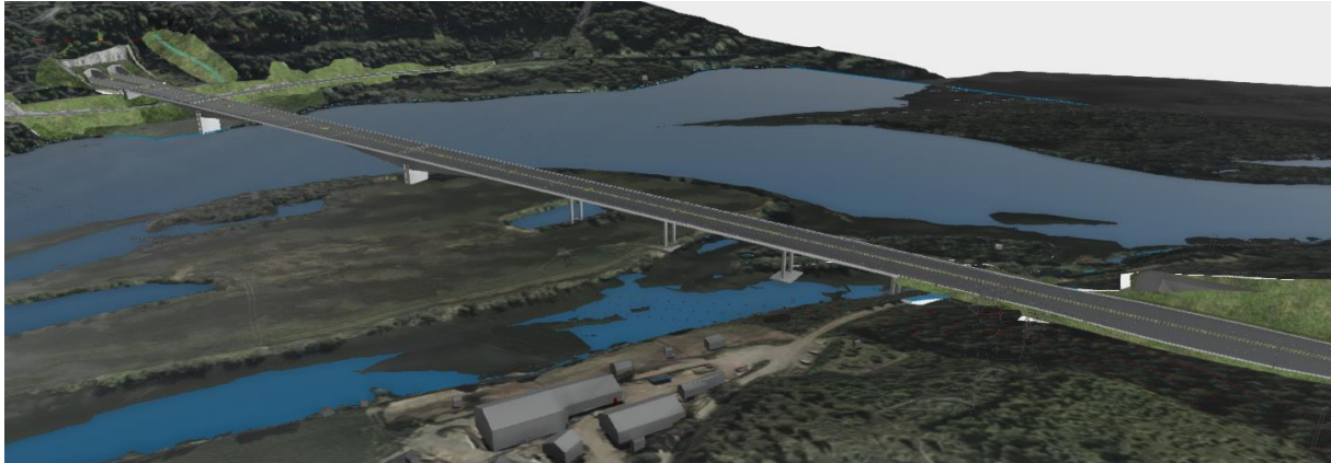
Figur 1-14. Lågen bru i justert linje, fritt frembygg-bru
