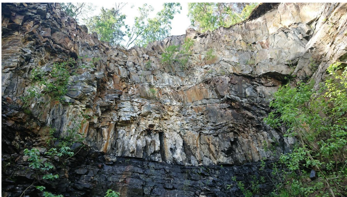
Figur 16: Skjæring i nedlagt steinbrudd ved Trosset. Øverst sandstein, over skiferlag (siltstein og svartskifer). Nederste lag er mørkt grunnet sig av grunnvann. Tydelig utfelling sees på deler av bergoverflaten.
