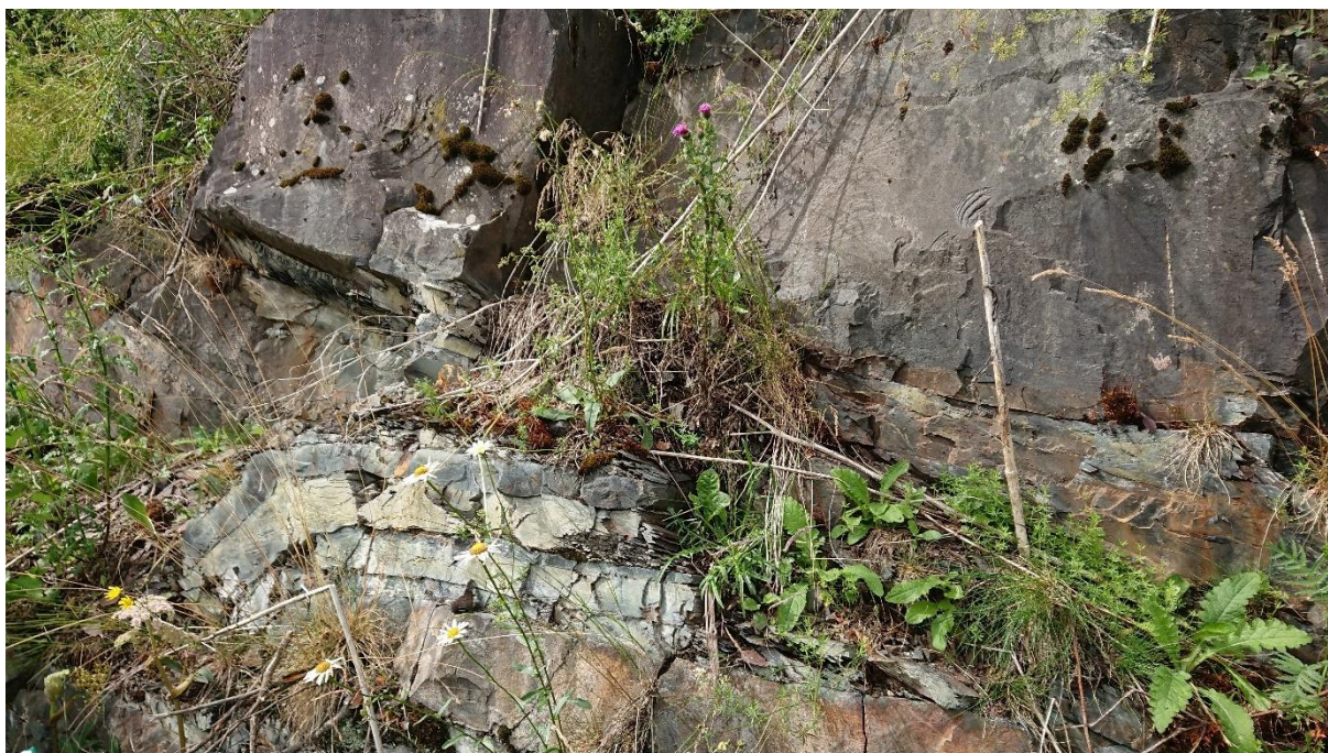
Figur 24: Ulike bergarter med svært ulik sprekkeavstand på lagdelingssprekker. Sandstein over antatt svartskifer og siltstein. Skjæring ved Fv 2540 Vingromvegen.
