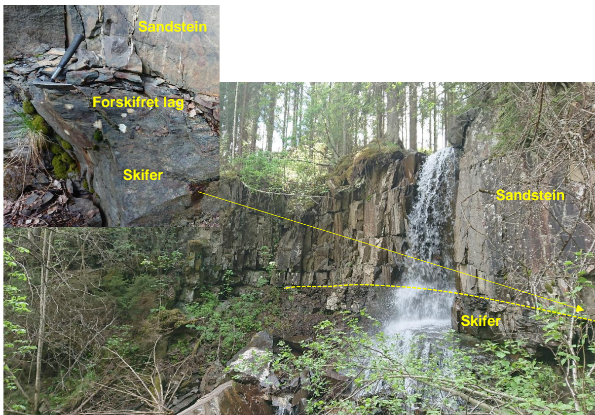
Figur 31: Blotning av berg ved Kollefall, rett vest for forkjæringen ved Trosset. Den øvre delen av bergveggen består av grov-middels blokkig sandstein, mens underliggende lag består av skifer og siltstein. Bergartsgrensen mellom sandstein og siltstein er tettere oppsprukket/forskifret, og utgjør et svakt lag i bergmassen.
