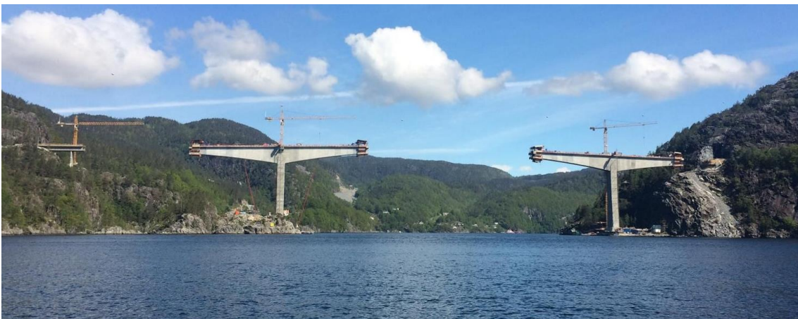
Bildet viser en FFB-bru i byggefase (Sandsfjordbrua)
