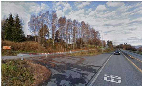
Figur 4-4. Nødsluse ved Paul A. Owens veg 171. (Foto: Google Maps Street View)
