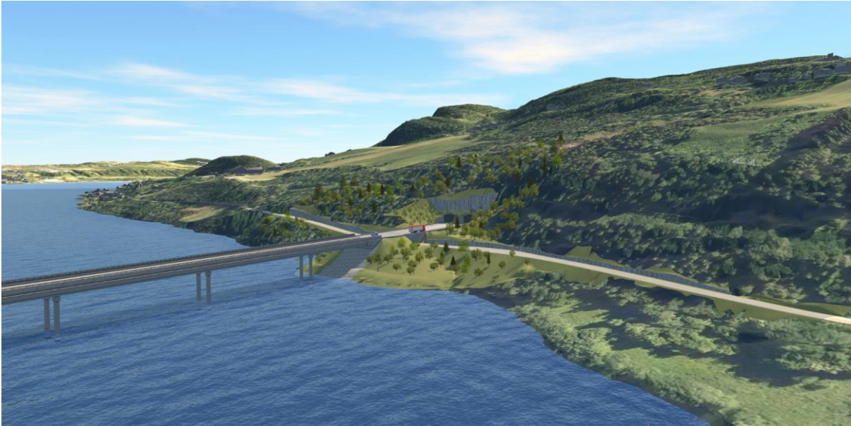
Figur 6-20. Portalområde på Trosset og overgang til bru over Lågen for planalternativ 1. Jørstadmovegen legges om og legges i kulvert under E6.
