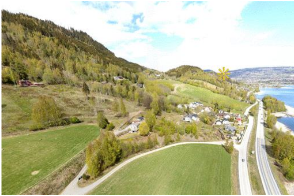
Figur 4-13. Tunnelen starter ved Øyresvika
