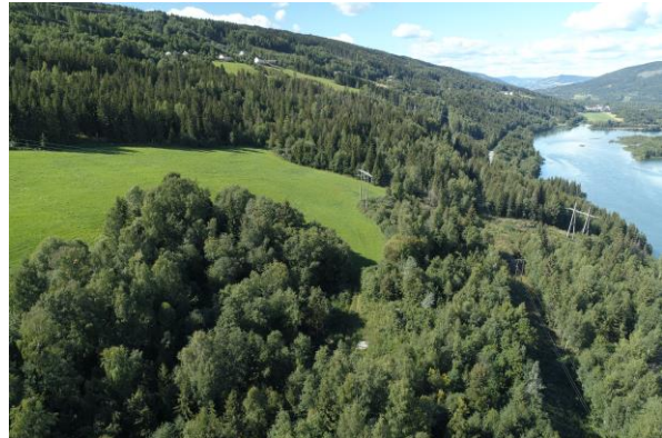
Figur 4-14. Tunnelen kommer ut ved Trosset
