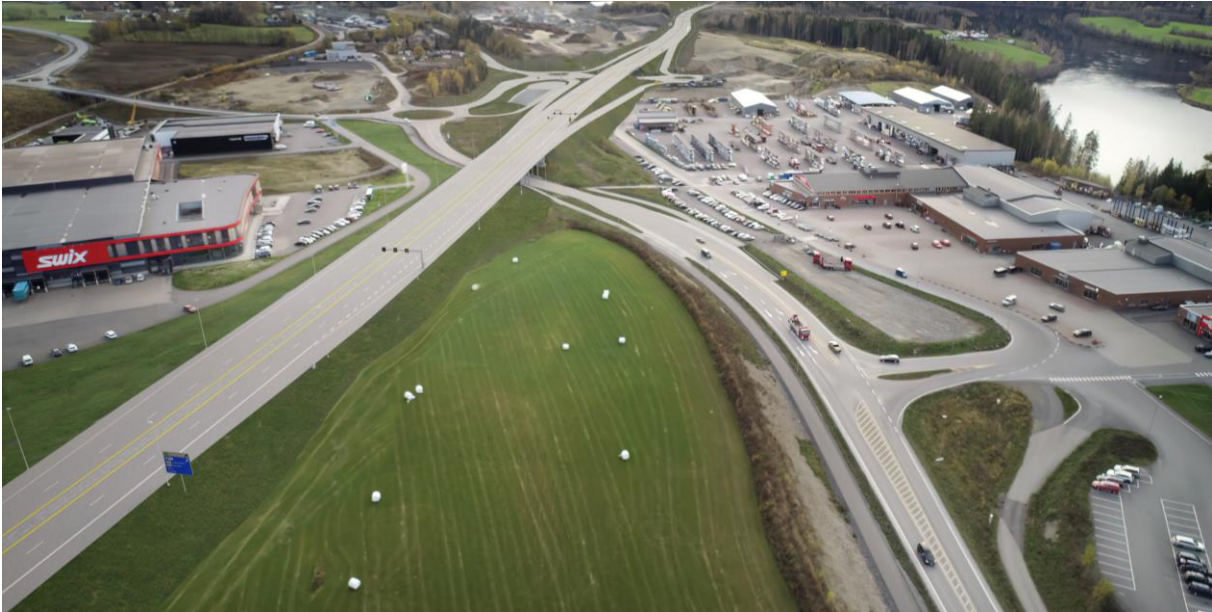
Figur 6-18. Storhove kryss midt sett fra nord, Vormstugujordet. Gausdal Landhandleri til høyre i bildet.
