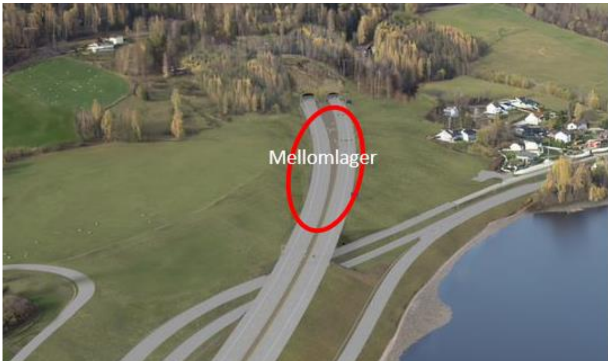
Figur 8-8. Midlertidig mellomlager i tilknytning til portalområdet ved Øyresvika.
