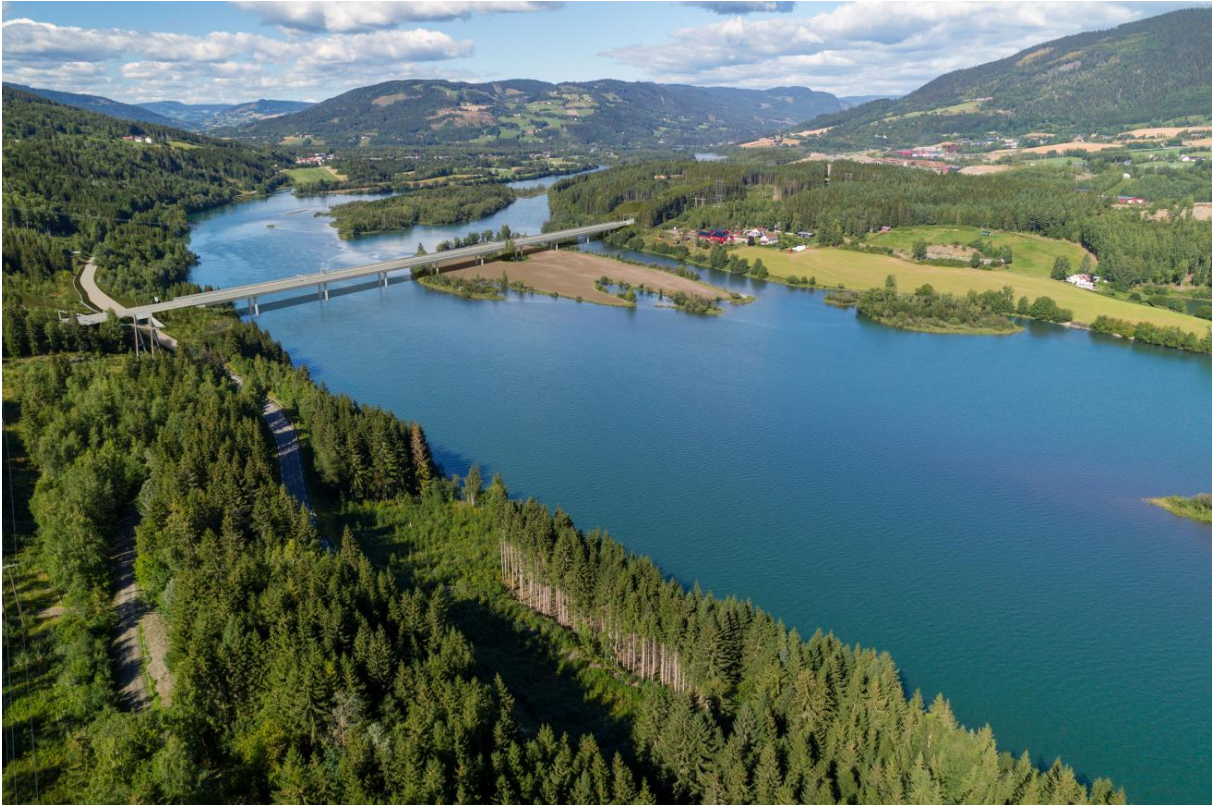
Figur 6-21. I planalternativ 1 reguleres en kassebru over Lågen. Brua er ca. 540 m lang, og veilinjen ligger ca. 15 m over høyeste regulerte vannstand.
