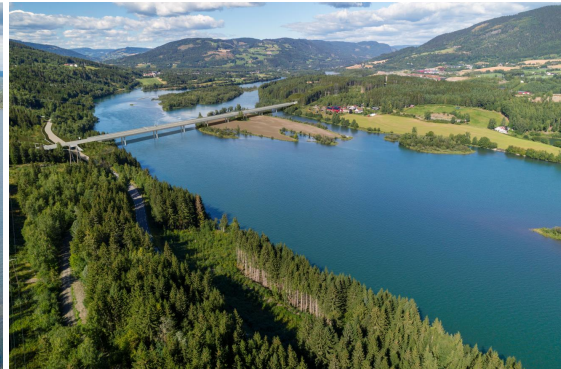
Justert linje med betongkassebru over Lågen
