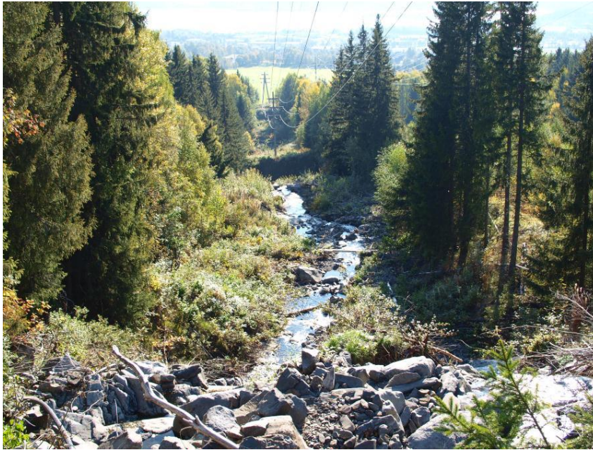
Bæla nedstrøms kryss Kringsjøvegen/Turthaugvegen NB. Strømmaster....
