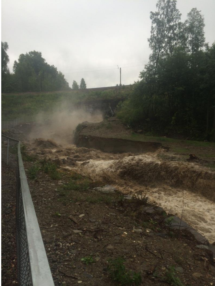
Nedre del, Jenbanekulvert og steinsatt elv
