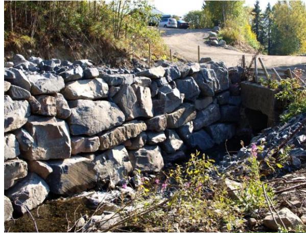
Øvre del Kringsjøvegen kryss Turthaugvegen. Punkt hvor Bæla gikk over Og ned Kringsjøvegen
