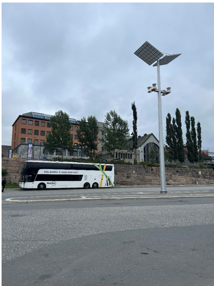
Figur 10 Eksisterende mur mellom øvre og nedre platå.
