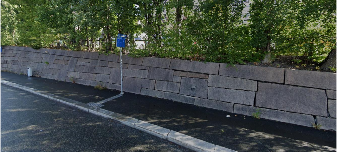
Figur 3.4. Bildet viser bruk av naturstein til kantstein og mur ved kollektivterminalen. Kilde: Google Streetview.
