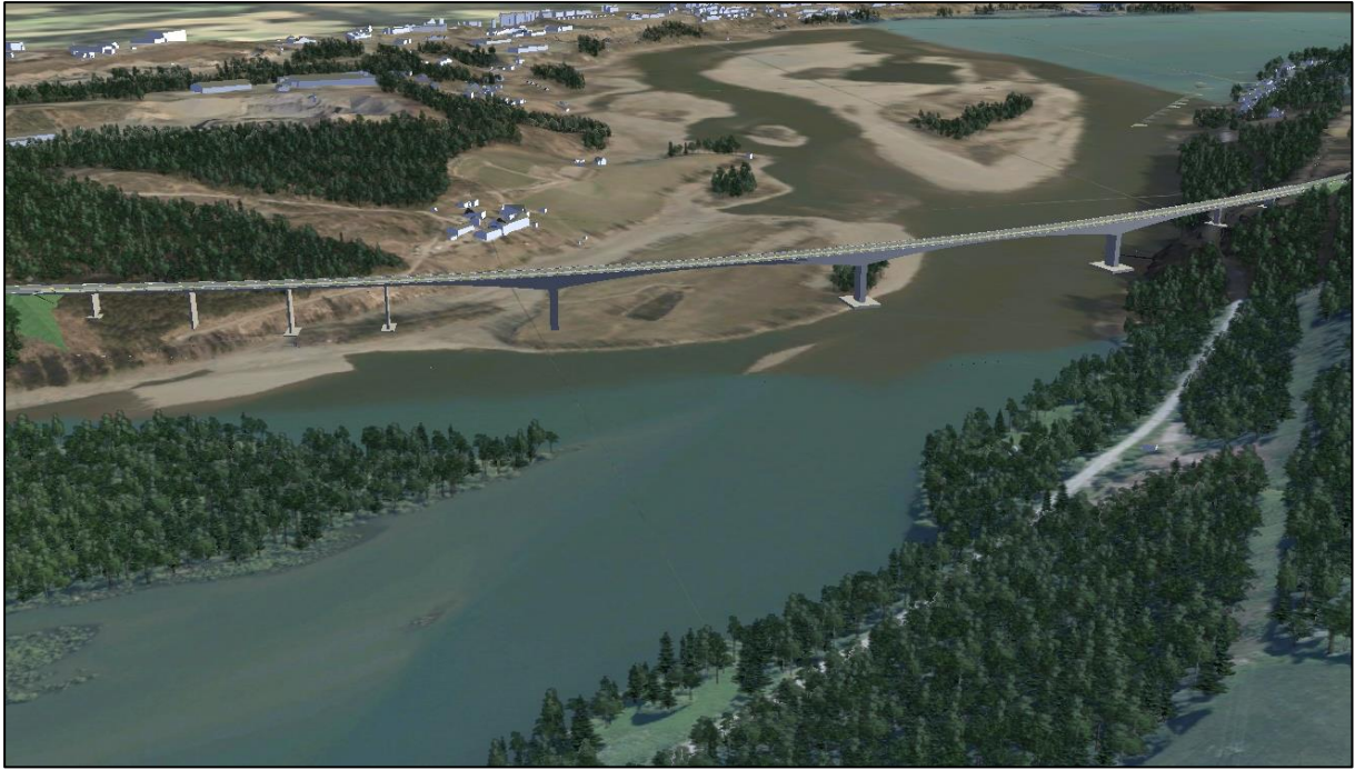
Figur 5-10 Ny bru over Lågen ved Våløya sett nordfra mot Hovemoen gård og Lillehammer by.
