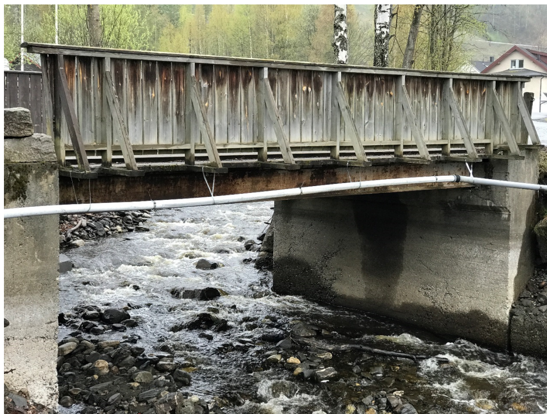
Figur 5 – Bru ved utløpet til Mjøsa (bildet tatt fra nedstrøms side)
