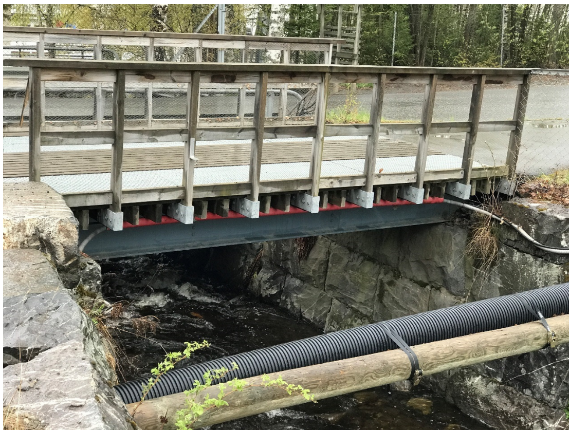
Figur 9 - Gangbru ved Dampsagvegen (bildet tatt fra oppstrøms side)
