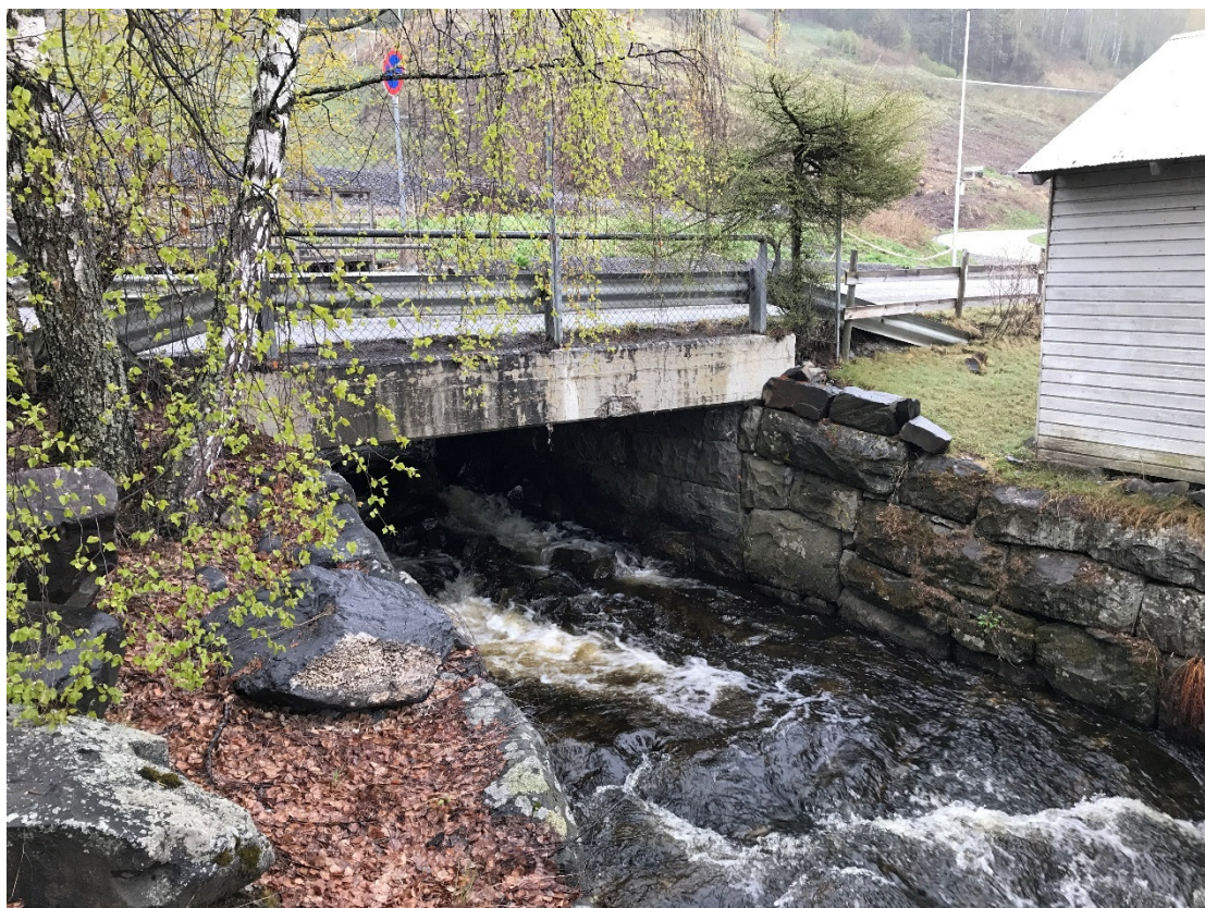
Figur 8 - Bru Dampsagvegen (bildet tatt fra nedstrøms side)
