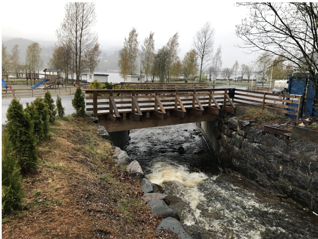
Figur 6 – Trebru ved camping (bildet tatt fra oppstrøms side)
