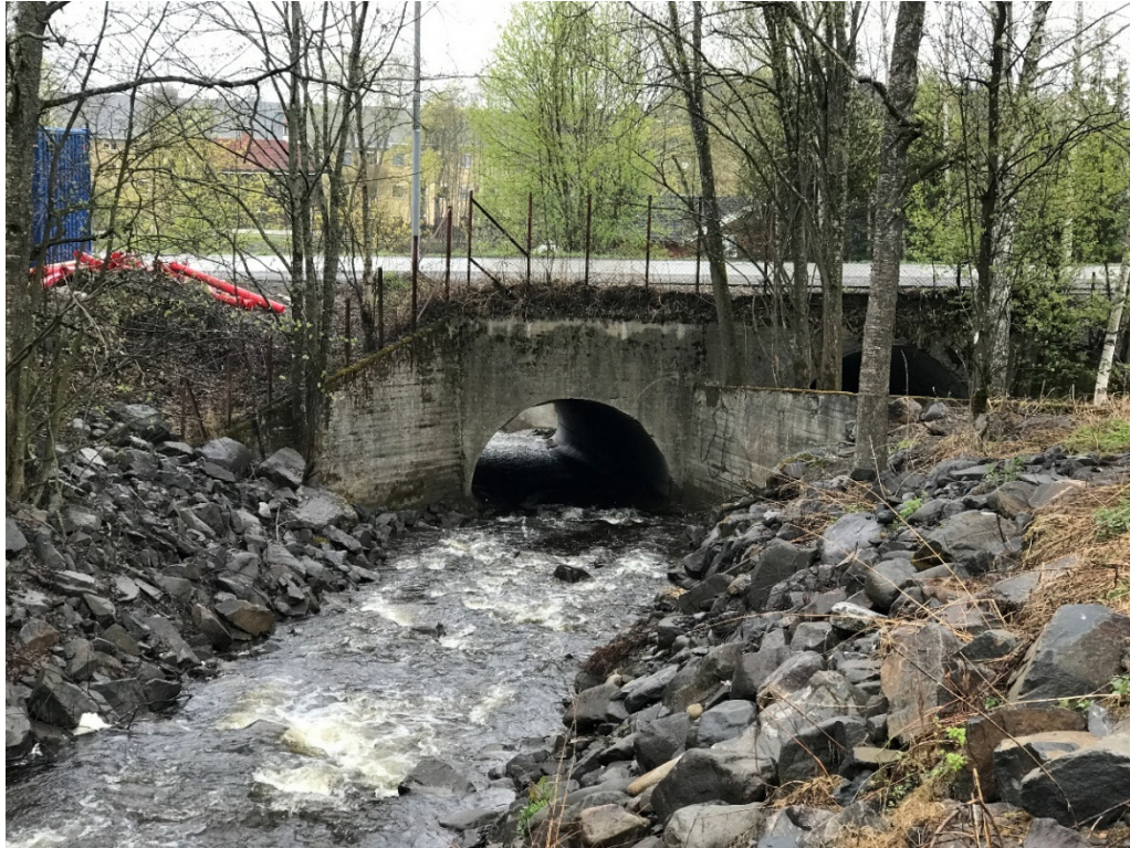
Bilde 21 kulverter under Fredrik Colletts veg
