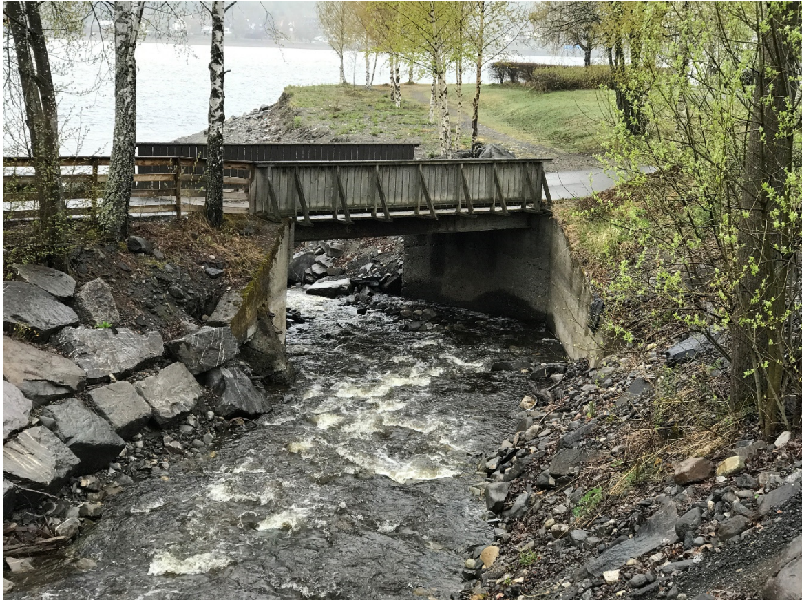
Bilde 44 gang- og bilbro 2 Lillehammer camping
