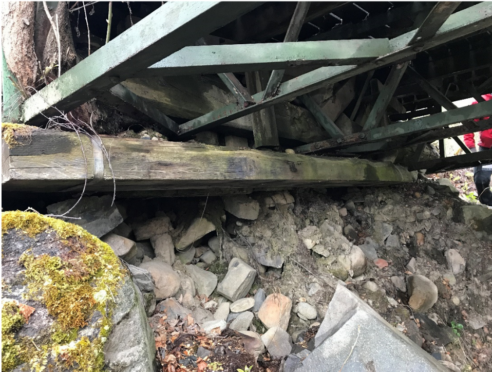
Bilde 17 utraste masser under fundament
