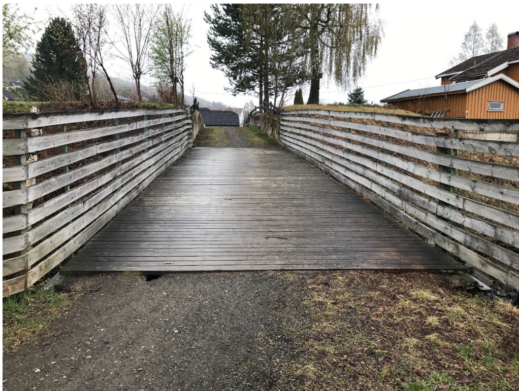
Bilde 20 rekkverk og brodekke
