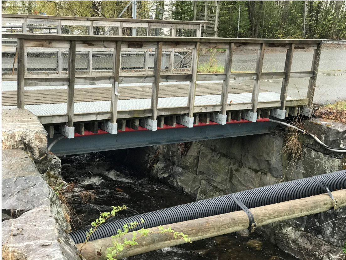
Bilde 36 gangbro Dampsagvegen
