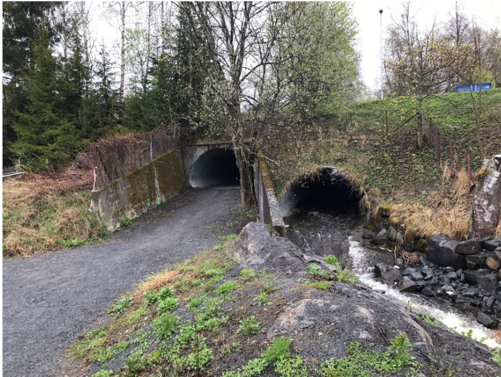
Bilde 22 kulverter under Fredrik Colletts veg
