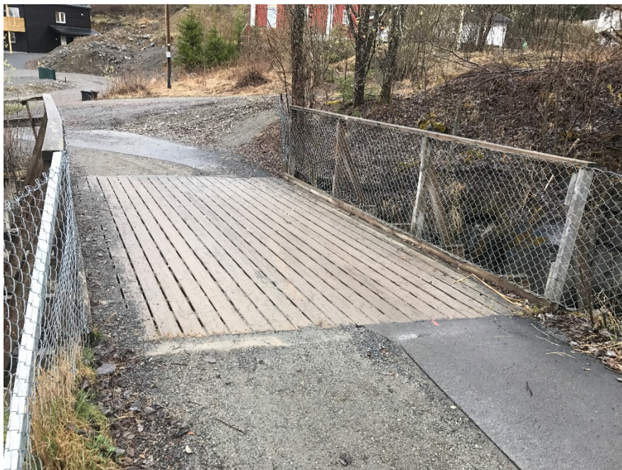
Bilde 9 slitasje på brudekke
