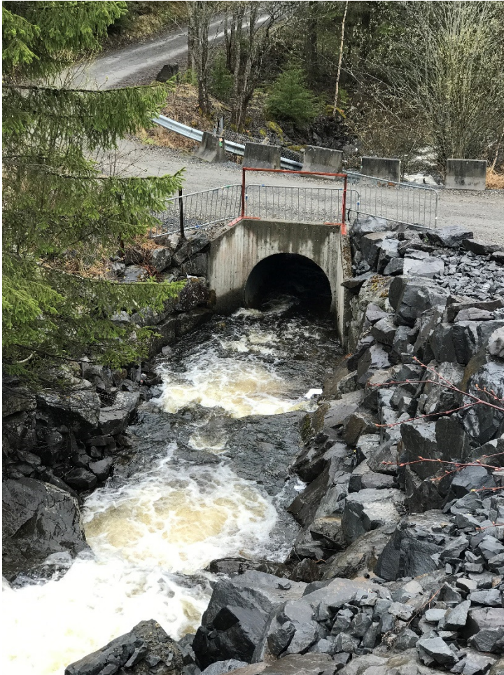
Bilde 11 kulvert under Høstmælingsvegen
