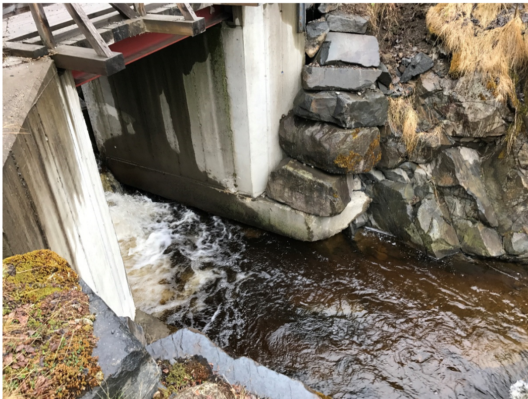
Bilde 5 undergraving av fundament
