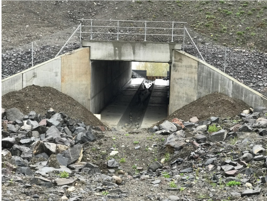
Bilde 34 ny kulvert under jernbane
