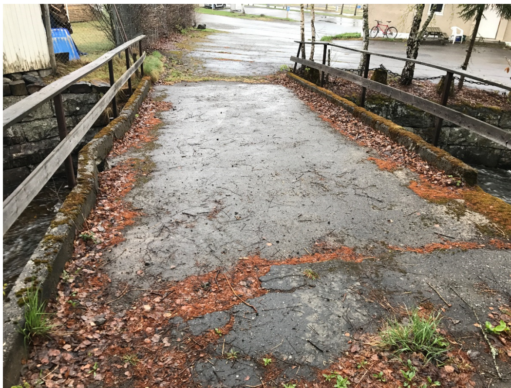
Bilde 42 bro nedenfor Dampsagevegen
