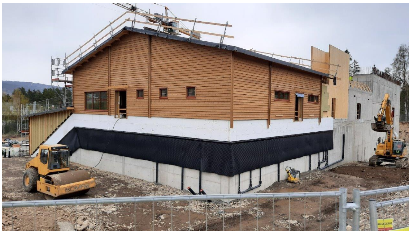
Figur 14 Lillehammer vannverk Hovemoen under bygging, våren 2020 (foto: Lars Philip Olausen)
