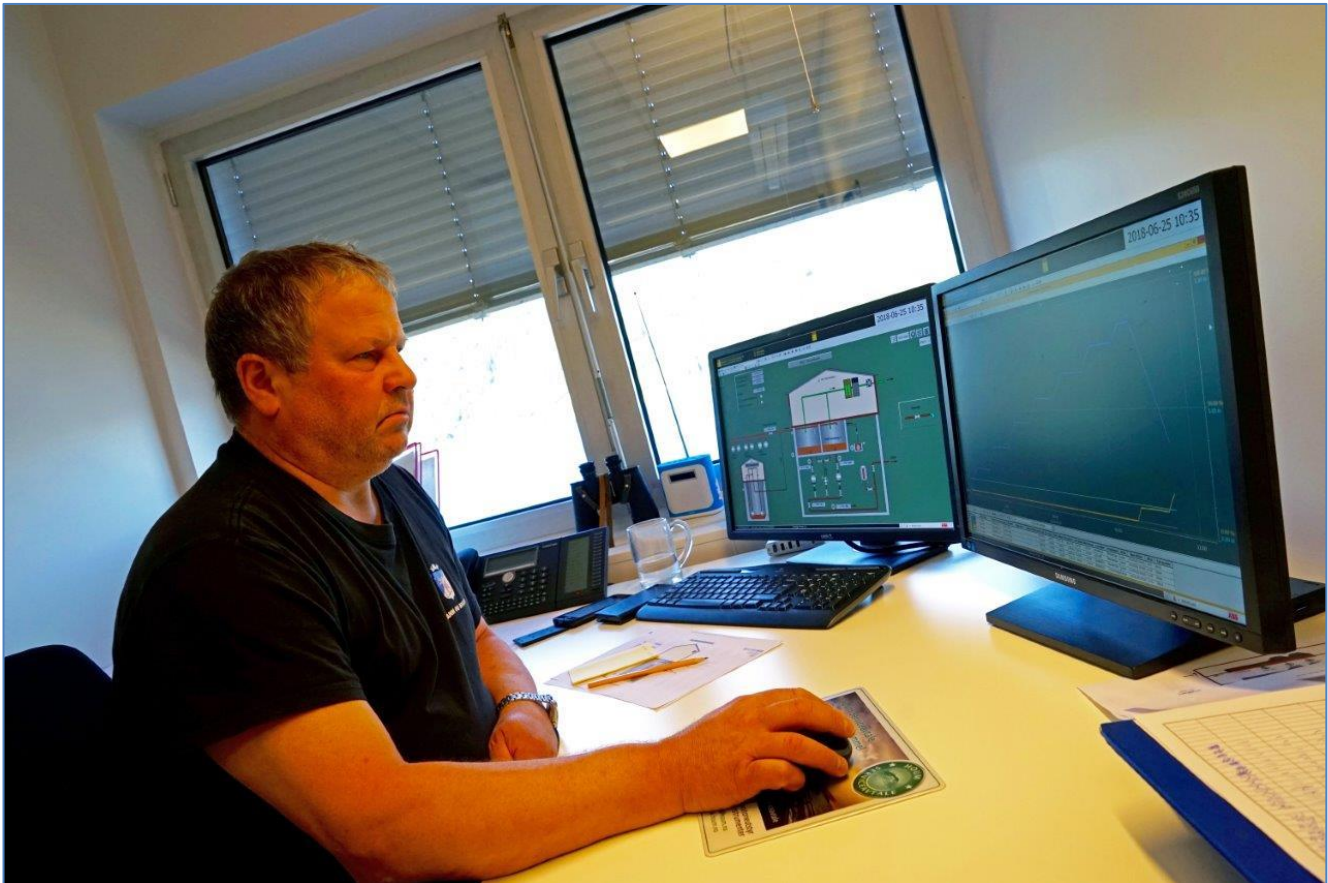
Figur 10 I arbeid ved driftscentralen for driftskontrollanlegget
