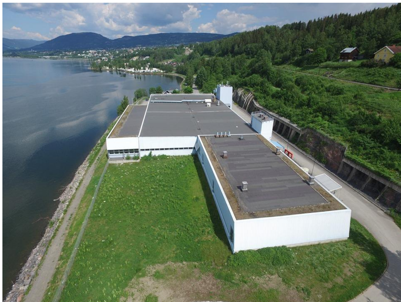
Figur 21 Lillehammer renseanlegg, i retning Lillehammer sentrum (foto: Rune Ludvigsen)
