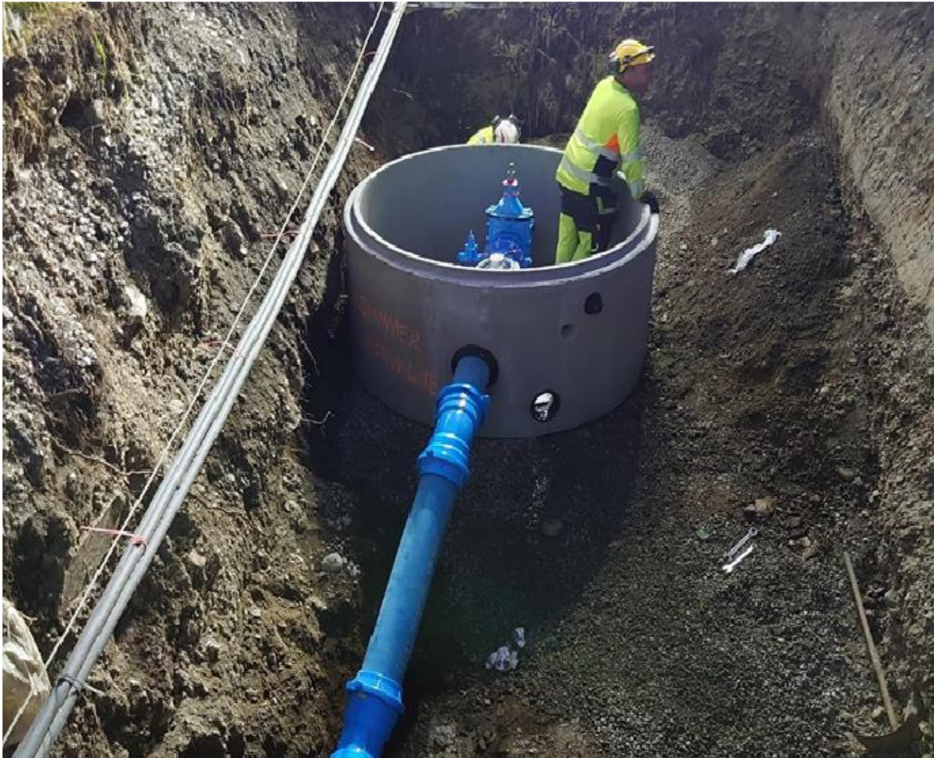
Figur 36 Servicelaget monterer første sonevannmåler i Vingnesvika sommeren 2020 (foto: Vidar Olsen).
