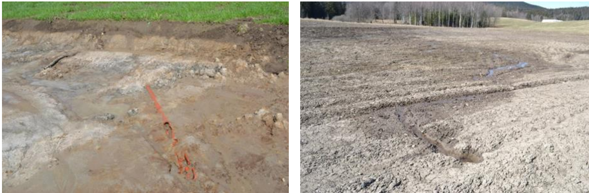
Figur 3-10. Avgravde grøfter på Bogstad, Oslo (til venstre), brudd på grøfterør som gir utlekking av vann over stort område på tilbakestilt jordbruksareal på Bogstad, Oslo (til høyre) (Foto: Trond Knapp Haraldsen).
