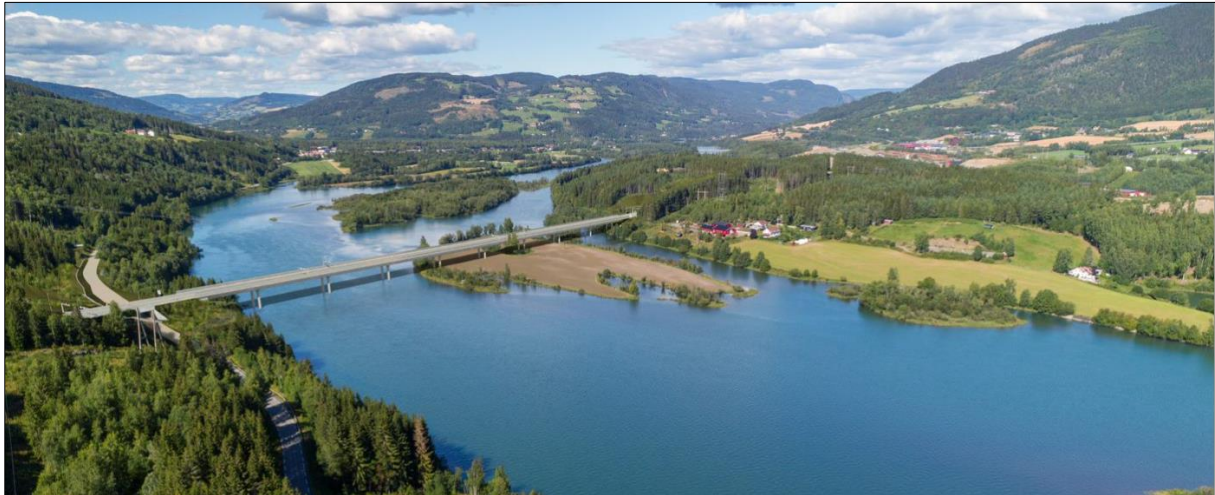
Figur 13. Lågen bru i justert linje, betongkassebru.
