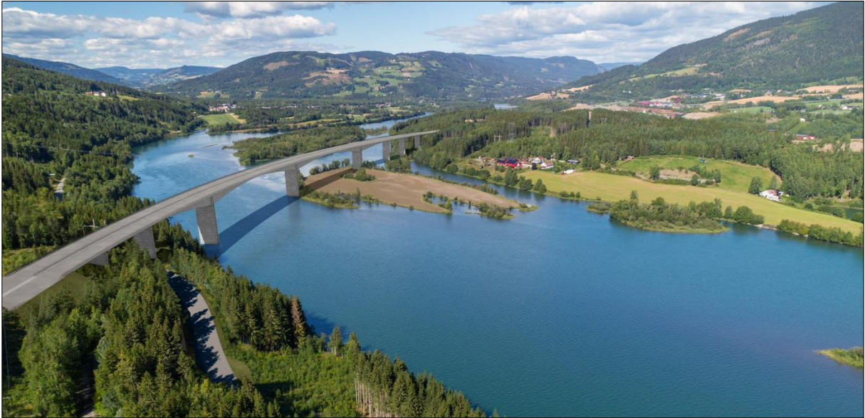
Figur 14. Lågen bru i kommunedelplanlinjen, fritt frembygg-bru.
