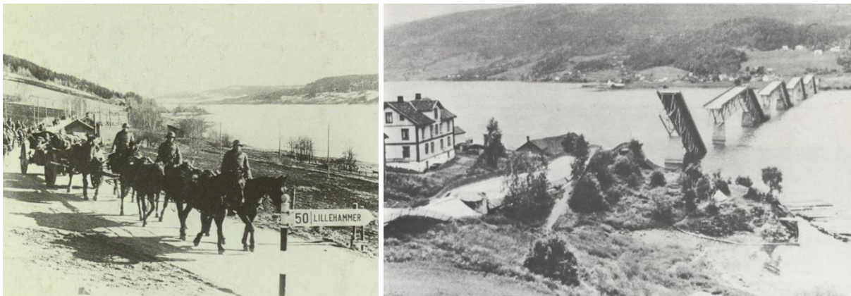
Figur 4-5 Tyske styrker på vei mot Lillehammer april 1940 til venstre. Til høyre Vingnesbrua som ble sprengt natt til 22. april [25]
