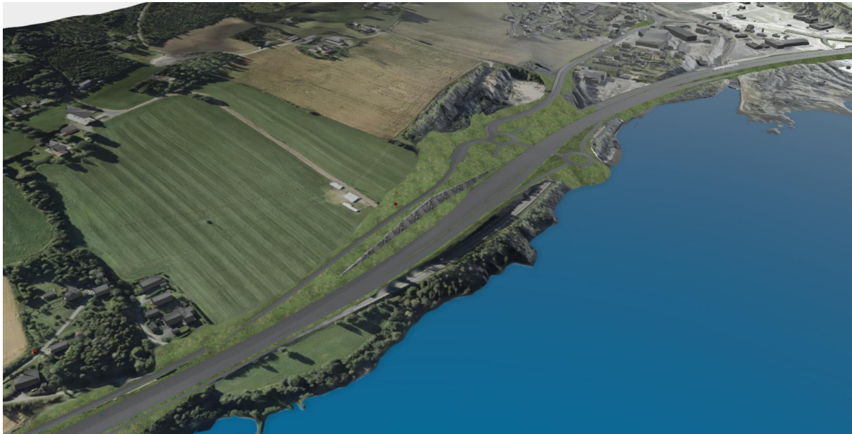
Figur 1-5. Vingrom kryss sør, ved Jevne
