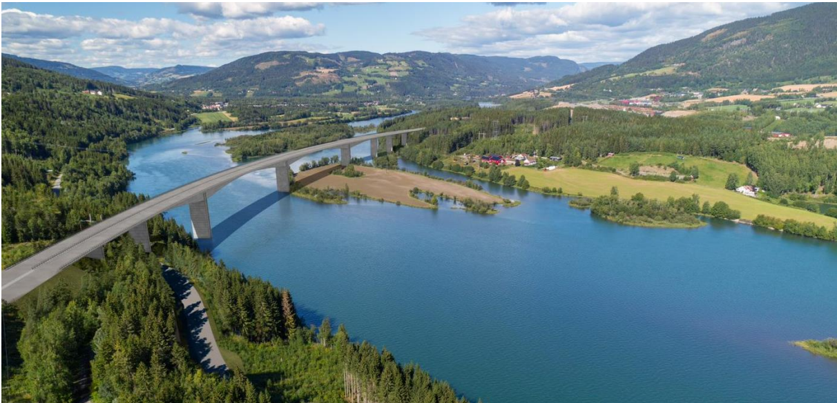
Figur 1-15. Lågen bru i kommunedelplanlinjen, fritt frembygg-bru
