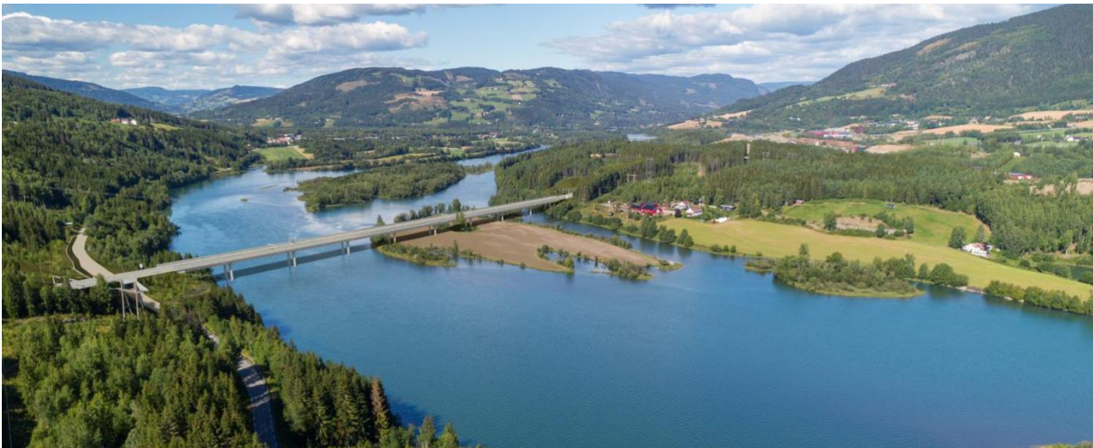
Figur 1-13. Lågen bru i justert linje, betongkassebru
