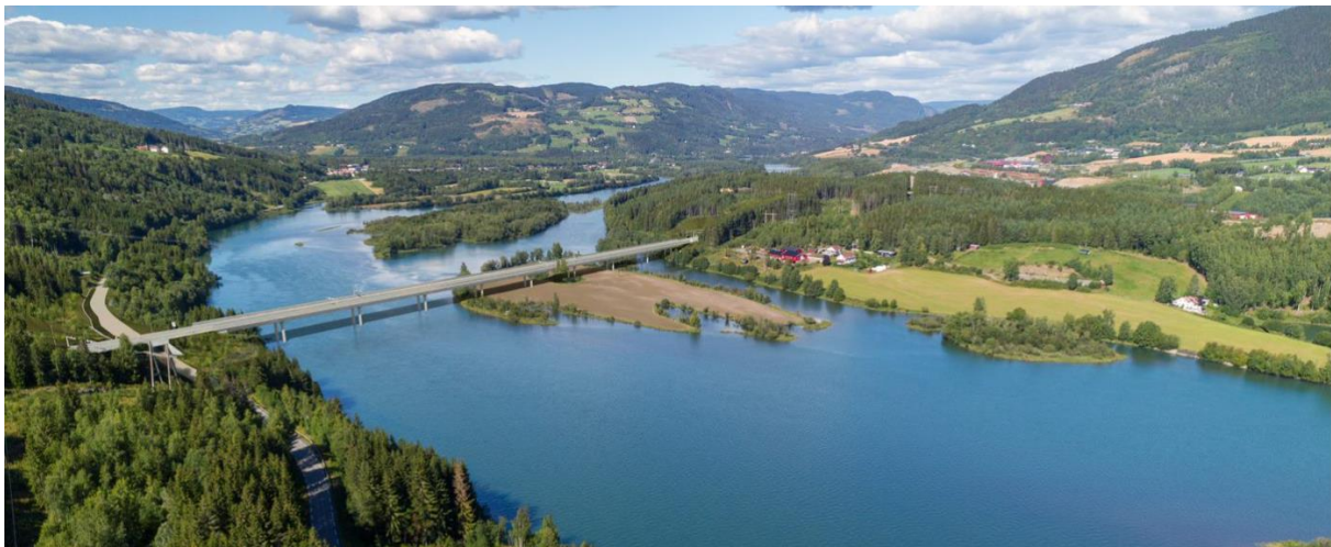
Figur 1-13. Lågen bru i justert linje, betongkassebru
