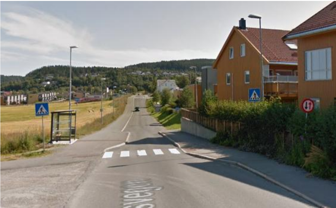
Figur 7 Timeglasstopp i Granåsvegen i Trondheim
