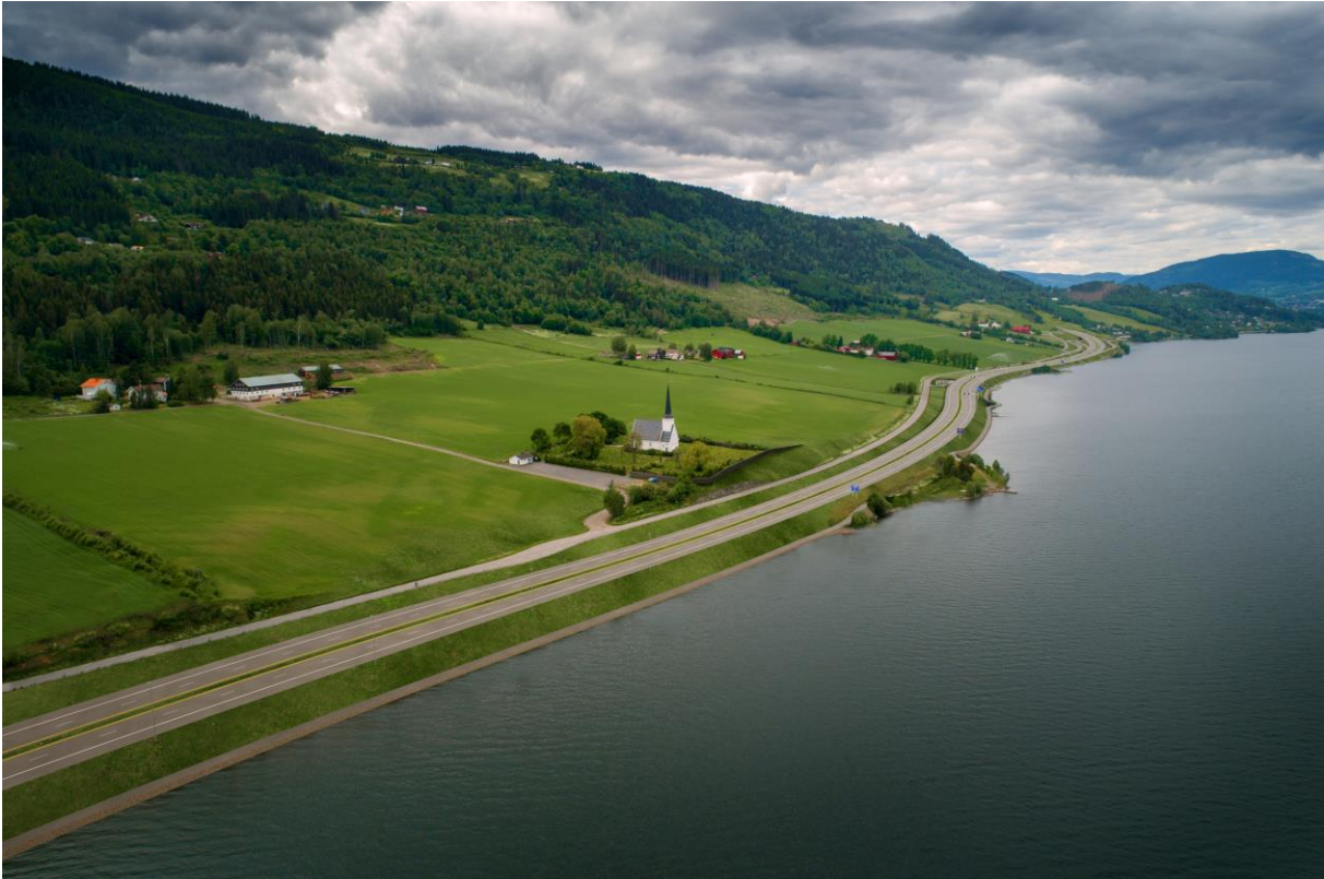
Figur 4. Illustrasjon av strekningen Røine – Øyresvika. Vingrom kirke midt i bildet og portalområdet i Øyresvika er til høyre i bildet
