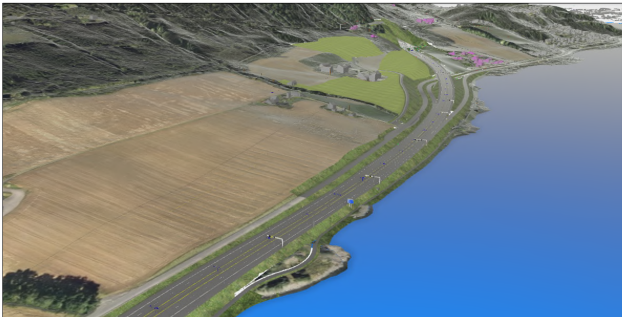
Figur 9. Veilinjen mellom Hov og Øyresvika, med tursti i strandsonen.
