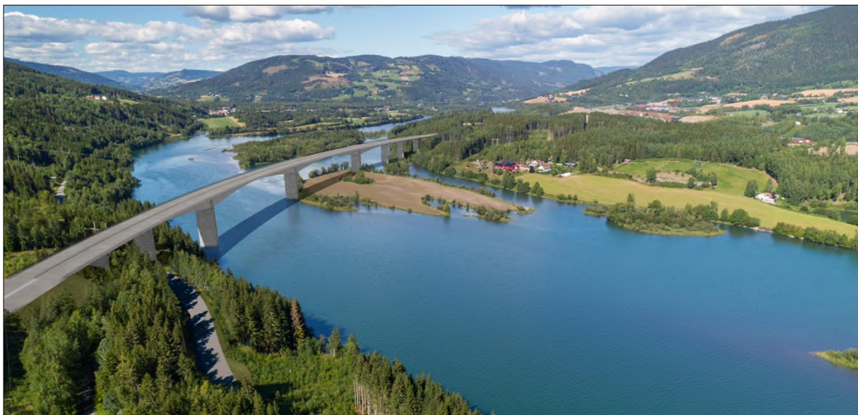
Figur 14. Lågen bru i kommunedelplanlinjen, fritt frembygg-bru.
