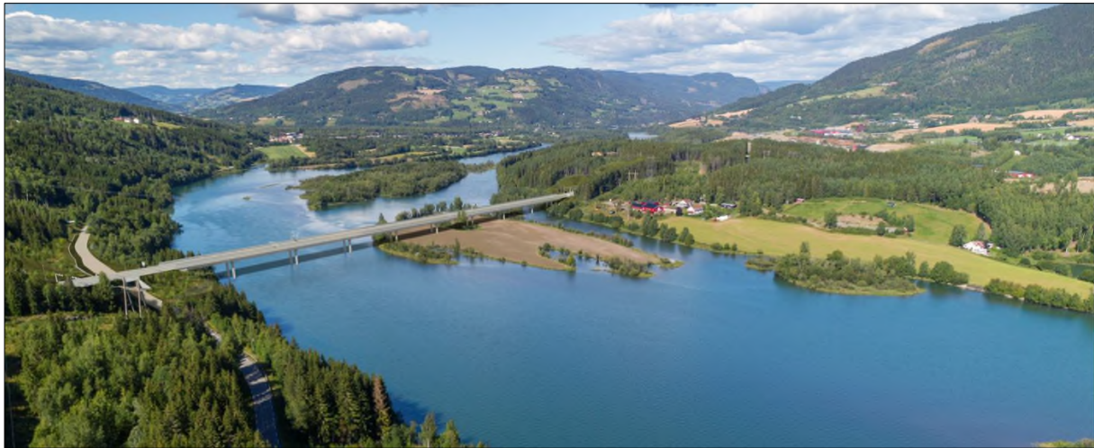
Figur 13. Lågen bru i justert linje, betongkassebru.
