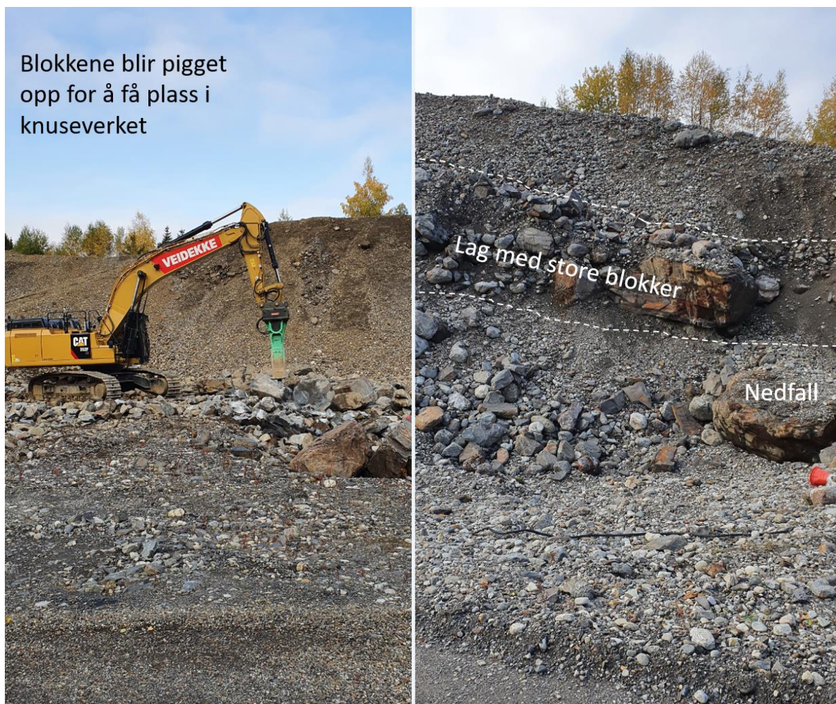
Figur 4-3. Grus som ligger i søndre del av uttaket inneholder et lag med store blokker, bildene er tatt like sør for motorcrossbanen (Figur 4-2).
