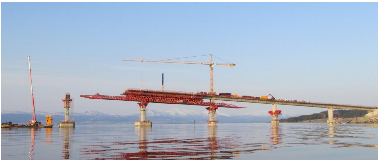
Forskalingsvogn på Tresfjordbrua (bilde fra SVV)
