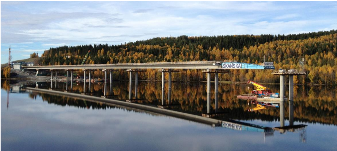
Figur 2-33 Gulli bru under bygging
