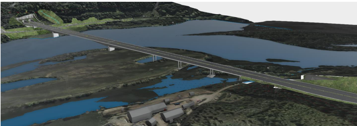
Figur 1-14. Lågen bru i justert linje, fritt frembygg-bru
