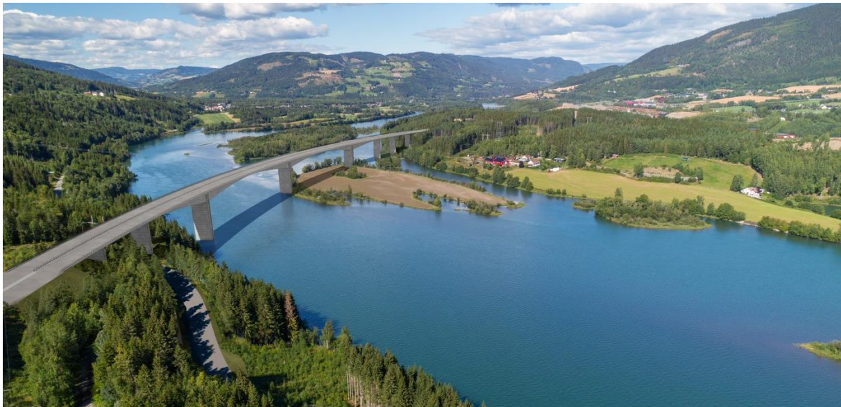
Figur 1-15. Lågen bru i kommunedelplanlinjen, fritt frembygg-bru
