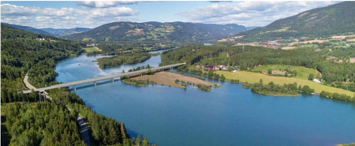
Figur 1-6. Lågen bru i justert linje, betongkassebru
