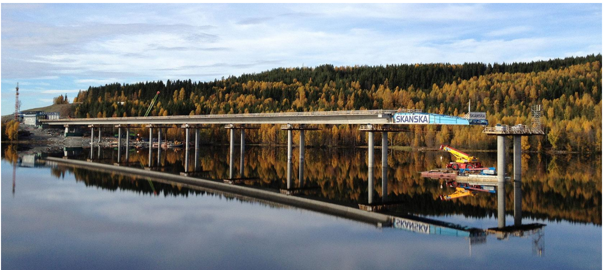
Figur 4-6. Overbygning skyves på plass - Gulli bru (kassebru) under bygging
