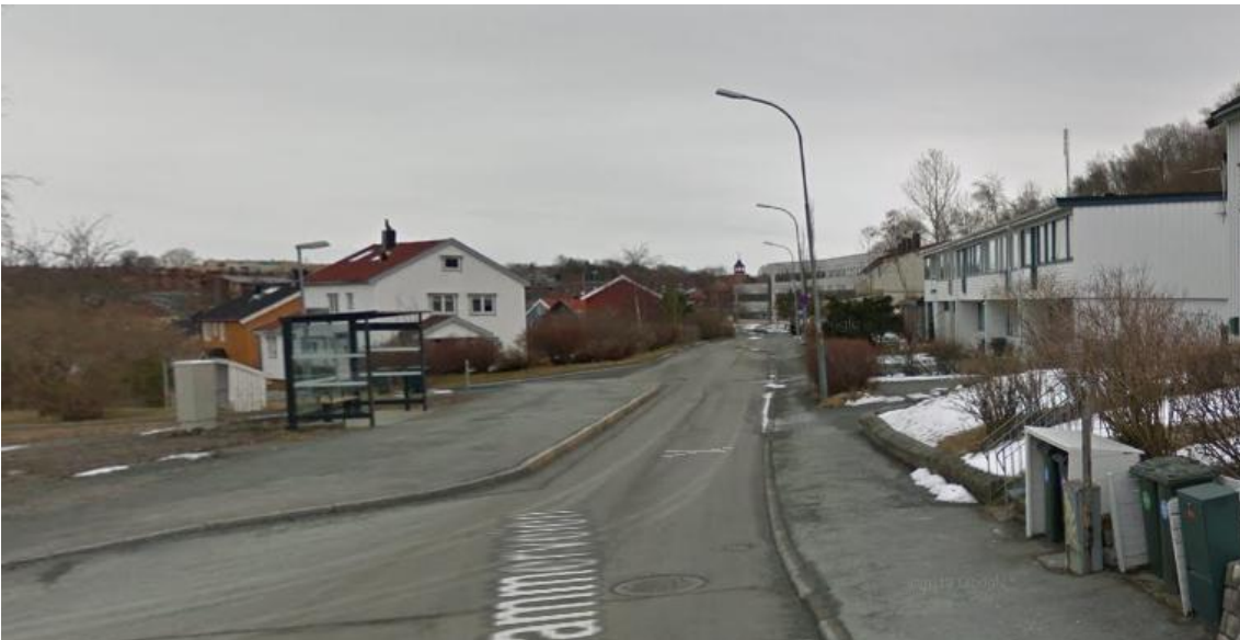
Figur 8 Holdeplass 1 med ensidig innsnevring, Ladehammerveien i Trondheim
