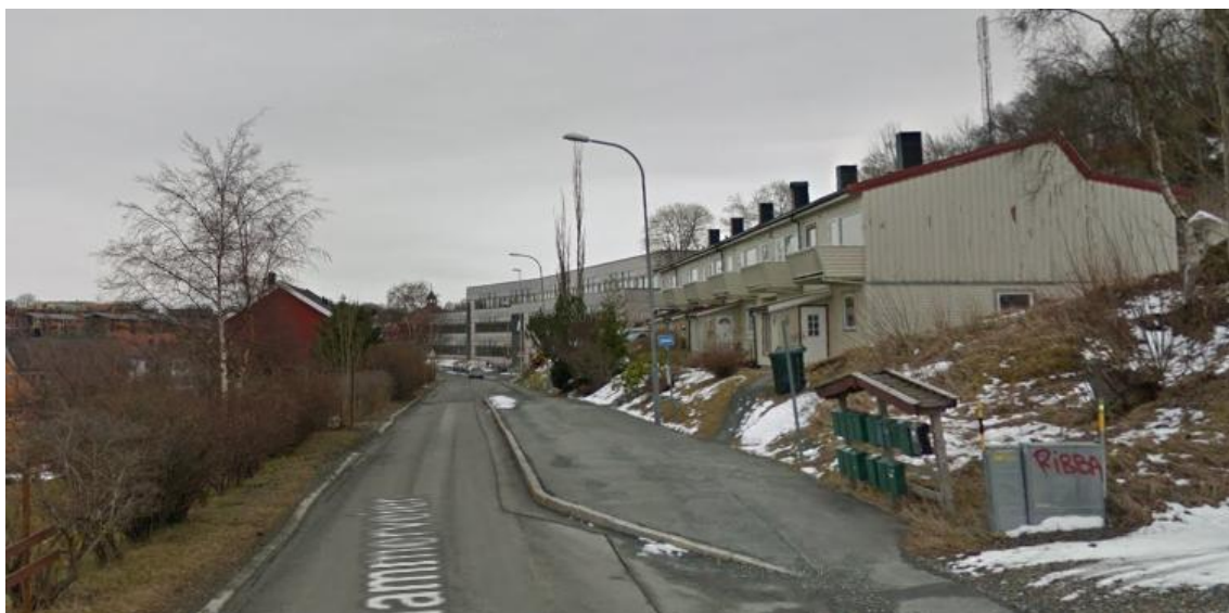
Figur 9 Holdeplass 2 med ensidig innsnevring, Ladehammerveien i Trondheim
