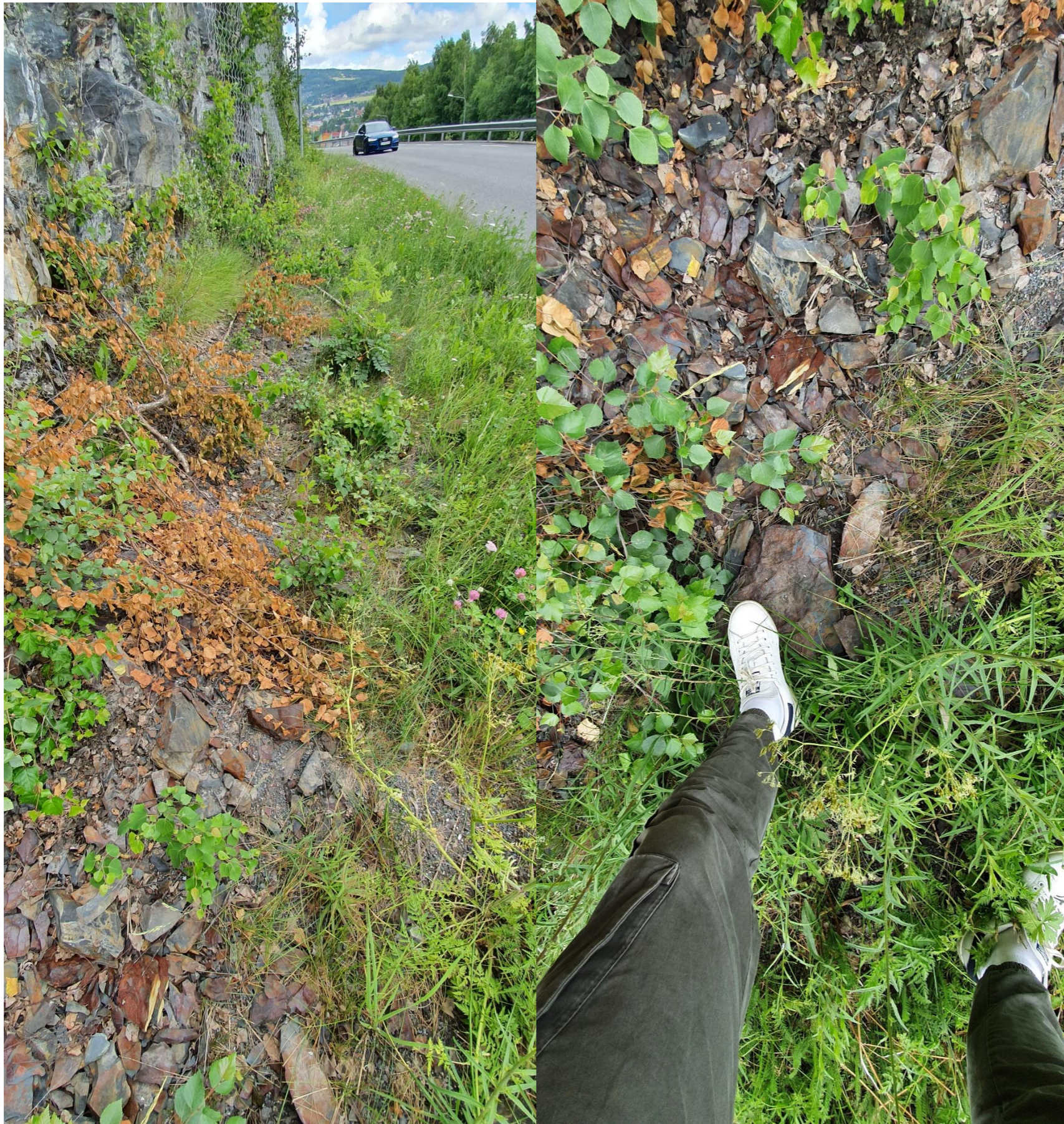
Figur 27. Parti G. Nedfall i grøft.
