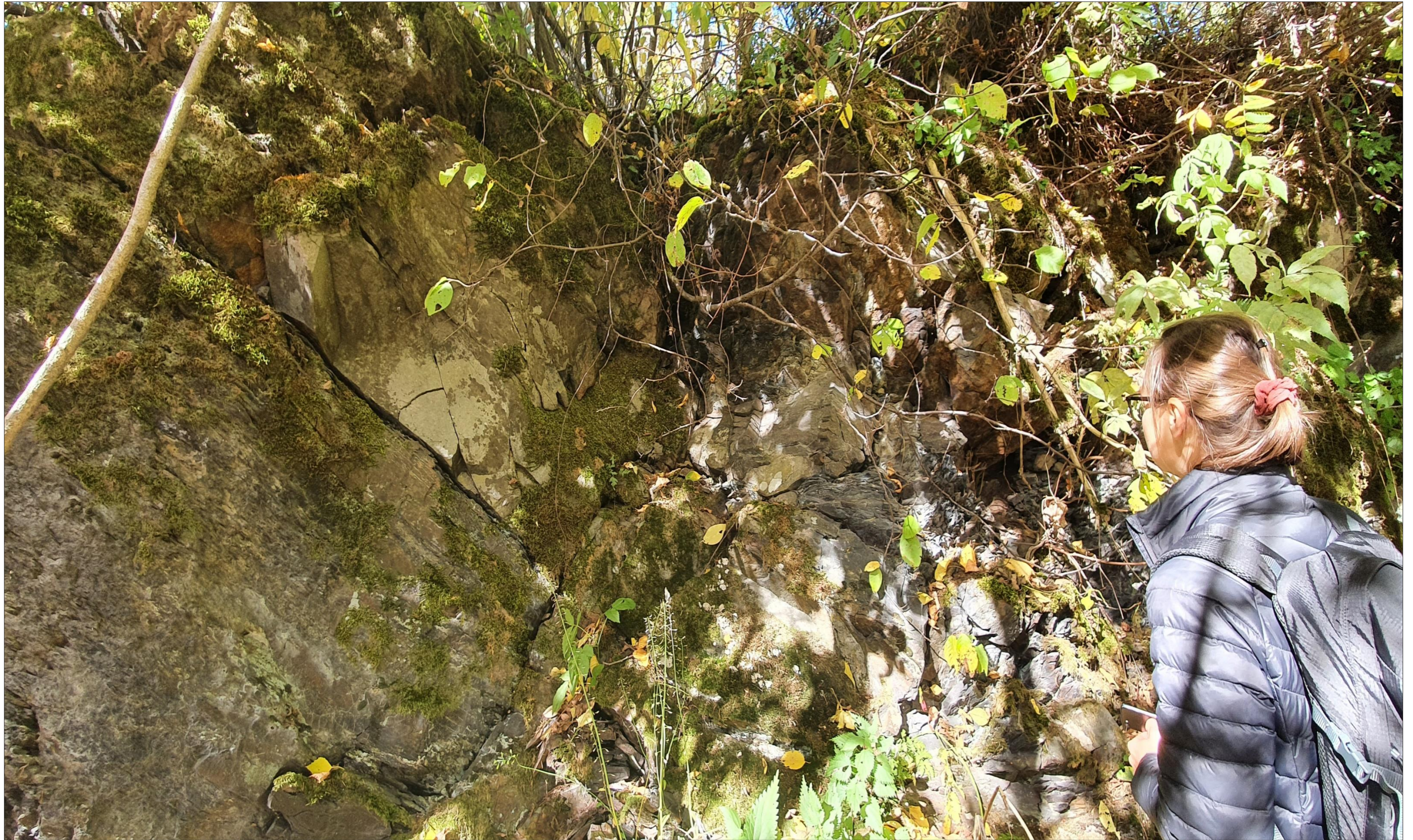
Figur 8. Parti B. Noen mindre bergblotninger med høyde på opptil 3 m er observert, disse har usikrede blokker som potensielt kan føre til steinsprang. Se beskrivelse i kap. 3.
