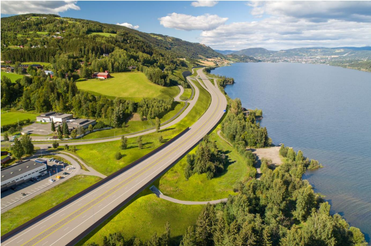
Figur 6-9. Vingrom kryss nord ved Ullhammeren. Mot Vingrom sentrum er det regulert langsgående støyskjerm sør for kulvert og støyvoll nord for kulvert. Mot Vingromdammen reguleres langsgående støyskjerm.
