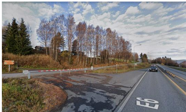
Figur 4-3. Nødsluse ved Paul A. Owens veg 171. (Foto: Google Maps Street View)
