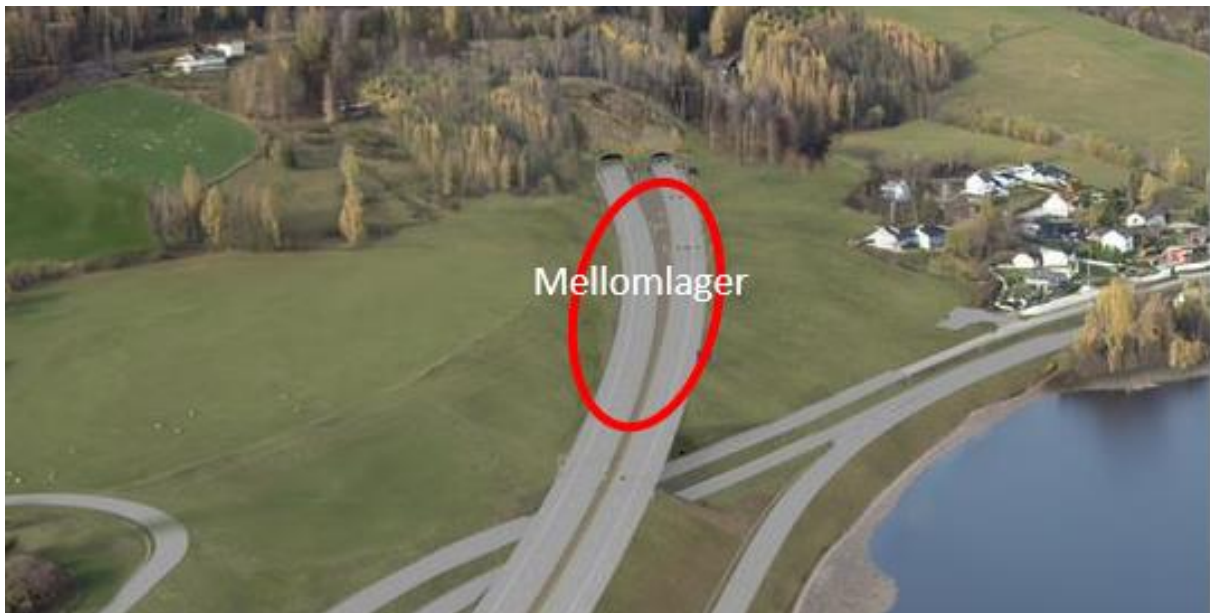
Figur 8-9. Midlertidig mellomlager i tilknytning til portalområdet ved Øyresvika.
