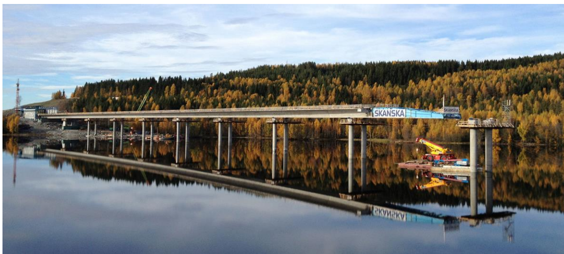
Figur 8-5. Eksempel på lanseringsmetoden, Gulli bru over Glomma ved Kongsvinger.
