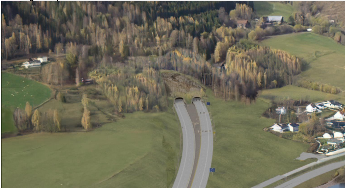
Figur 6-19. Forskjæring og portalområde Øyresvika.
