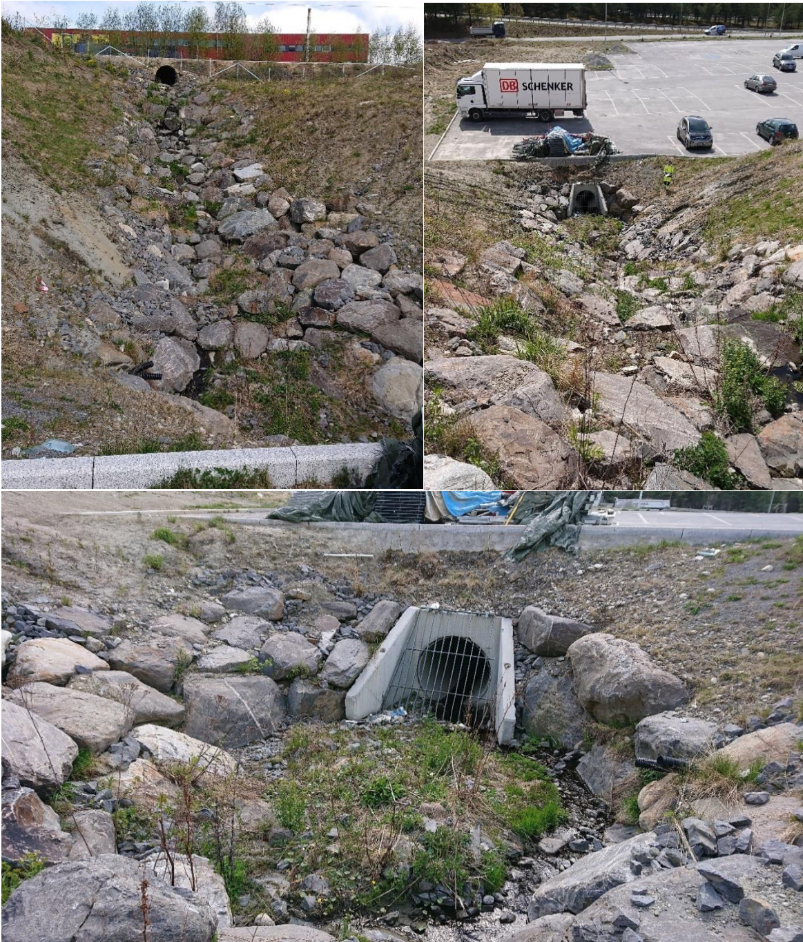
Figur 4.82 (Pkt. F12) Den åpne delen av bekketraseen til "Skikstadbekken" som går ned mot inntaket ved parkeringen på Biltema-tomta ble utført i forbindelse med utbyggingen av Biltema. Samtidig ble bekkelukkingen forlenget oppover ved etablering av parkeringsplassen. Bildet øverst til venstre er tatt fra inntaket og opp mot utløpet under jernbanen. Lukkingen videre krysser E6 og munner ut i Bæla nedstrøms E6. På nederste bilde ses mye avlagret masse ved inntaket oppstrøms p-plassen til Biltema.
