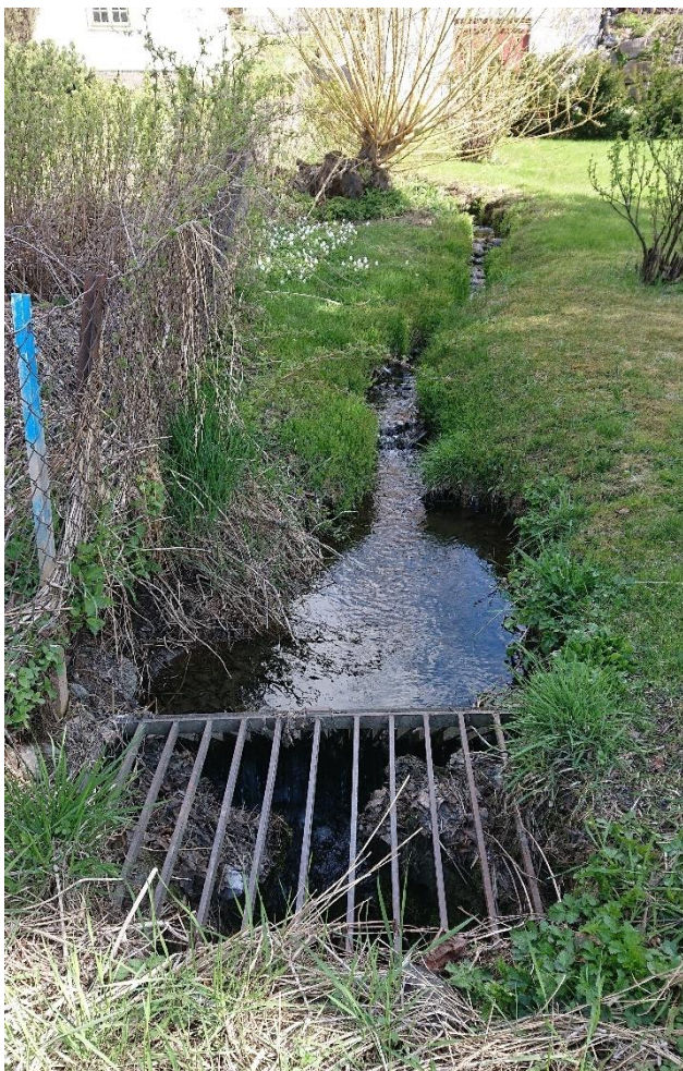
Figur 4.77 (Pkt. F8) Inntak for lukking av bekkeløp (Smestadbekken) under Gudbrandsdalsvegen sør for Lundebekken. Nord for Vargstad vgs. er det en liten bekk (opphav ukjent). Denne krysser Gudbrandsdalsvegen ved eiendommen Vargstadvegen 12. Bildet er tatt fra Gudbrandsdalsvegen ved eiendommen Vargstadvegen 12 og viser inntak rett oppstrøms g/s-veg langs Gudbrandsdalsvegen. Lukkingen fortsetter ned Landbruksvegen til Industrigata. Her går den sammen med øvrig OV-nett i området og munner etter hvert ut i bekkelukkingen til Lundebekken i Sannom. Ved sør-vestre hjørnet av gamle Terrina-bygget (Industrigata 50) er den tilknyttet en ny OV-ledninger fra Smestadmoen (lagt i separeringsprosjekt i 2019).
