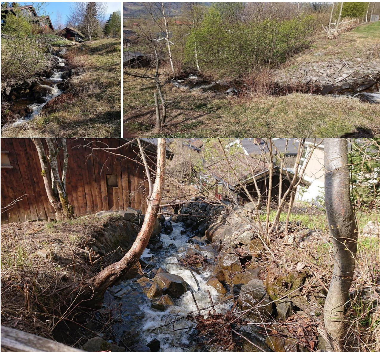
Figur 4.40 (Pkt. M8) Viser bilder tatt fra nedre del av Kringsjøvegen 193 hvor bekken faller bratt ned mot Kringsjøvegen 187, sett mot hhv oppstrøms og nedstrøms. Nederste bilde viser området nedover gjennom Kringsjøvegen 187 hvor det er svært trangt, mye massetransport og utsatt for erosjon rundt bygninger.
