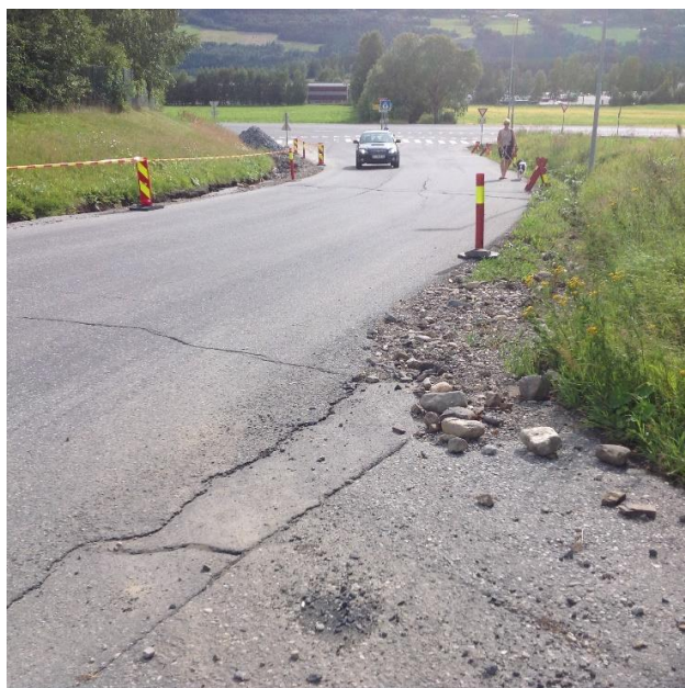
Figur 3.11 Viser de store erosjonsskadene og massetransporten nederst i Sigrid Undsets veg (nordvest for Helsehuset) da mye av flomvannet drenerte videre på begge sider av vegen og ned til Gudbrandsdalsvegen (sett fra Gårdsvegen til Skikstad hhv oppover til venstre og nedover til høyre).
