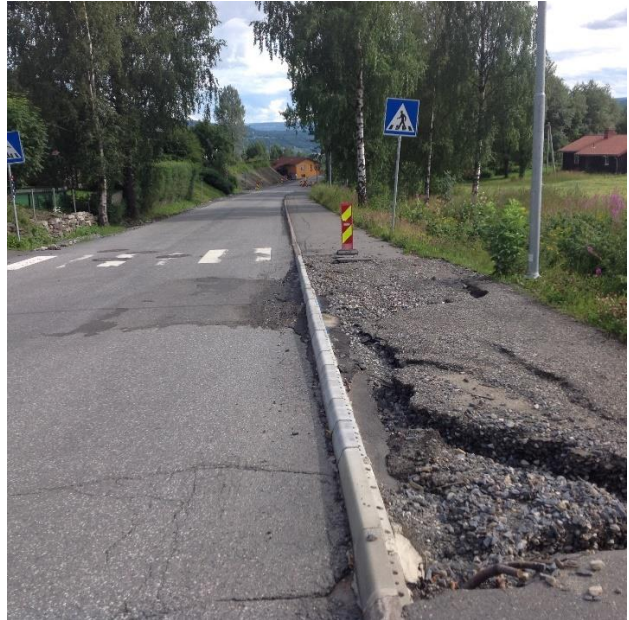
Figur 3.8 Viser at det rant relativt lite vann ut av bekkelukkingen/stikkrennen under vegen (til venstre), men at det drenerte noe vann over vegen og tilbake i bekken nedfor utløpet (til høyre).
