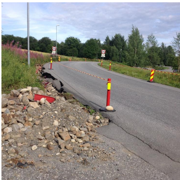
Figur 3.11 Viser de store erosjonsskadene og massetransporten nederst i Sigrid Undsets veg (nordvest for Helsehuset) da mye av flomvannet drenerte videre på begge sider av vegen og ned til Gudbrandsdalsvegen (sett fra Gårdsvegen til Skikstad hhv oppover til venstre og nedover til høyre).
