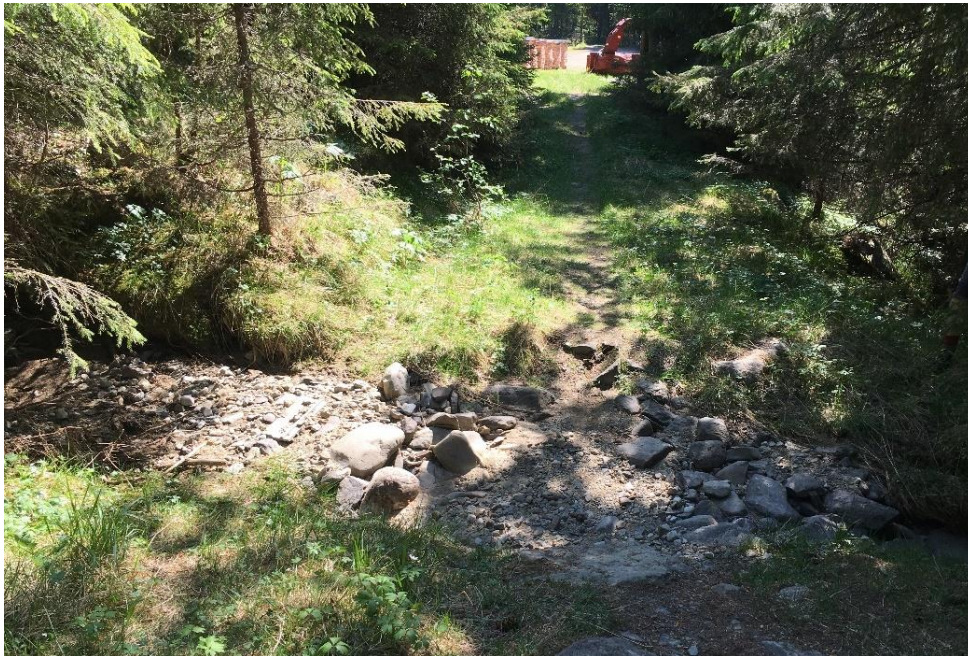
Figur 4.21 (Pkt 1-4) Nord for «vedplass» innerst i Olasvevegen krysser bekken en traktorveg. Bekken går i markert løp med stein og grusmasser i bunnen og torv/markdekke i kantene.
