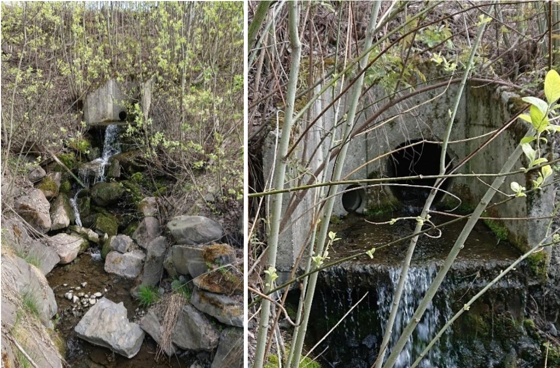
Figur 4.78 (Pkt. F9) Utløp av lukkingen til Smestadbekken oppstrøms jernbanen. Mindre drensledning/OV-ledning har også utløp her (til venstre for hovedløp). Videre er det bratt ned mot inntaket til kulvert under jernbanen; se figur nedenfor. Antatt eldre mur/erosjonssikring har rast ut og utgjør risiko for skader og/eller gjentetting av inntak nedstrøms.
