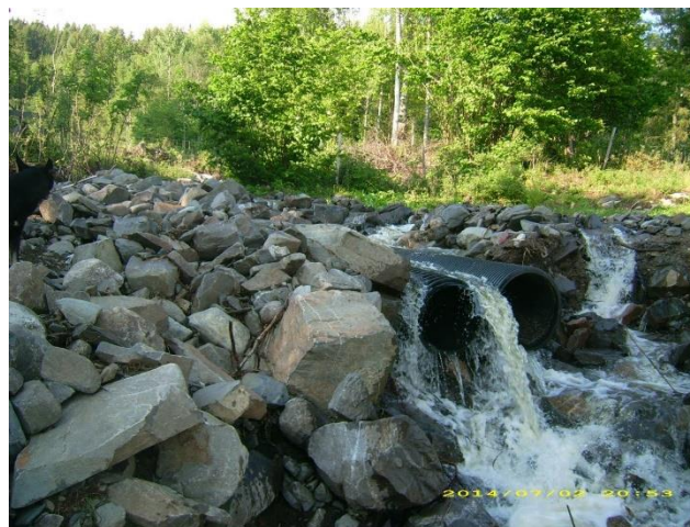
Figur 3.3 Bildet til venstre viser erosjonsskader, massetransport og utglidninger av erosjonssikring ved inntak til stikkrenne under Kringsjøvegen (punkt 3 i Figur 1.2 sett nedstrøms fra). Det ble også erosjonsskader nedstrøms stikkrennen. Til høyre sees tette stikkrenner i traktorvei i området litt lenger nedstrøms, mellom boligene i Kringsjøvegen og Lundegårdene (Foto: TMR). Store mengder med eroderte grove masser ble avlagret i slakere partier her. Finere steinmasser ble ført lenger ned og skapte kapasitetsproblemer for bekkelukkingen ved Midtre Lunde.
