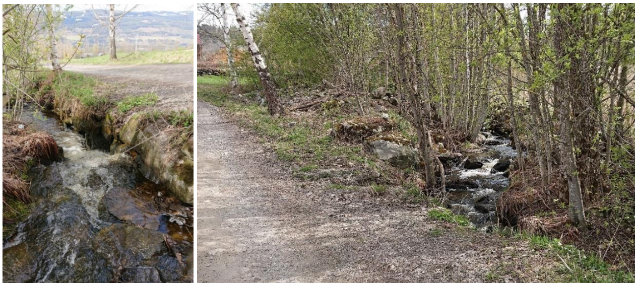
Figur 4.52 (Pkt. M14) Bilde til venstre viser enkel steinsetning nedover mot gardsvegen til Nordre Lunde. Til høyre ses kritisk punkt (fra nedstrøms) hvor vannet vil kunne grave seg inn i gardsvegen og følge denne ned mot Gamlevegen. Fare for vann på avveie og mye erosjon.
