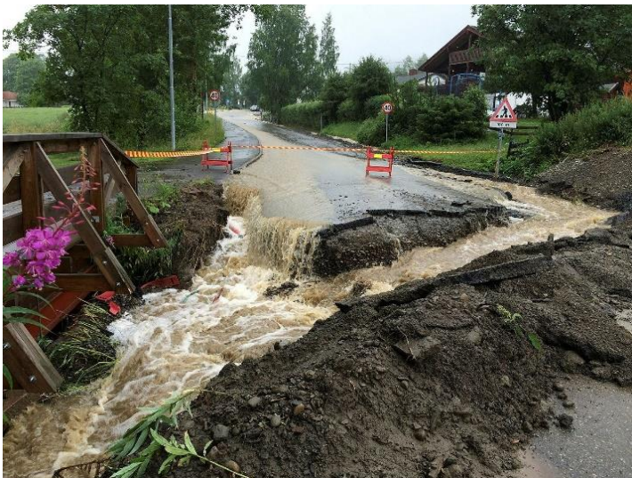
Figur 3.9 Venstre bilde viser overgraving av Fagabergvegen for å lede flomvannet tilbake i Lundebekken, sett oppover fra punkt 5 i Figur 1.2 (Foto: NVE's arkiv). Høyre bilde viser at det rant mye vann videre nedover Fagabergvegen.
