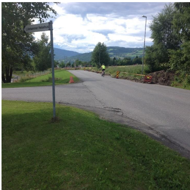
Figur 3.10 Venstre bilde viser innkjøringen til Helsehuset fra Sigrid Undsets veg, hvor flomvann drenerte inn fra oppstrøms fra begge sider av vegen. Inntak til både stikkrenne under vegen (ved sperrebukk til høyre) og til den videre lukkede ledningen under Helsehuset (høyre bilde) gikk tett, i tillegg til at «veigrøfta» mot jordet oppstrøms ble fylt med sedimenter. Mye vann drenerte ned mot Helsehuset mellom de to bilene på bilde oppe til høyre. Det ble da igangsatt evakuering.
