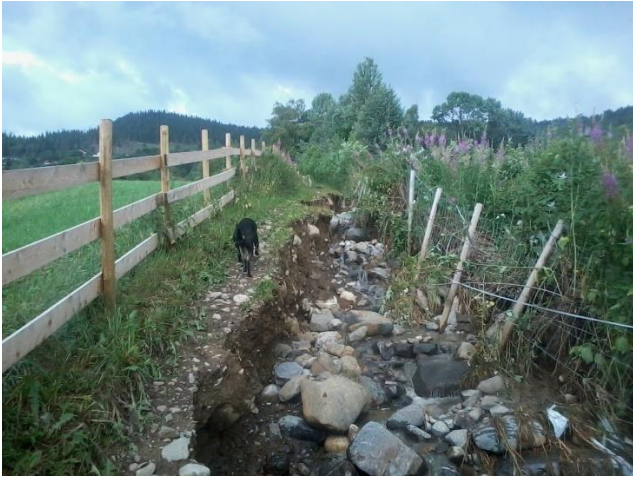
Figur 3.4 Til venstre sees (nedenifra) erosjonsskader ned gjennom gutua (sti) oppstrøms og mellom Nordre og Søndre Lunde pga vann på avveie hovedsakelig fra Bæla. Til høyre sees masseavlagring ved Lundebekken i området ved Lunde (Begge foto: TMR).
