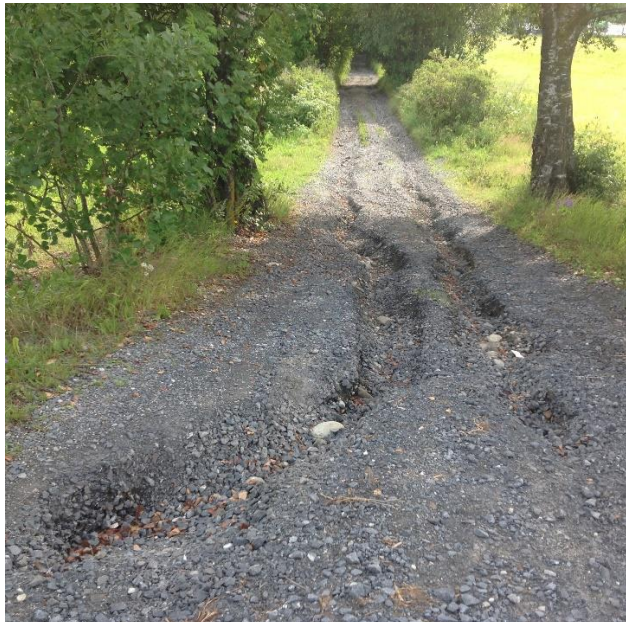
Figur 3.12 Bildet til venstre viser at det drenerte mye vann rett over Gudbrandsdalsvegen (som ble stengt) og eroderte traktorvegen ned mot/til Industrigata. Til høyre sees hvor resten av flomvannet drenerte mot nordvest langs Gudbrandsdalsvegen og ut mot/til Bæla (Dette bildet og de i Figur 3.13 er tatt rett etter at store mengder sedimenter var fjernet).
