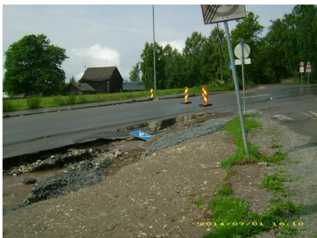
Figur 3.7 Viser skader etter vann på avveie over og langs Fagabergvegen. Stikkrennen/bekkelukkingen under veien hadde ikke tilstrekkelig kapasitet, bl.a. fordi ristene tettet seg med løsmasser (som første bilde på forsida viser). Venstre bilde er tatt opp mot krysset Fagabergvegen/Gamlevegen. Høyre bilde viser vann og løsmasser som drenerer videre nedover Fagabergvegen, som ble en flomvei (Begge foto: TMR).
