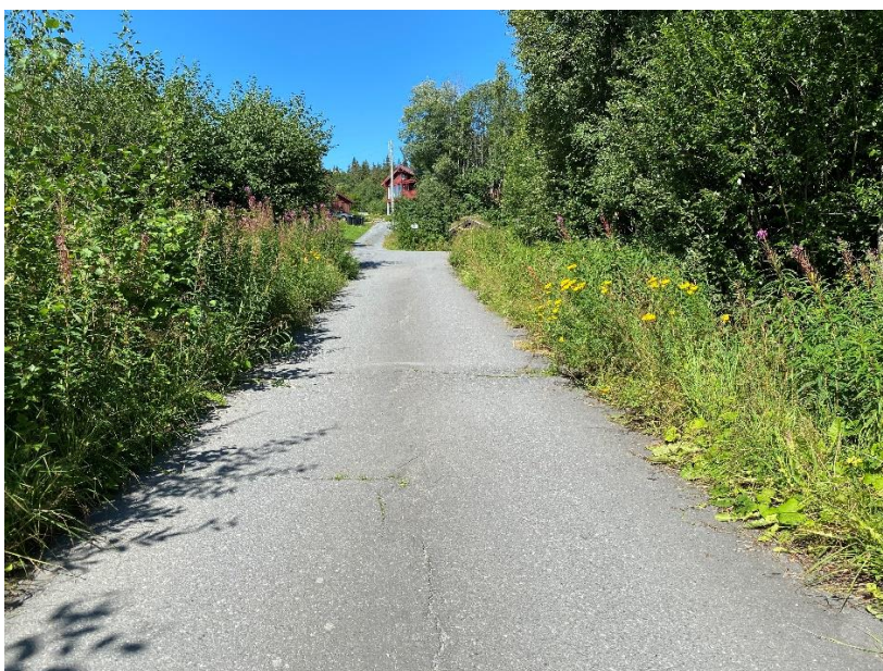
Figur 4.24 (Pkt. 3-1) Det er to kryssinger med stikkrenner i Bergesvevegen for Bekk 3 (se svarte punkt i Figur 4.25); hhv en ved postkassestativet (bilde til høyre) og en litt lenger ned i vegen (tverrgående sprekk i vegen midt på bilde til venstre). Begge bilder er tatt nedenifra.
