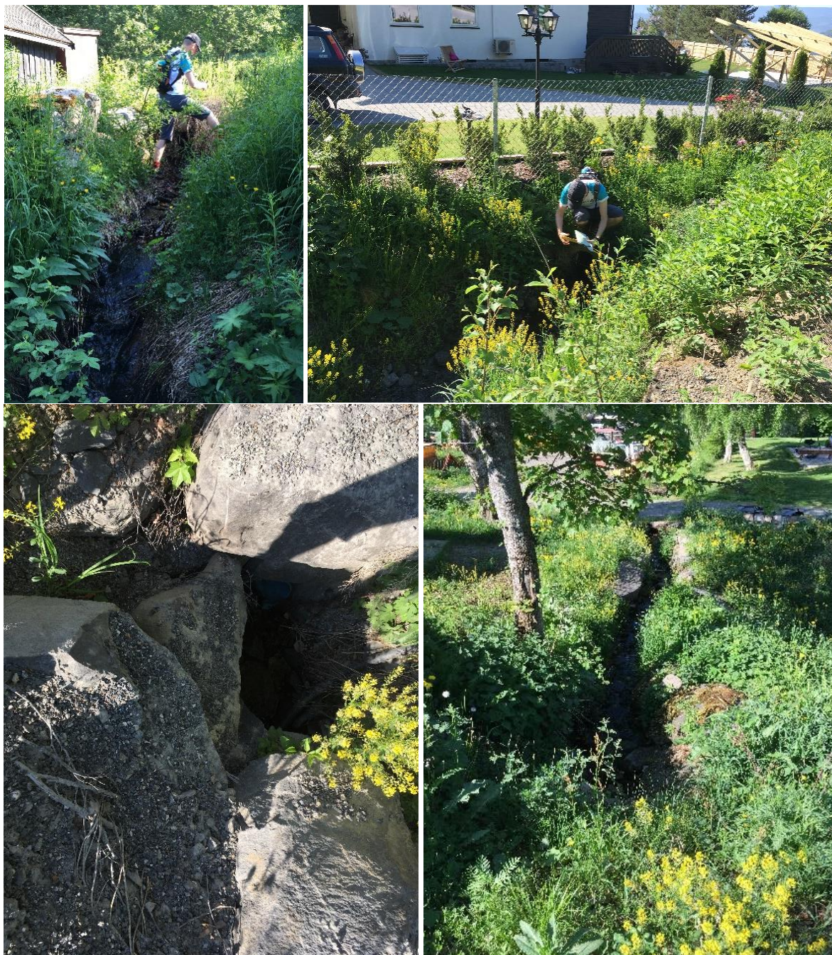
Figur 4.58 (Pkt. F2) Drenering fra både Bjørnerud (øverst til venstre) og Vesleberget ned til og gjennom Kringsjøvegen (innløp øverst til høyre og utløp nederst til venstre). Sårbart område med mange dreneringer og lukkinger; både i området, oppstrøms og nedstrøms. Bildet nederst til høyre er tatt fra vegen og nedover mot boliger nedstrøms.
