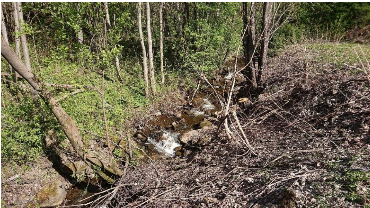
Figur 4.64 (Pkt. N1) Nylig hogd / ryddet løvskog i et kortere parti langs bekken. En del utfylling og hageavfall i skråninga som gir et smalere bekkeløp og fare for igjenfylling, samt gjentetting av inntak til bekkelukking nedstrøms.
