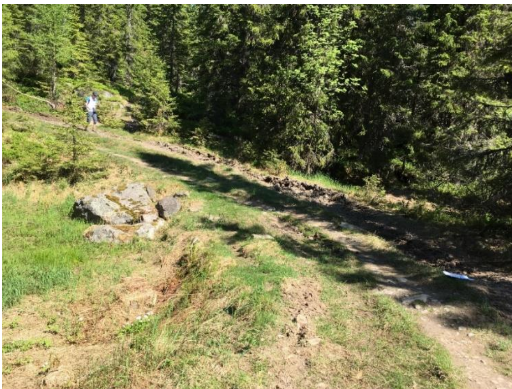
Figur 4.18 (Pkt. 1-1) Traktorveg/sti nord for Åsstuevegen (1. sving på traktorvegen nord for enden av Åsstuevegen). Her antas deler av Åsmyra å drenerer ut mot nord-vest (over traktorveg og ut i venstre bildekant). Det var tydelige spor fra strømmende vann i terrenget.
