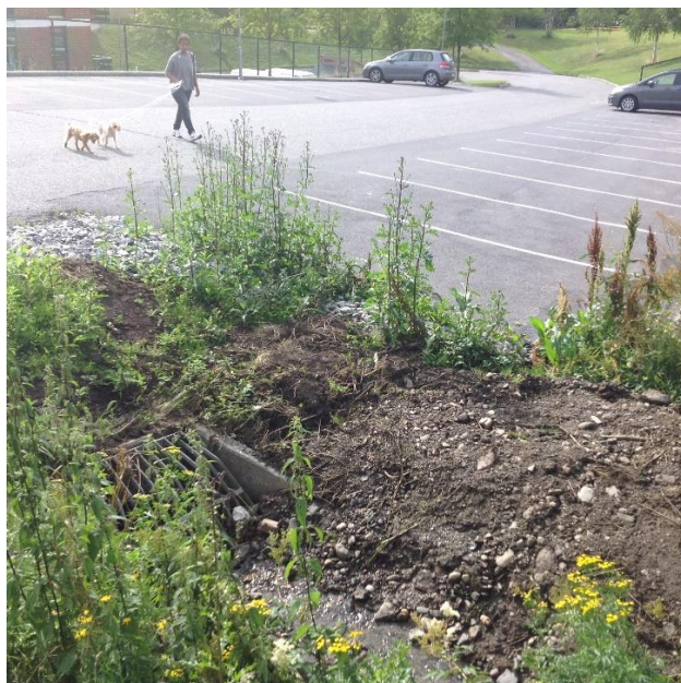
Figur 3.10 Venstre bilde viser innkjøringen til Helsehuset fra Sigrid Undsets veg, hvor flomvann drenerte inn fra oppstrøms fra begge sider av vegen. Inntak til både stikkrenne under vegen (ved sperrebukk til høyre) og til den videre lukkede ledningen under Helsehuset (høyre bilde) gikk tett, i tillegg til at «veigrøfta» mot jordet oppstrøms ble fylt med sedimenter. Mye vann drenerte ned mot Helsehuset mellom de to bilene på bilde oppe til høyre. Det ble da igangsatt evakuering.
