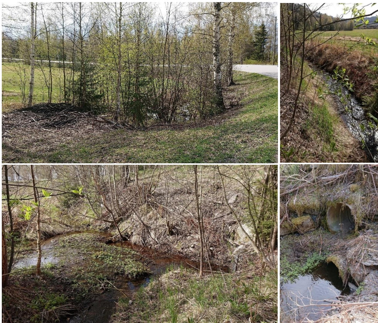
Figur 4.45 (Pkt. F5) Bildet øverst til venstre viser Lundmyra fra Kringsjøvegen mot sør. Inntak til stikkrenne gjennom Kringsjøvegen er nede i det våte søkket til venstre for veien. Til høyre ses kanal/grøft langs Lundmyra fra inntak stikkrenne og østover/oppover. Bilde nederst til venstre viser ansamling av vann og sediment ved inntaket til stikkrennen. Til høyre ses utløp på nordre side av Kringsjøvegen. Den gamle stikkrenna ligger høyere. Nyeste stikkrenna er lagt som følge av at Lundmyra har sunket betydelig etter dyrking (drenering?). Myrområdet har igjen sunket ytterligere etter at den siste stikkrenna er lagt.
