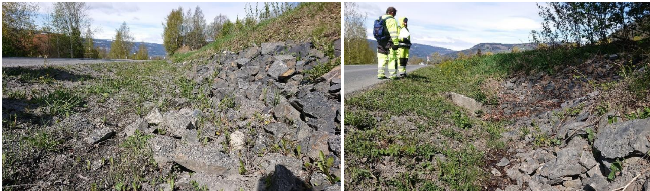
Figur 4.67 (Pkt. F10) Sigrid Undsets veg oppstrøms Helsehuset (se eget notat om hastetiltak). Det er etablert vegggrøft (og fjernet gateløp) mot jordet ovenfor og utbedret inntaket for liten bekk/lukking (sees midt på høyre bilde) som fortsetter ned gjennom/under Helsehuset og dyrka mark nedstrøms Gudbrandsdalsvegen. Hastetiltaket er utført for å bidra til å sikre Helsehuset inntil permanente sikringstiltak kommer på plass.
