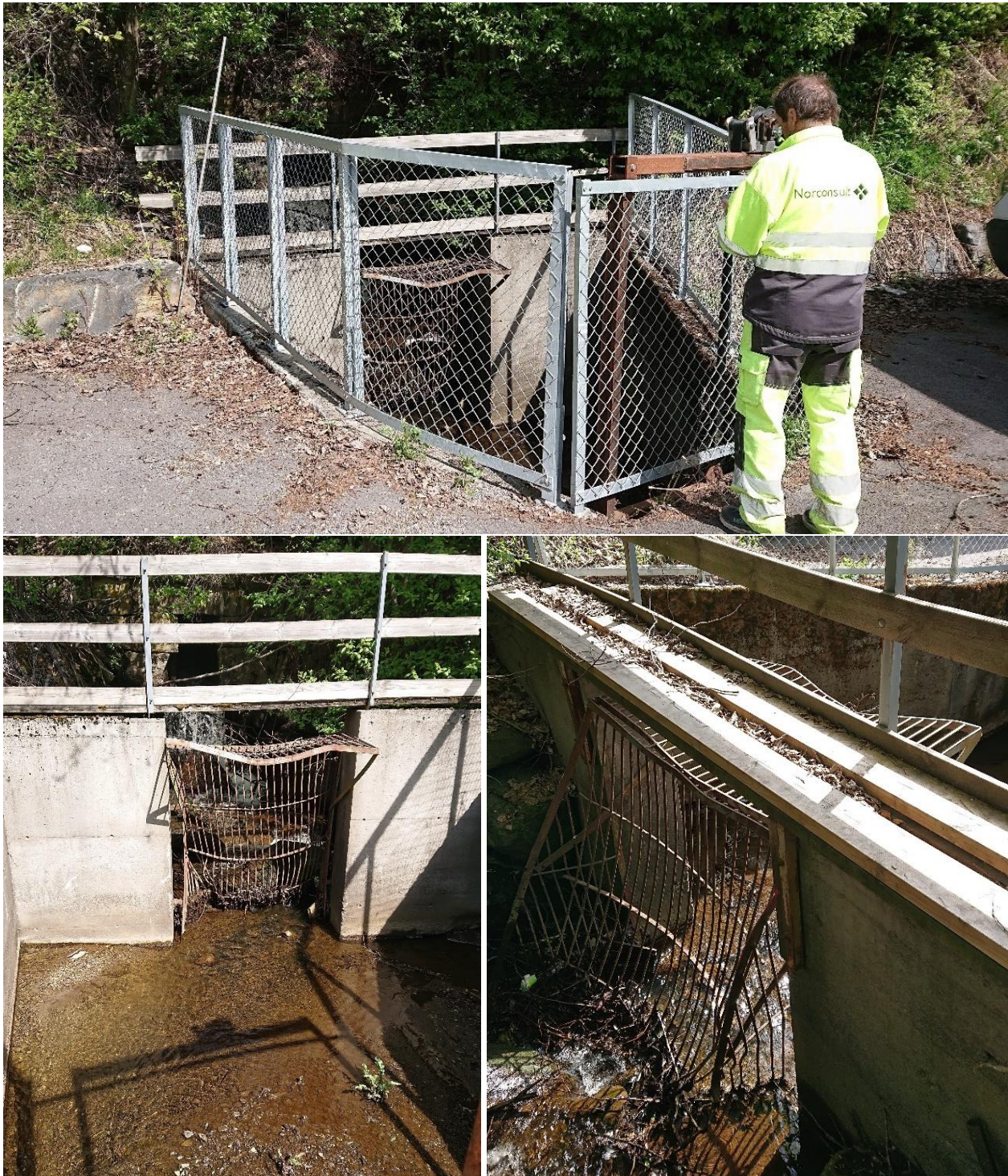
Figur 4.73 (Pkt. N7) Bekkeinntak nedstrøms jernbanen, ved Hovemovegen 1. Inntaket og ledningen videre bryter av mot sør og høyre i øverste bilde (som sees i høyre bilde på neste figur). Inntaket er etablert med betongvegg og inntaksrist i utsparing før selve inntaket. I de to nederste bildene ser en at rista er skadet i tidligere flommer (det venstre er tatt fra nedstrøms side og det høyre fra oppstrøms side). I nedre venstre hjørnet på bildet til venstre kan man observere vann som trenger fram fra under betongveggen.
