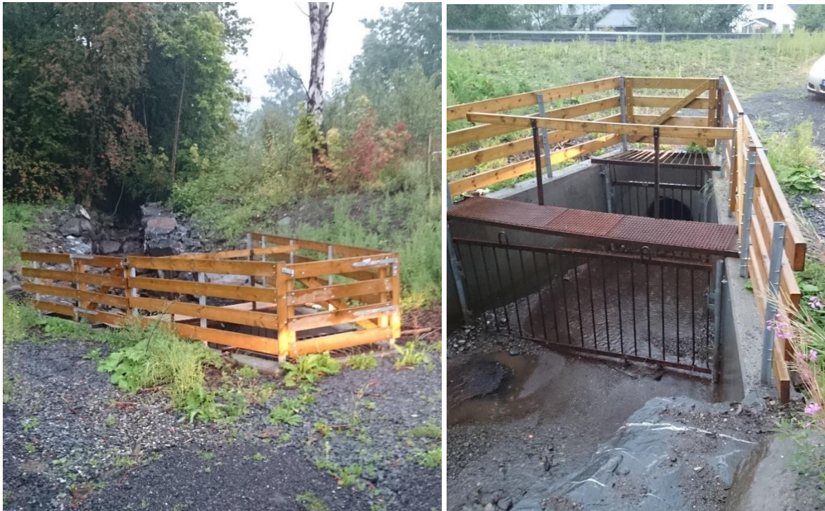
Figur 4.53 (Pkt. M15) Inntak bekkelukking ved Fagabergvegen, oppgradert etter flommen i 2014. Dette var da et av de mest kritiske punktene mht Helsehuset.
