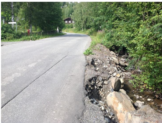
Figur 3.3 Bildet til venstre viser erosjonsskader, massetransport og utglidninger av erosjonssikring ved inntak til stikkrenne under Kringsjøvegen (punkt 3 i Figur 1.2 sett nedstrøms fra). Det ble også erosjonsskader nedstrøms stikkrennen. Til høyre sees tette stikkrenner i traktorvei i området litt lenger nedstrøms, mellom boligene i Kringsjøvegen og Lundegårdene (Foto: TMR). Store mengder med eroderte grove masser ble avlagret i slakere partier her. Finere steinmasser ble ført lenger ned og skapte kapasitetsproblemer for bekkelukkingen ved Midtre Lunde.
