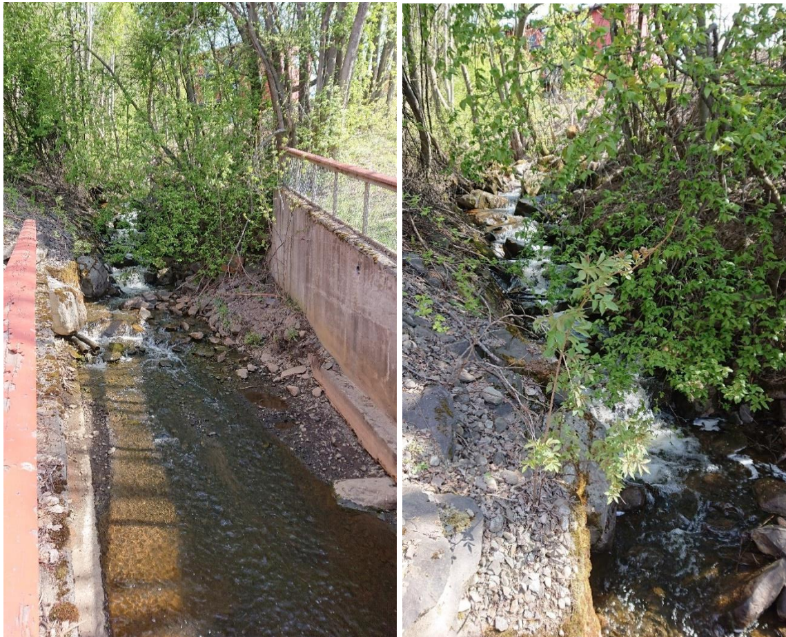
Figur 4.65 (Pkt. N2) Inntak til bekkelukking ved Lundebekken studenthjem, sett fra inntaket og oppover.
