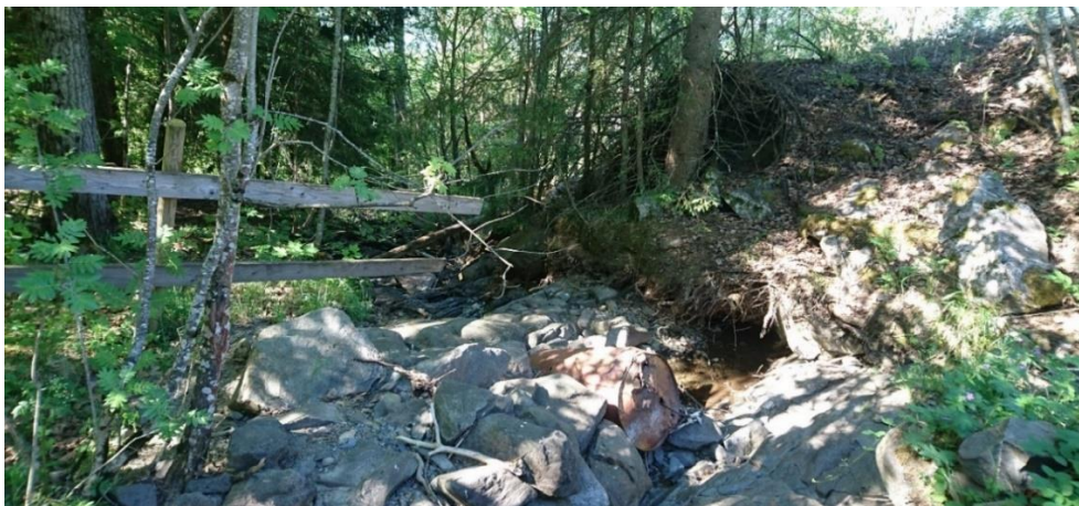
Figur 4.34 (Pkt. M4) Oppstrøms Kringsjøvegen 193 ved øvre del av beite/dyrka mark, sett fra oppstrøms. Haug sees på nordsiden av bekken (dyrkingsrøys/steinrøys?). Delvis bart fjell, men mye avlagrede store steiner, spesielt oppstrøms. Flomvann vil potensielt kunne ta nordover ut over beite/dyrka mark og mot bebyggelse.
