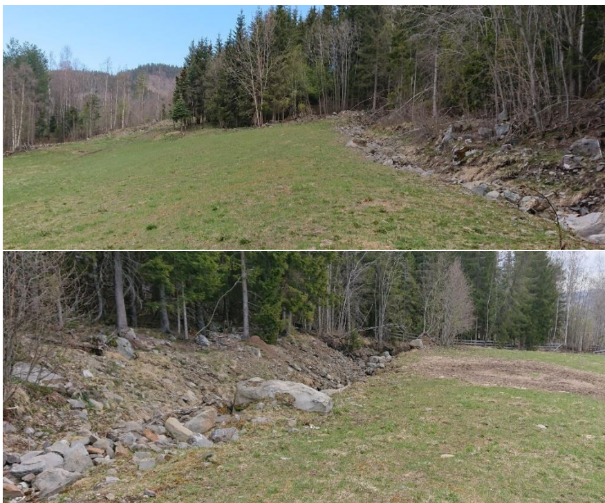
Figur 4.31 (Pkt. M2) Det er etablert ei dreneringsgrøft i øvre kant av den dyrka marka ved Vesleberget. Bildet øverst er tatt i retning nord. Avskjærende grøft ses til høyre. Denne er delvis fylt med grov stein. Grøfta starter høyere opp og kommer ned til den dyrka marka i øvre høyre hjørnet av dyrka mark i bildet. Oppstrøms den dyrka marka er grøfta mer utydelig i terrenget og mer sårbar for vann på avveie. Grøfta krysser også en traktorveg høyere opp, hvor det er en liten stikkrenne. Bilde nederst er tatt i motsatt retning, mot Lundebekken, som kommer ned til den dyrka marka ved enden av grøfta.
