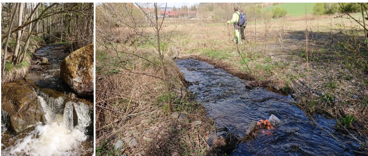
Figur 4.47 (Pkt. M12) Bildet til venstre viser blokk eller innslag av fjell i bekkeløpet nedstrøms samløpet med kanalen. Til høyre vises ei stikkrenne på Søndre Lunde som gikk tett (kan skimtes i nedre bildekant) i flommen 2014. Stikkrenna lå under adkomst til dyrka mark. Dette er et myrlendt område som naturlig blir et «fordrøyningsområde» i en flomsituasjon.
