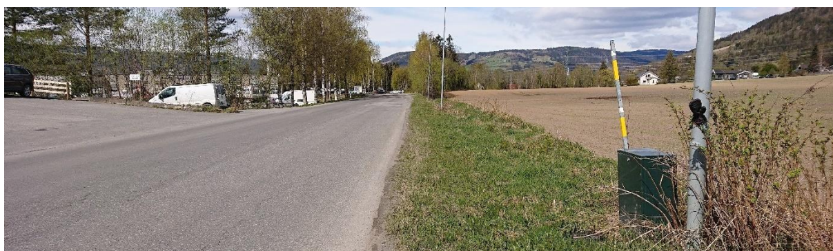
Figur 4.86 (Pkt. F14) Inntakskum til drenering vist i figur ovenfor ligger noen meter nord for lykestolpe nr. 2 fra fotopunkt. Ut fra kummen som ligger i vegen (sandfang) samme sted er det OV-ledninger både nordover og sørover Industrigata (ikke registrert i Gemini VA). Utløp fra sandfanget antas ut fra bilde i Gemini VA å være direkte inn på ledningen i retning nevnte grøft i figur ovenfor.
