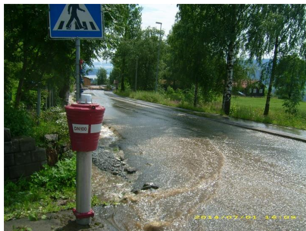
Figur 3.7 Viser skader etter vann på avveie over og langs Fagabergvegen. Stikkrennen/bekkelukkingen under veien hadde ikke tilstrekkelig kapasitet, bl.a. fordi ristene tettet seg med løsmasser (som første bilde på forsida viser). Venstre bilde er tatt opp mot krysset Fagabergvegen/Gamlevegen. Høyre bilde viser vann og løsmasser som drenerer videre nedover Fagabergvegen, som ble en flomvei (Begge foto: TMR).
