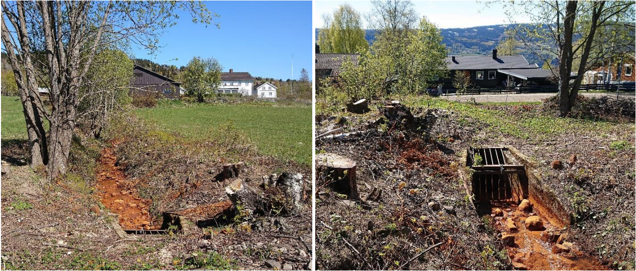
Figur 4.61 (Pkt. F7) Viser inntak til bekkelukkingen som går til Lundebekken (hvh sett mot oppstrøms og ned mot lukkingen). Hele bekketraseen er preget av brunt vann, noe som kanskje tilsier at vannet herfra ikke bør ledes til Lundebekken. Inntaket er et sårbart punkt pga begrenset kapasitet og vann vil i større flomsituasjoner føres mot bebyggelsen.
