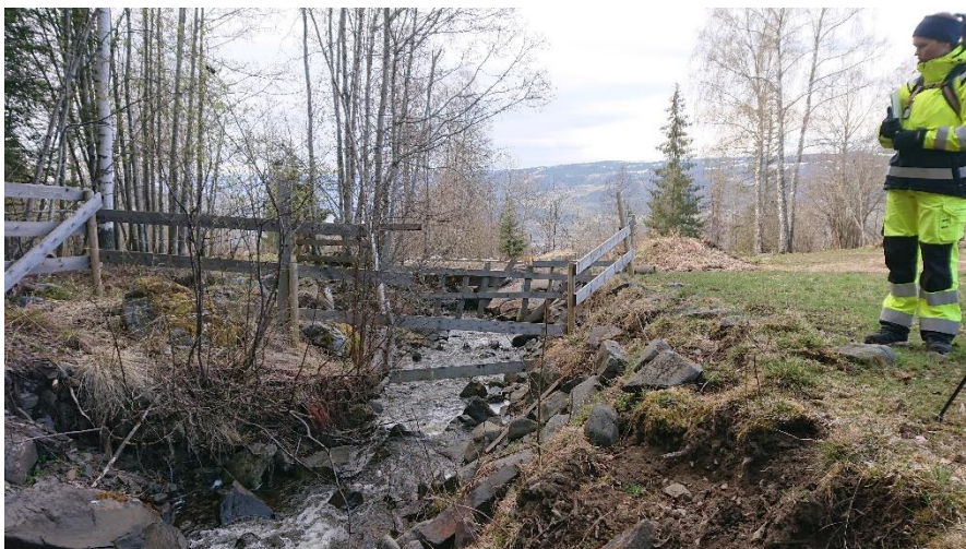
Figur 4.32 (Pkt. M2) Gammel bru og en del gjerder over Lundebekken i sørlig ende av dyrket mark, sett oppstrøms fra.
