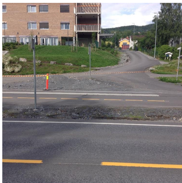
Figur 3.13 Venstre bilde viser samme kryss som høyre bilde i Figur 3.12, men motsatt vei langs Gudbrandsdalsvegen. Høyre bilde viser hvor flomvann fra Sigrid Undsets veg drenerte ned på sørøstre side av Helsehuset. Mye erosjon og massetransport helt ut i og over veien.
