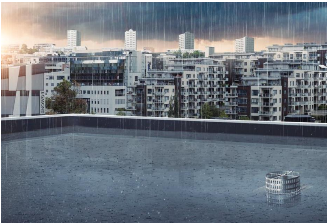
Eksempel på blått tak med utløpsregulering (og beskyttelse) til høyre i bildet.
