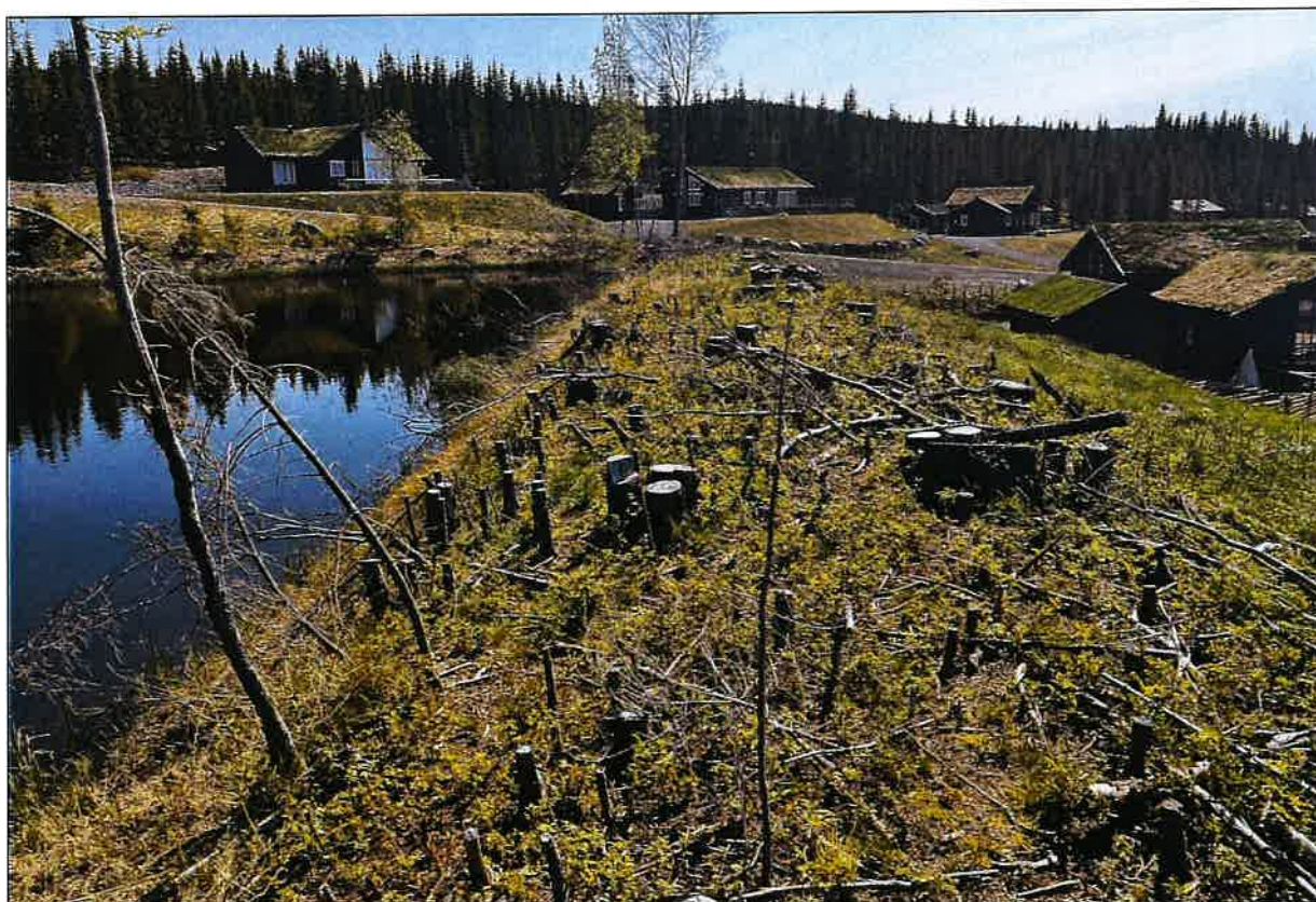
Figur 13: Damanlegg sett i østlig retning fra damkrona.
