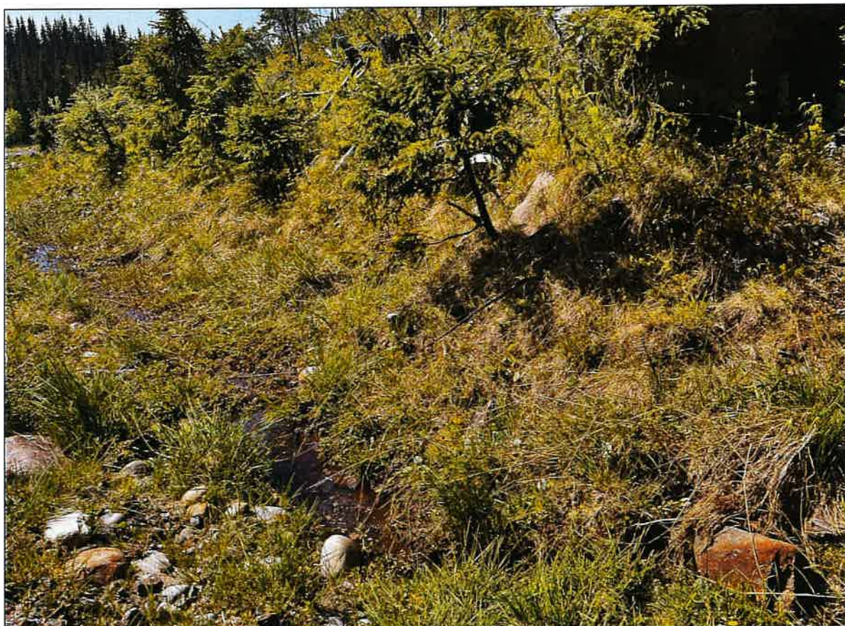
Figur 15: Lekkasje fra dammens østside.
