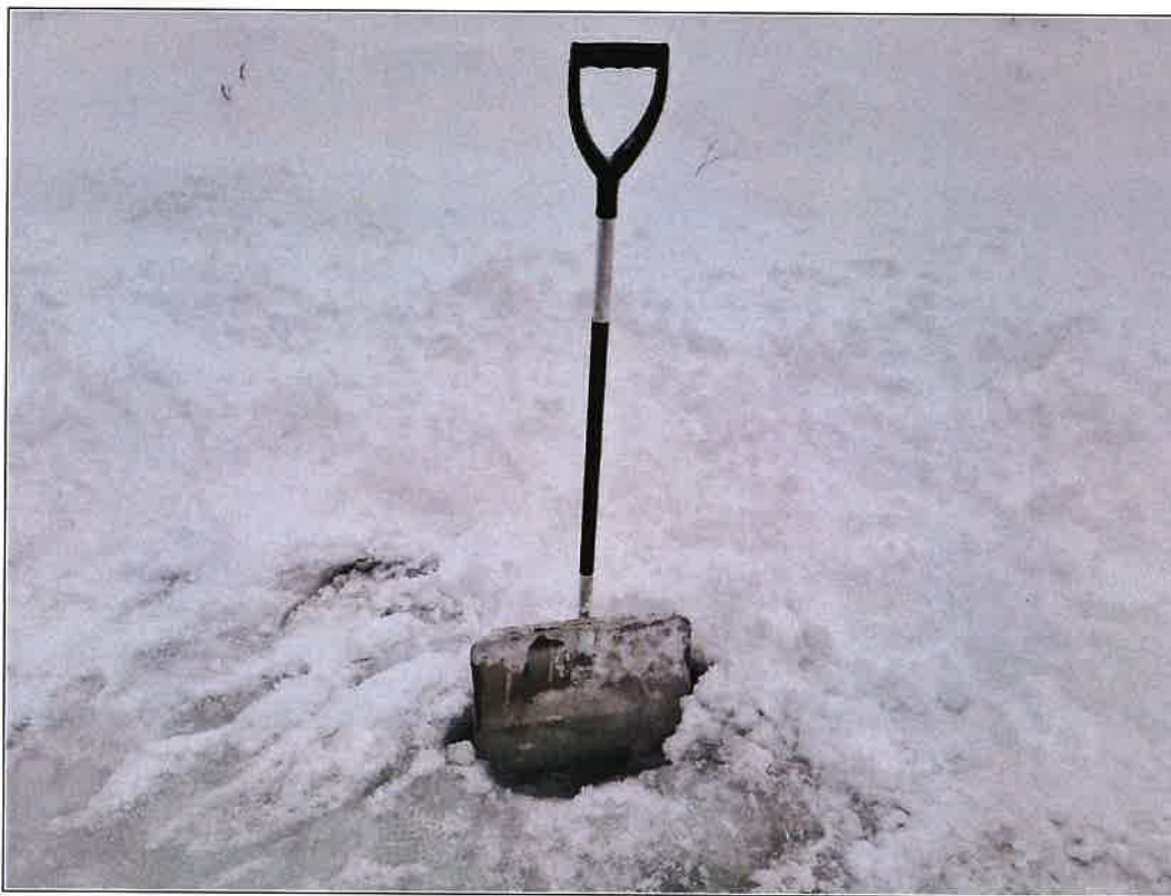
Figur 9: Ferskt vann trenger ut av damanlegget og lager issvuller inn mot hyttevegger.
