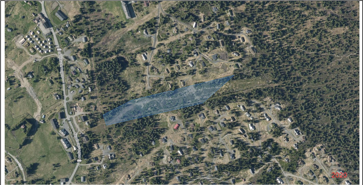
2020: Heisanlegget demontert i 2018. Vegetasjon reetableres i nedfarten etter 20 år uten drift
