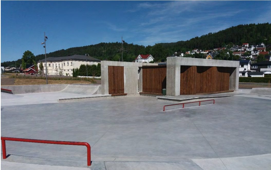
Figur 7-2 Pumpestasjon for overvatn i nedsenka skatepark med sittebenker og klatrevegg. Krokstadelva i Drammen kommune, NVE / Rune Bratlie.
