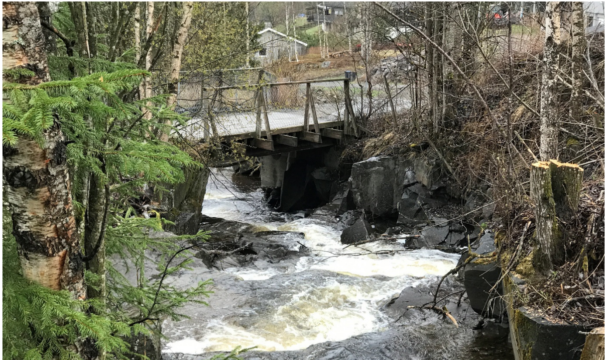
Figur 6 - Bru, gangveg ved Langbakken (bildet tatt fra oppstrøms side)
