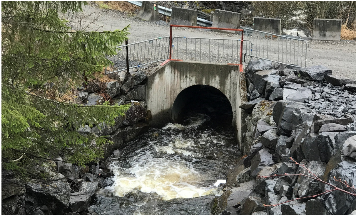
Figur 5 - Kulvert ved Høstmælingsvegen (bildet tatt fra oppstrøms side)
