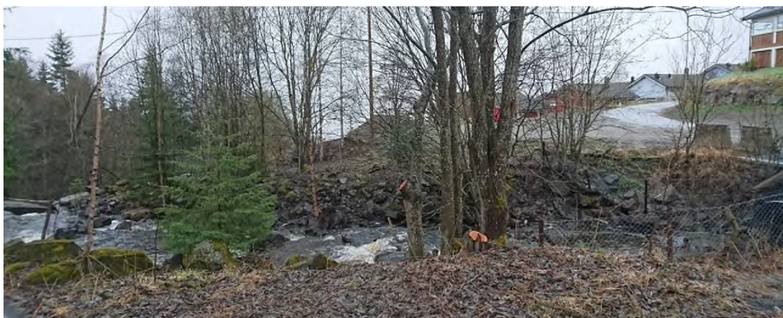
Figur 13. Åretta nedstrøms kulvert i Høstmælingsvegen hvor VA-trasé krysser ca. midt i bildet. Foto fra befaring.
