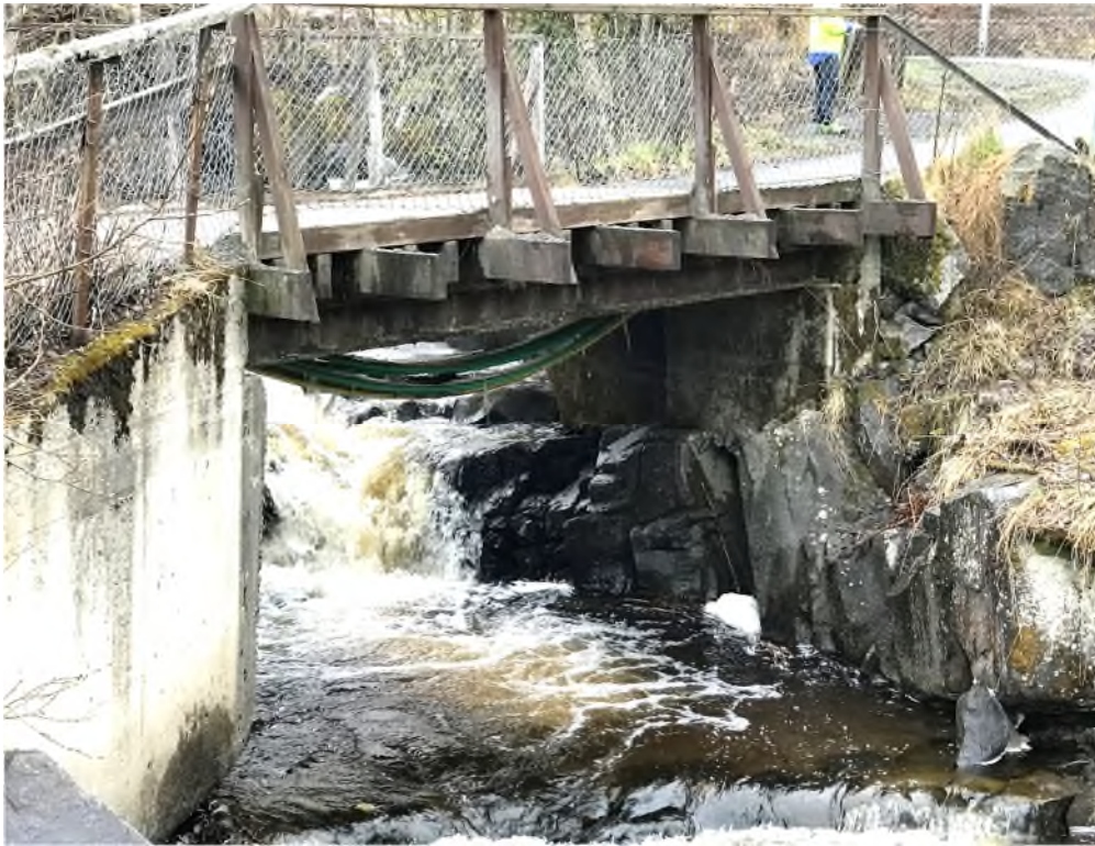
Figur 7. Gangbru over Åretta mellom Langbakken og Skogforvalter Lies veg. Det er hengt opp kabler under brua. Foto fra befaring i mai 2017.
