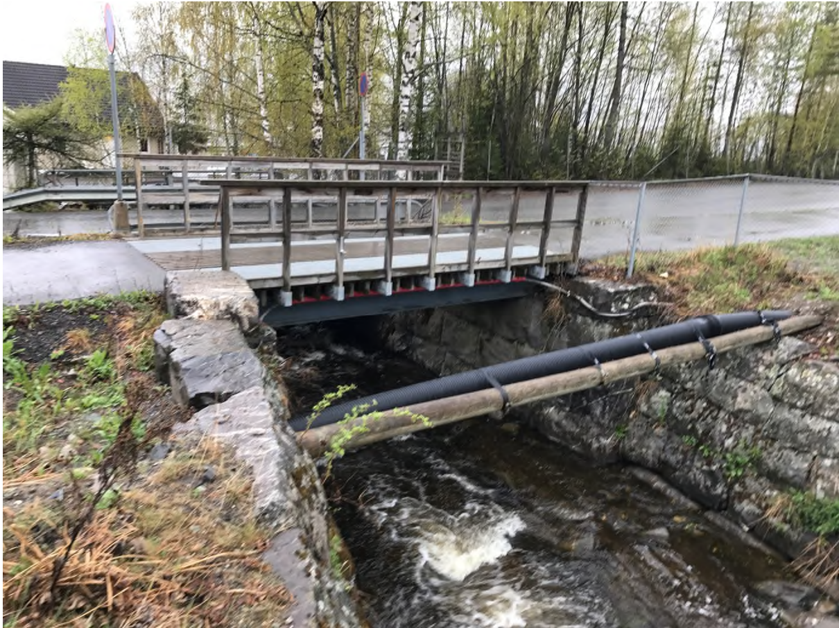
Figur 23. Kjørebru og gangbru over Åretta ved Dampsagvegen. Anlagt det som antas å være kabelføring over Åretta, opphengt i antatt impregnert stolpe. Foto fra befaring mai 2017.
