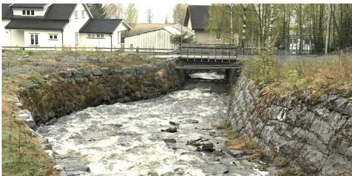
Figur 63.4. Viser kanalisert bekkeløp, med opprinnelig mur, ned mot Dampsagvegen.
