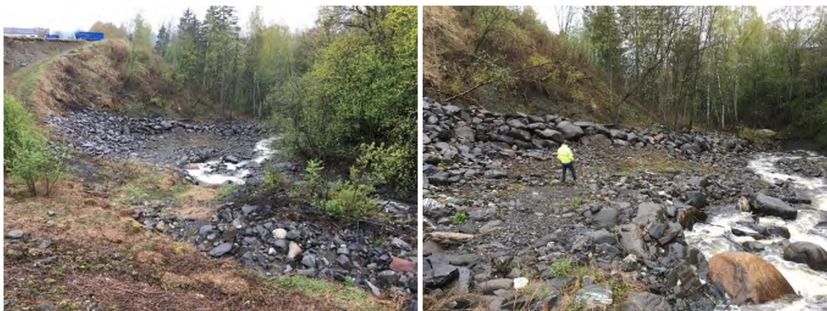
Figur 55.4. (Pkt. 23) Bilder tatt nedover, et stykke nedstrøms Hamarvegen, hvor elvedalen vider seg ut mot sør. Området er preget av erosjon og massetransport/-avlagring. Det er etablert anleggsveg ned i dalen fra sør (ses helt til venstre i venstre bilde) og lagt ut stor stein i yttersving.
