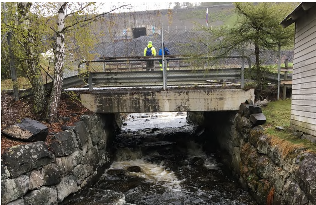
Figur 28.5. Bruene ved Dampsagvegen sett fra nedstrøms side.
