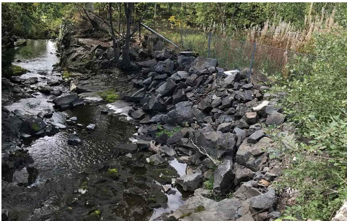
Figur 12.5. Dagens sikring langs høyre side av Åretta nedstrøms gangbrua ved Langbakken.
