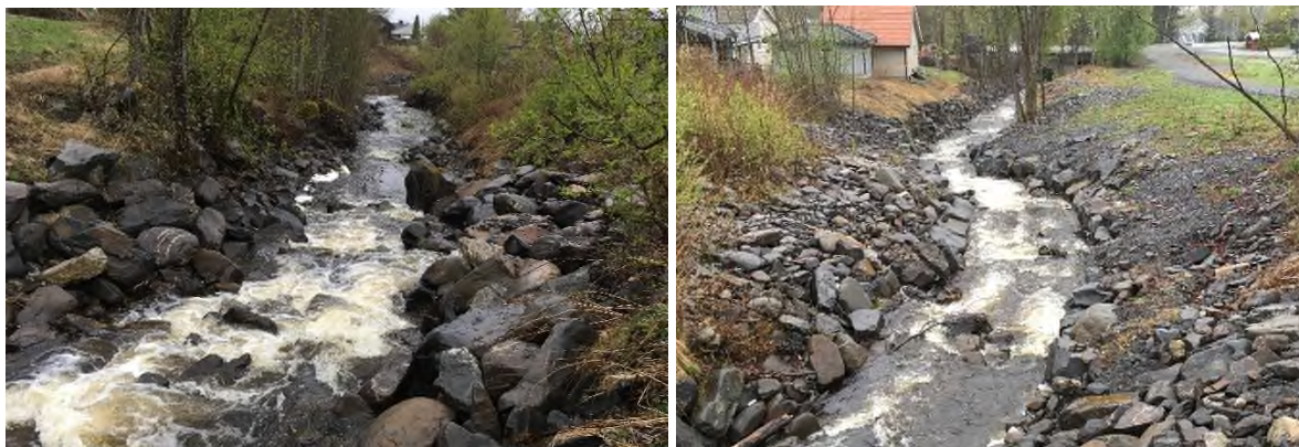
Figur 39.4. (Pkt. 12/13) Bildene viser overgangen fra mer skoglendt terreng (venstre bilde) og ned mot de bebygde arealene. Utsatte partier av elva, hvor det er bebyggelse svært nær elva, er det stablet stein i varierende utførelse.
