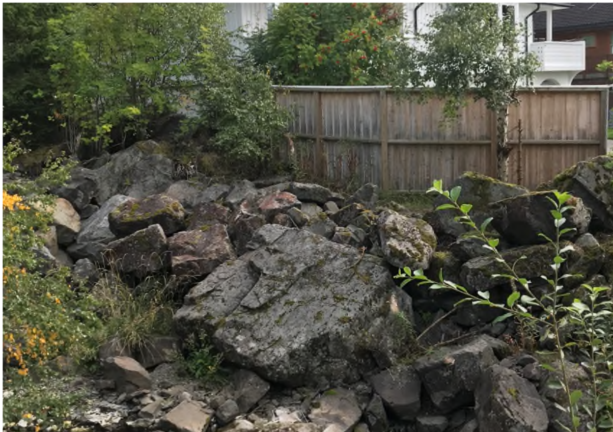
Figur 14.5. Eksisterende erosjonssikring og støyvegg ved Høstmælingsvegen 32.
