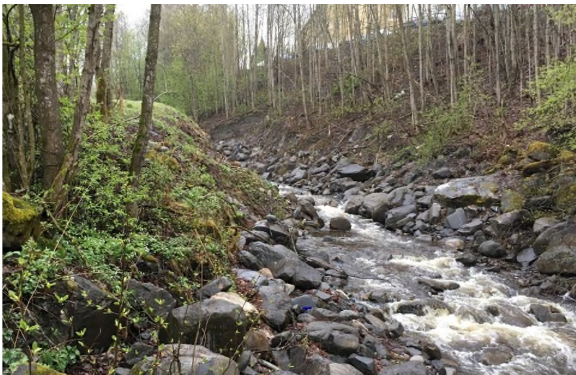
Figur 49.4. (Pkt. 17/18) Bilde fra befaring 2017 sett oppover mot Skogli (oppe til høyre).
