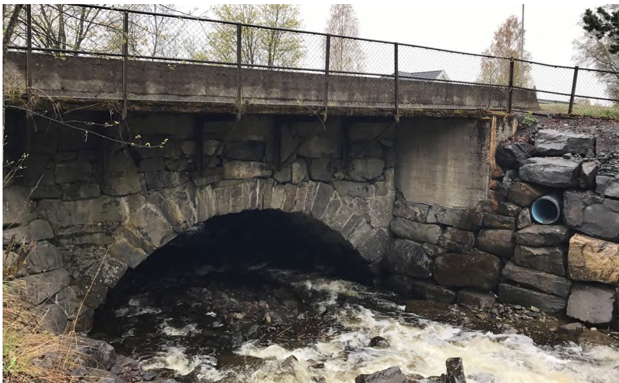
Figur 24.5. Innløpet til brua i Hamarvegen.
