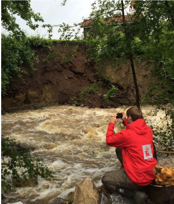
Figur 4.3 Bilde fra Nedstrøms Fredrik Colletts veg ved Skogli under flommen 2014 (Foto: Lillehammer kommune).
