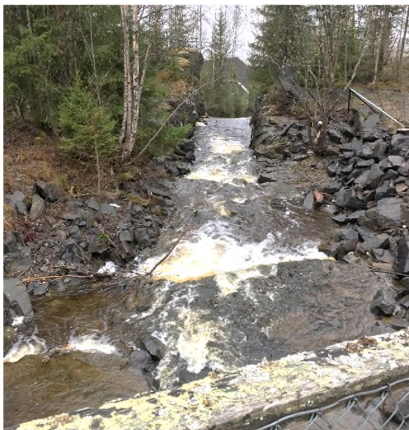
Figur 27.4. Viser elveløpet som er sprengt ut i fjell nedstrøms brua i pkt. 4. Det er mye løst steinmateriale i elvebreddene, opp til ca. 0,5 meters størrelse.
