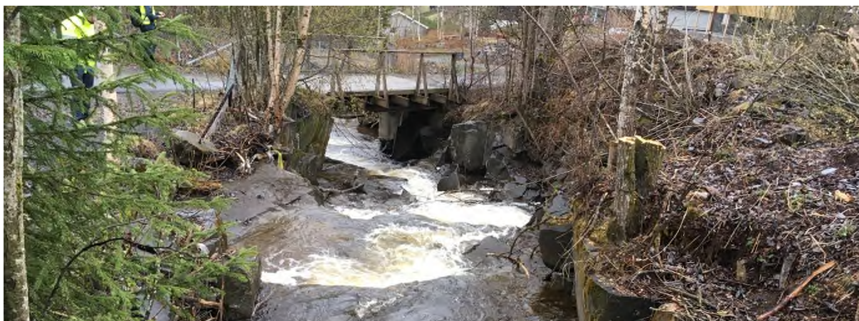
Figur 11.5. Bru og tilløp ved Langbakken.
