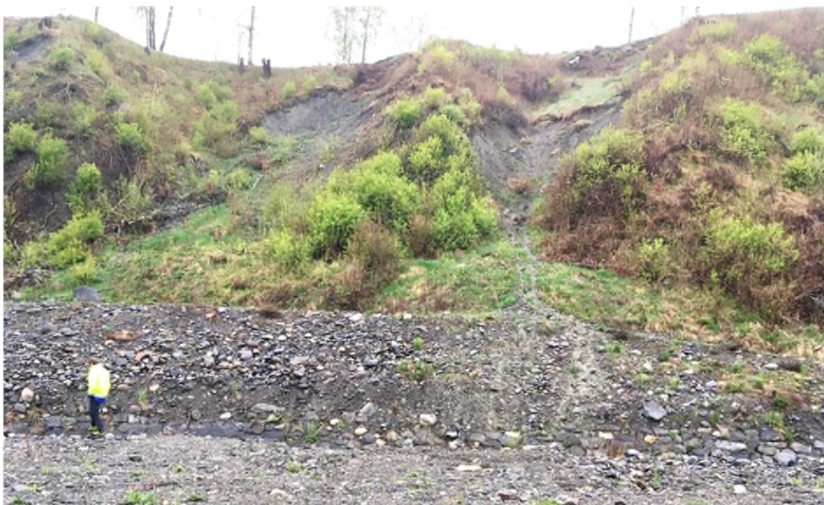
Figur 58.4. (Pkt. 27) Viser et parti på ca. 200 meter med rasutsatt skråning ved jernbanen rett nord for elva. Det er avskoget etter 2014-flommen. En ser tydelige sår i skråningen etter mindre utglidninger og erosjon.
