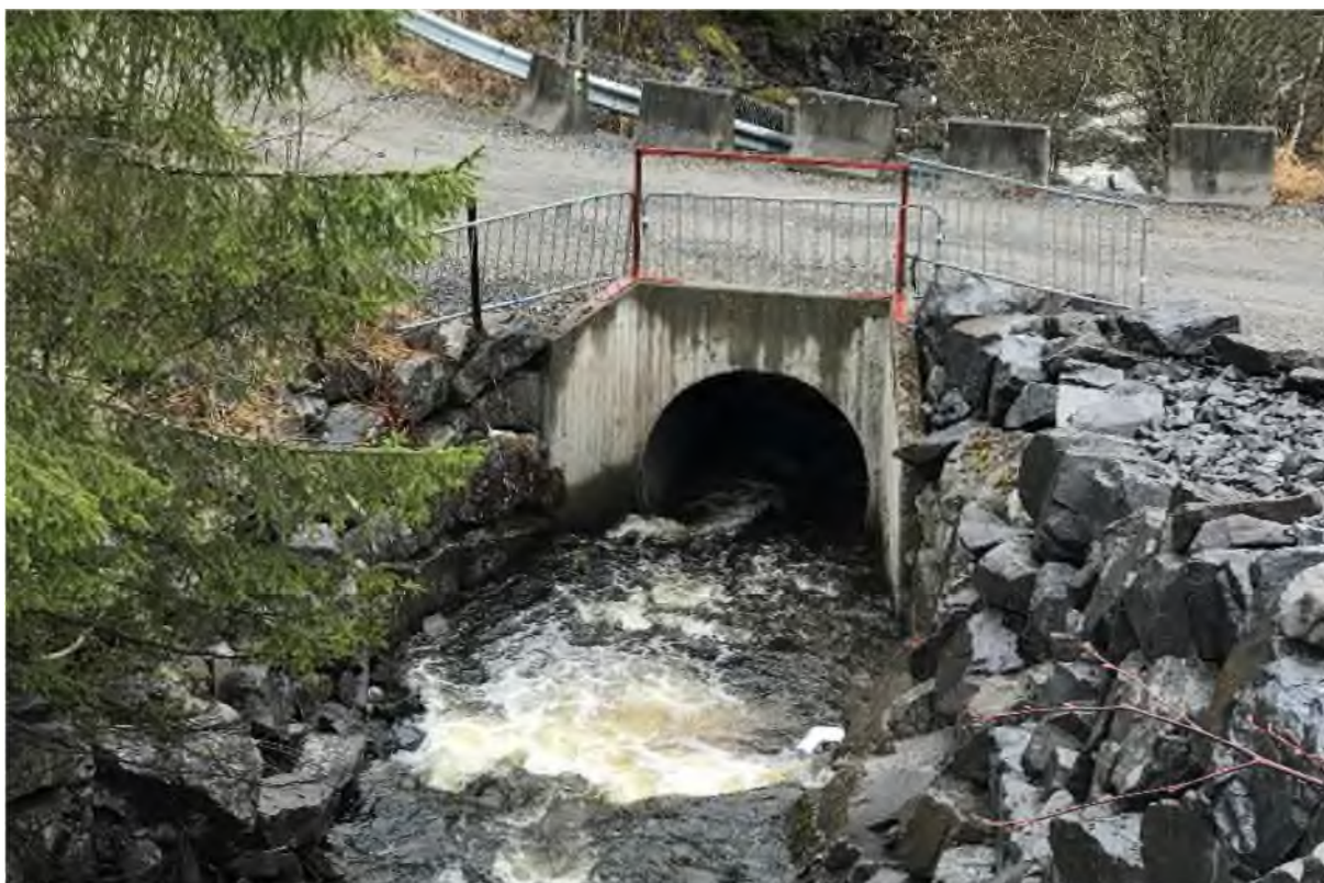
Figur 15.5. Dagens kryssing under Høstmælingsvegen, sett fra oppstrøms side.
