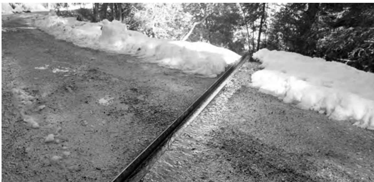
Figur 17.5. Eksempel på avskjærende renne; her nedfelt stålbejelke (Foto: Hermann Zschiegner, www.edwardtufte.com ).
