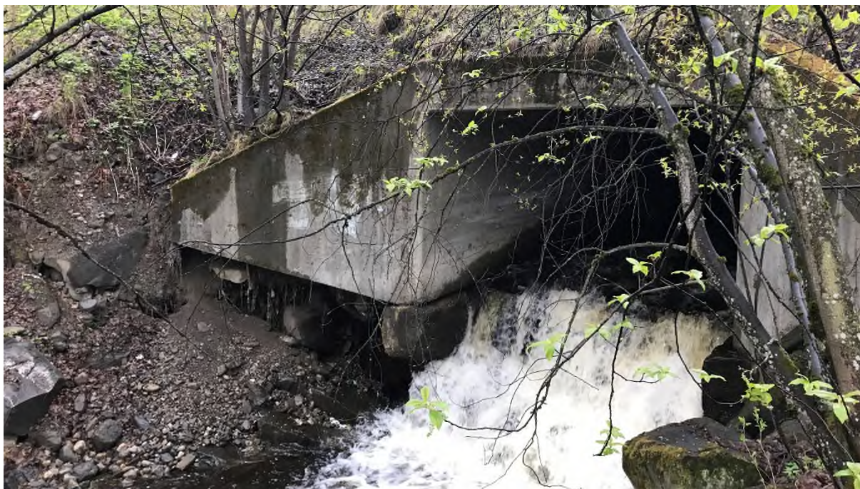
Figur 25.5. Nedstrøms ende av brua i Hamarvegen.
