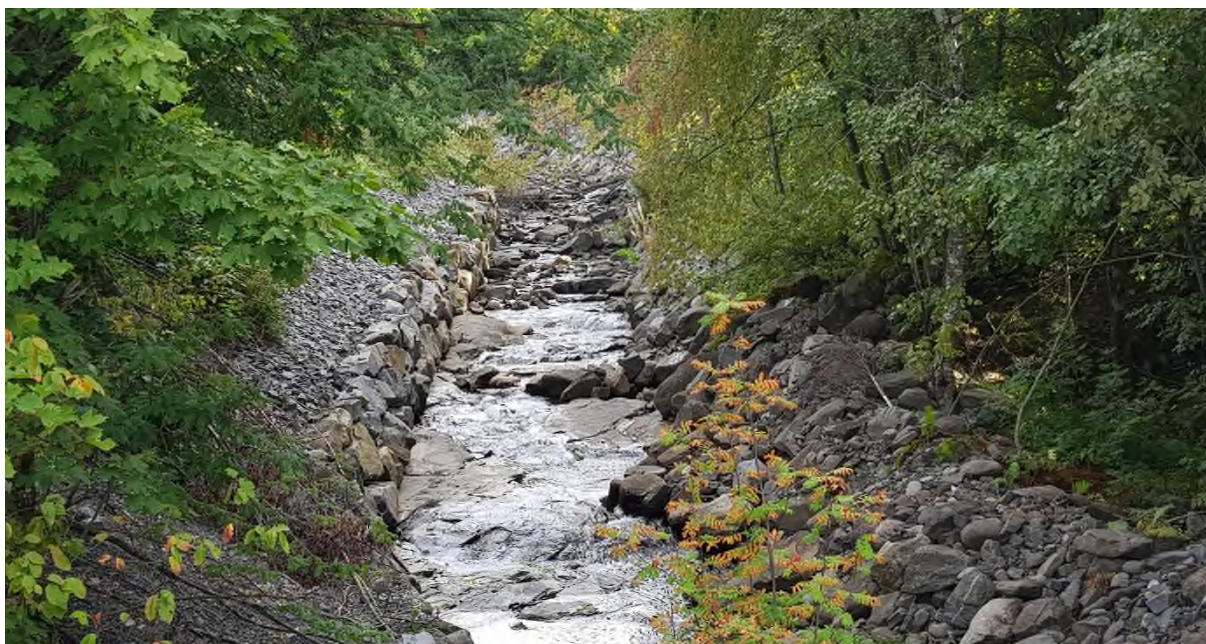
Figur 23.5. Elveløpet mellom Hamarvegen og Fredrik Colletts veg. Bildet er tatt fra nedstrøms side.
