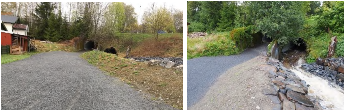
Figur 44.4. (Pkt. 14/15) Viser utløpet til gangkulvert (til venstre i bildene) og kulvert hvor Åretta krysser Fredrik Colletts veg. Venstre bilde fra befaring 2017. Høyre bilde fra gjenoppbygging etter flommen i 2014 (foto: Lillehammer kommune). Det er etablert en voll i forlengelsen av betongmur for sikring mot bebyggelse.
