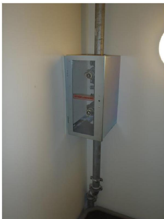
Figur 9 Godt eksempel på skap for beskyttelse av stigeledning/tørropplegg mot hærverk.
