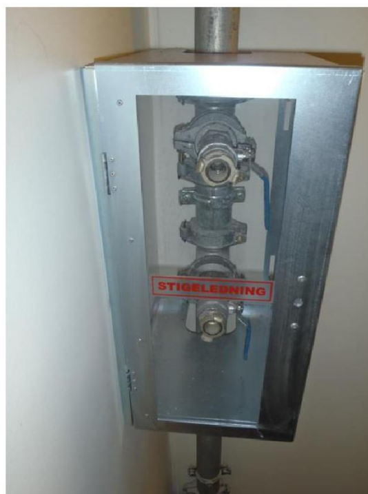
Figur 9 Godt eksempel på skap for beskyttelse av stigeledning/tørropplegg mot hærverk.
