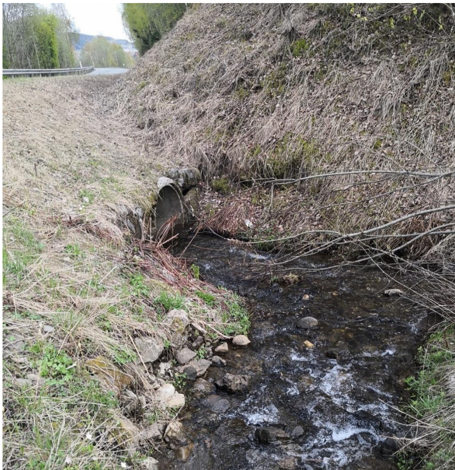
Figur 3-57: Innløp kulvert under Jørstadmogegen (Fv. 253)
