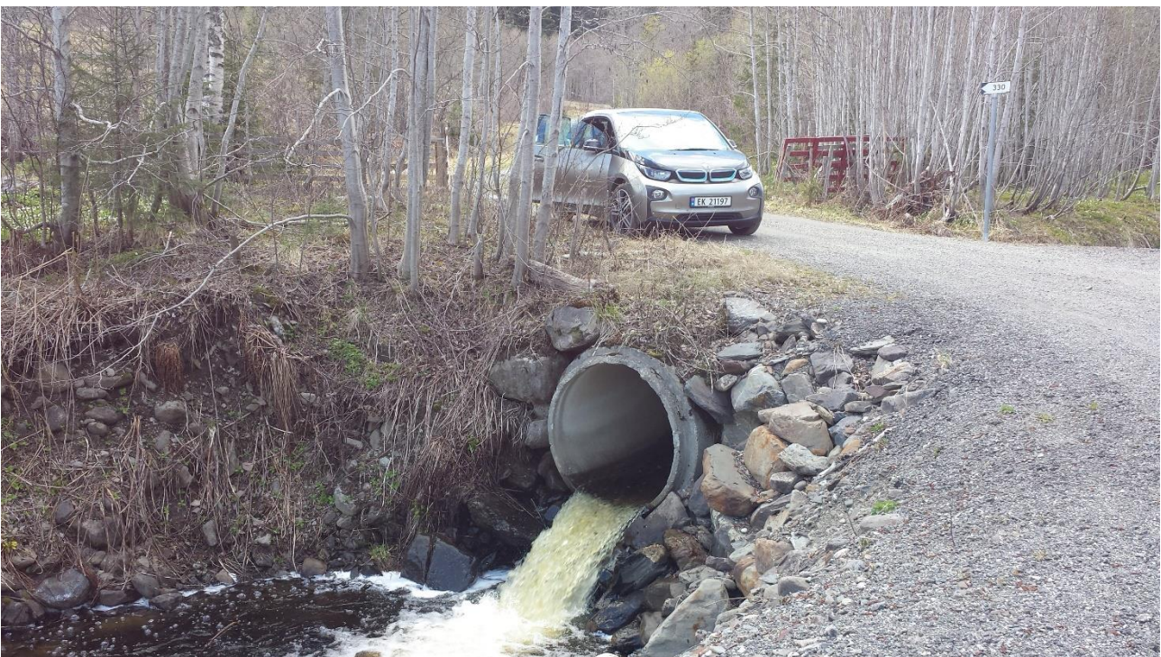
Figur 3-21: Utløp kulvert under øvre innkjøring til Finnsveen.
