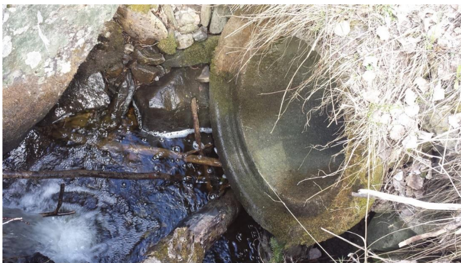
Figur 3-23: Innløp stikkrenne under innkjøring til Nordre Finnsveen. Vann renner under stikkrenne istedet for gjennom.
