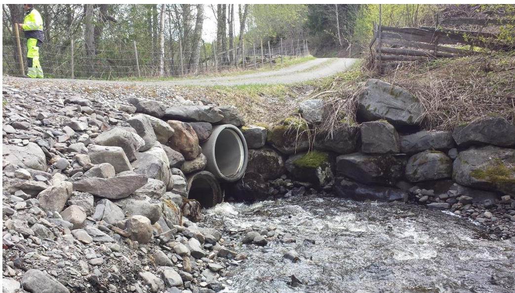
Figur 3-26: Innløp ved kryssing av traktorveg mot Flata. 2 stk. \varnothing 800 mm betongrør.
