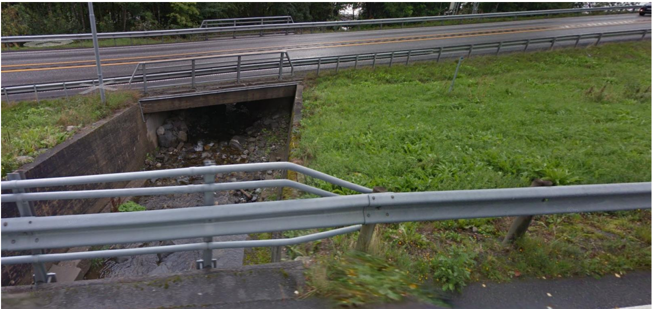
Figur 3-41: Innløp på bru under E6. Alternativ flomvei vil være mot høyre/sørover til vegggrøft og gangkulvert som ligger lenger sør (Utsnitt fra Google Street View).
