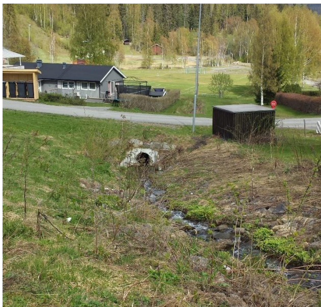
Figur 3-48: Bekkeløp gjennom boligfelt ved Vingar. Nye stikkrenner har vingemur.
