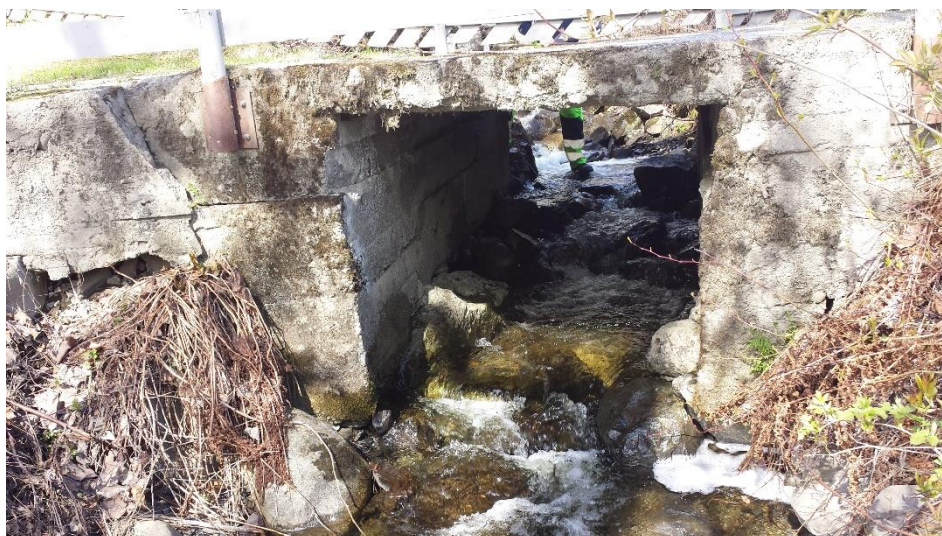
Figur 3-10: Nedside av kulvert til Vingromsvegen 223
