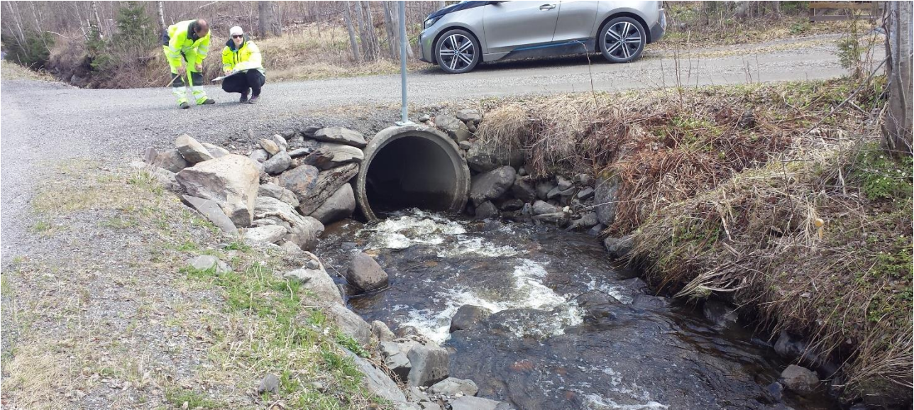
Figur 3-20: Innløp kulvert under øvre innkjøring til Finnsveen.
