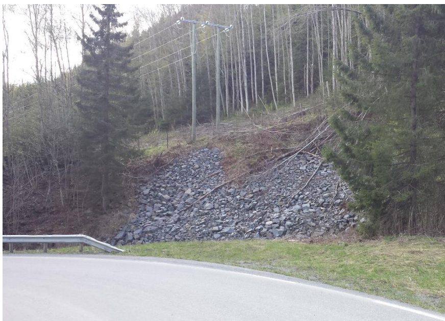
Figur 3-28: Noe eksisterende erosjonssikring i høy skjæring.
