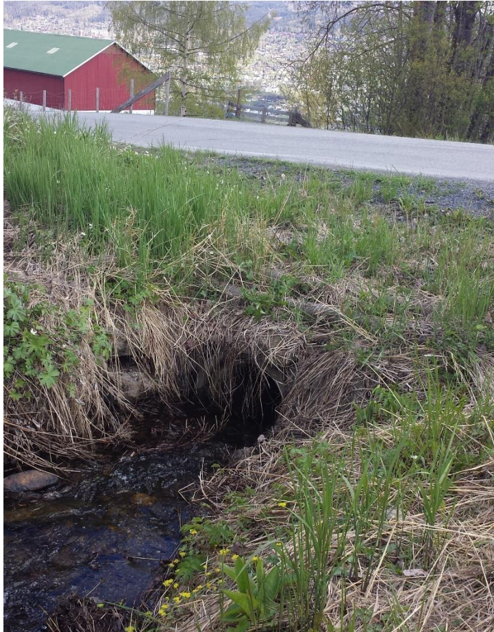
Figur 3-44: Innløp stikkrenne gjennom Saksumdalsvegen ved Øvre Ravneberg. Stikkrenna er et ø400mm betongrør.
