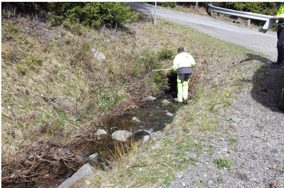
Figur 3-15: Innløp kulvert under innkjøring til Engen.
