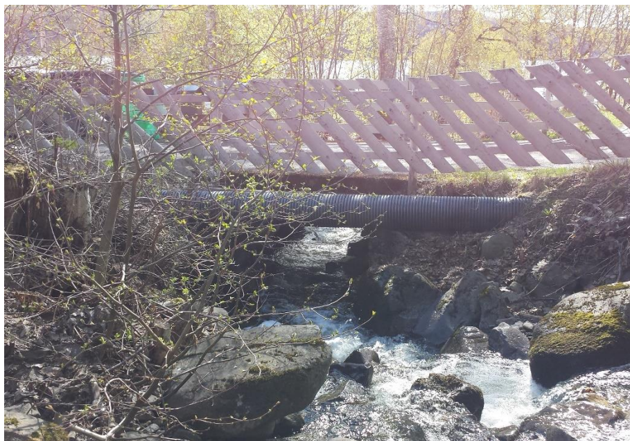
Figur 3-9: Oppstrøms kulvert til Vingromsvegen 223
