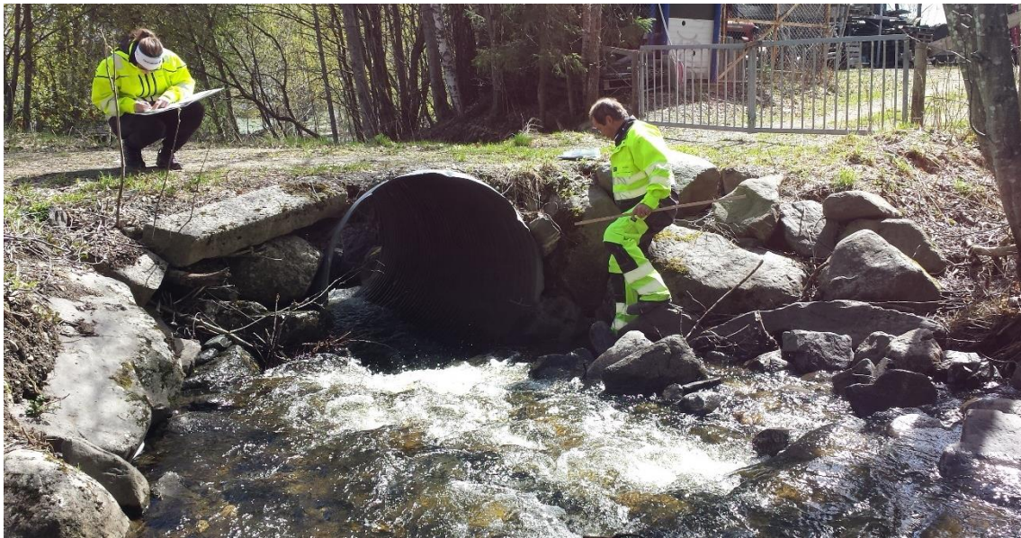
Figur 3-30: Innløp til kulvert (ø1500mm) under innkjøring til lagringsplass ved Øyrevegen 5.
