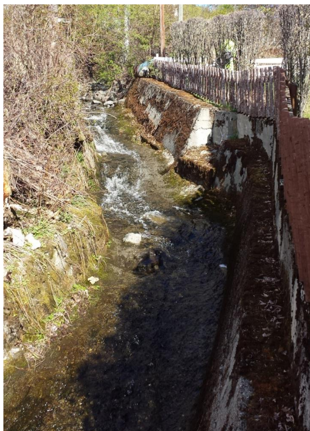
Figur 3-13: Betong/Asfalt-kanal oppstrøms bekkelukking under Fv. 331/E6
