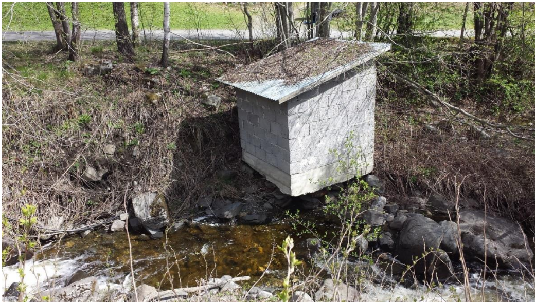
Figur 3-35: Skur av lecablokker oppstrøms kulvert under Hovslivegen.
