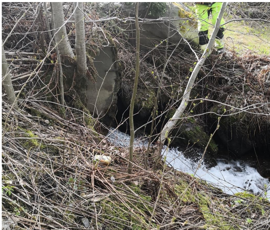
Figur 3-56: Utløp av ø1200mm betongrør på kulvert under Kastrudvegen.
