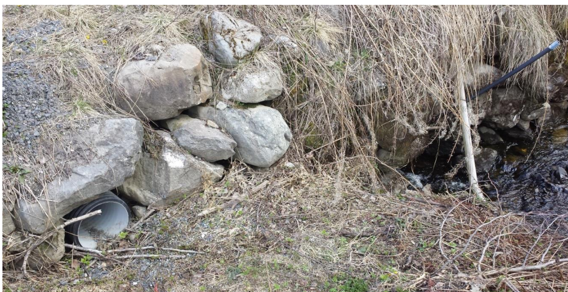
Figur 3-25: Innløp kulvert under Vottestadvegen (til høyre) med overløp.
