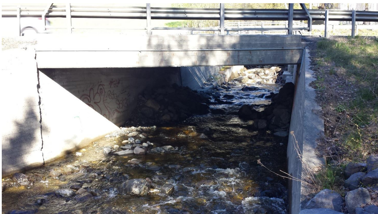
Figur 3-39: Utløpsiden av kulvert/kanal under fv. 331/E6
