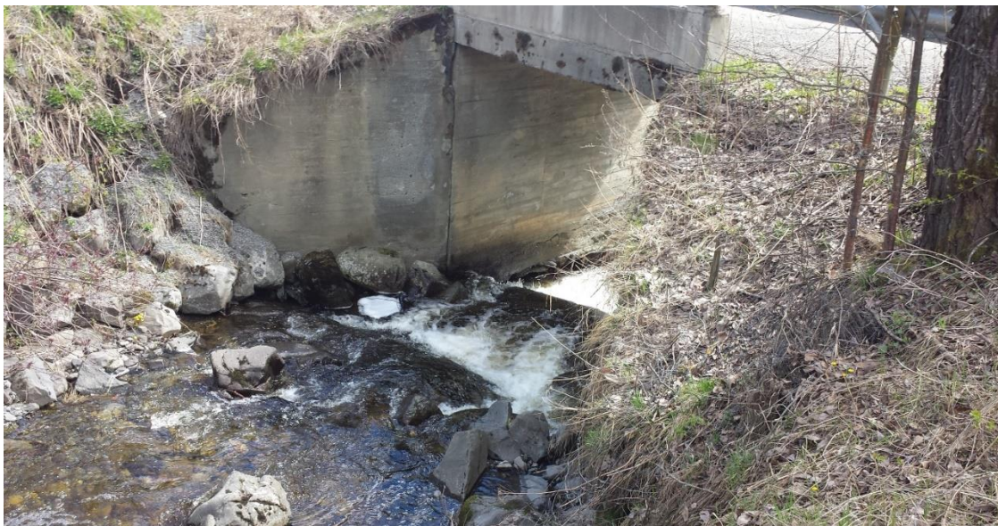
Figur 3-34: Innløp på kulvert under Hovslivegen
