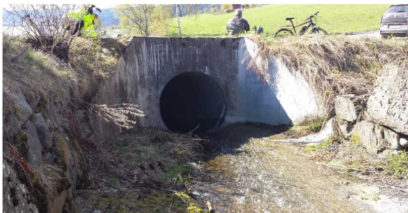
Figur 3-11: Innløp Vottestadbekken for bekkelukking under Fv. 331 og E6
