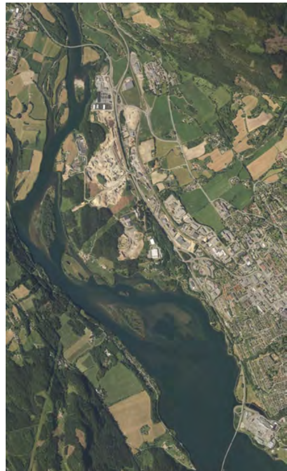
Figur 95 Ortofoto over strekningen.
