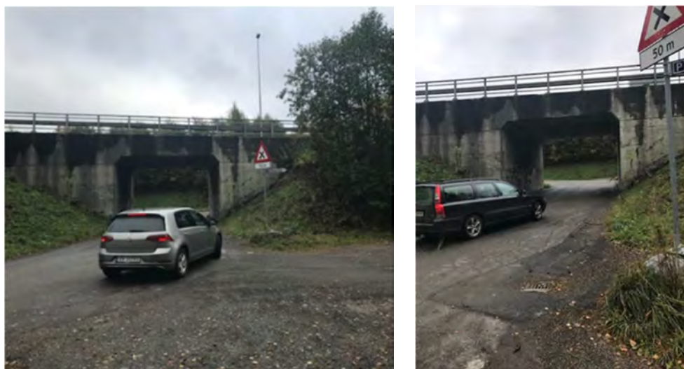
Figur 125 Bilder av undergang/veikulvert.
