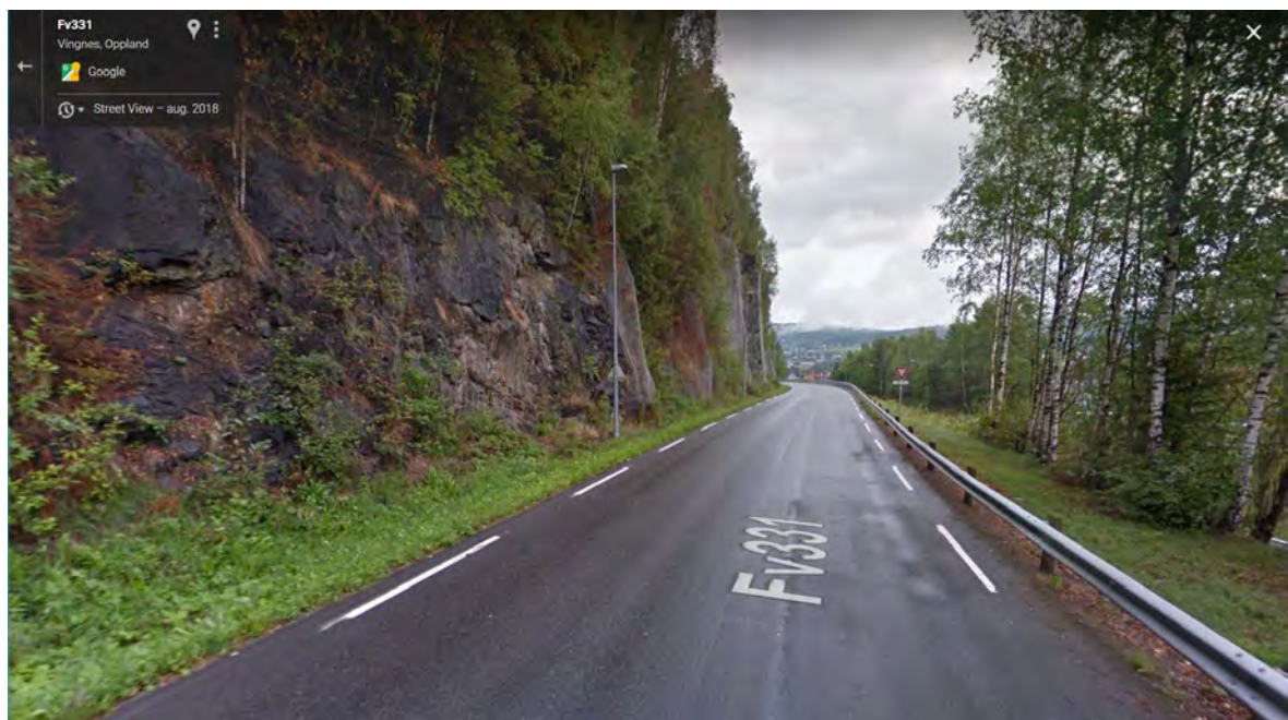
Figur 44 Strekningen ved fjellskjæringen, utklipp fra Google Street View.
