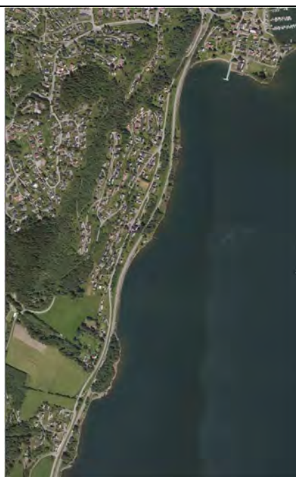
Figur 25 Ortofoto over strekningen
