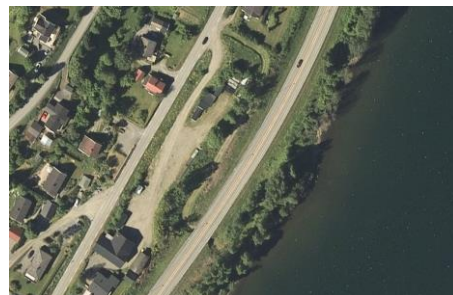
Kulvert ved Øyresbrettingen
