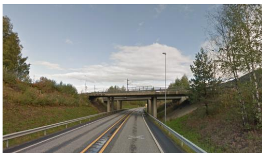
Figur 32 Kryssende kjørebru og jernbanebru på Hovemoen
