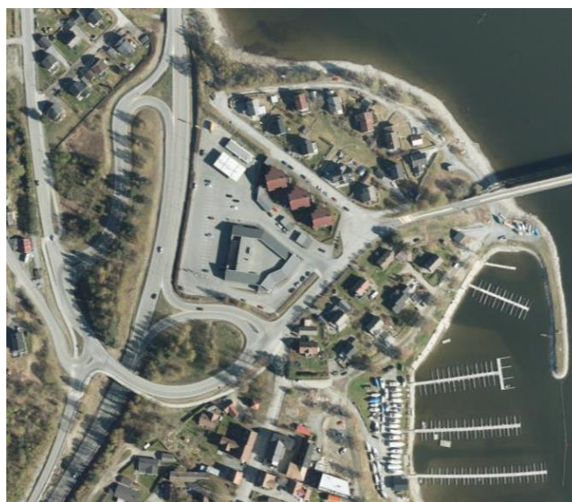
Figur 12 Dagens planfrie kryss ved Vingnes.
