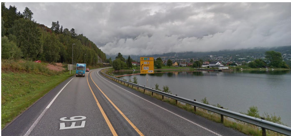
Figur 54 Bilde som viser vegprofilet med forsterket midtoppmerking på avlastet E6 ved Lillehammer.
