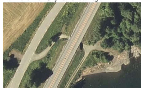
Kulvert ved Øyresvika
