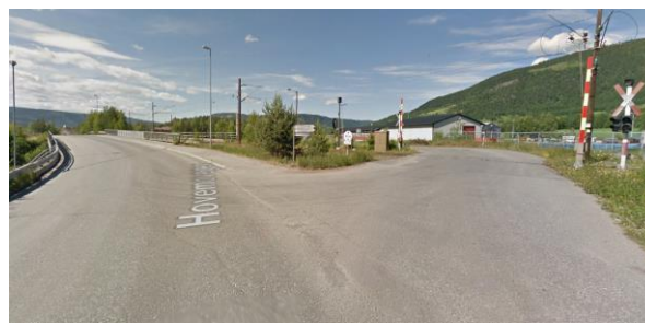
Figur 1933 Hovemobrua med fortau og privat veg som krysser jernbanesporet. Signal og bom.
