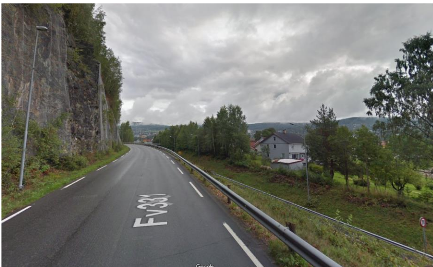
Figur 59 Vingromsvegen ved fjellskjæringa
