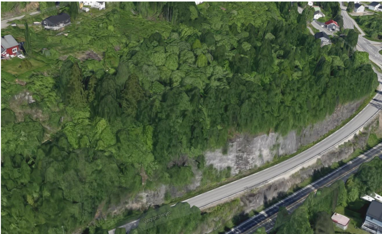
Figur 2: Oversiktsbilde fra skjæringen. Hentet fra google maps.
