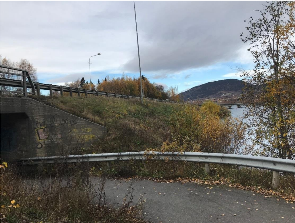
Figur 2 Undergang for sykkelvei mot Lensevegen i dag
