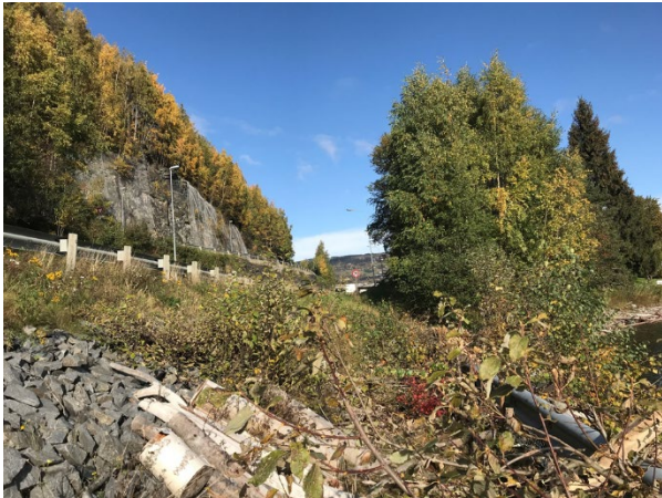
Figur 2 Eksisterende sti ligger på en hylle i vegfyllingen, og har bredde cirka to meter
