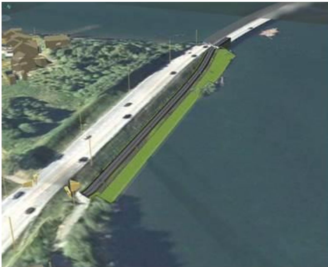
Figur 3.11: G/S-veg mellom Vingnes og Lillehammer bru
