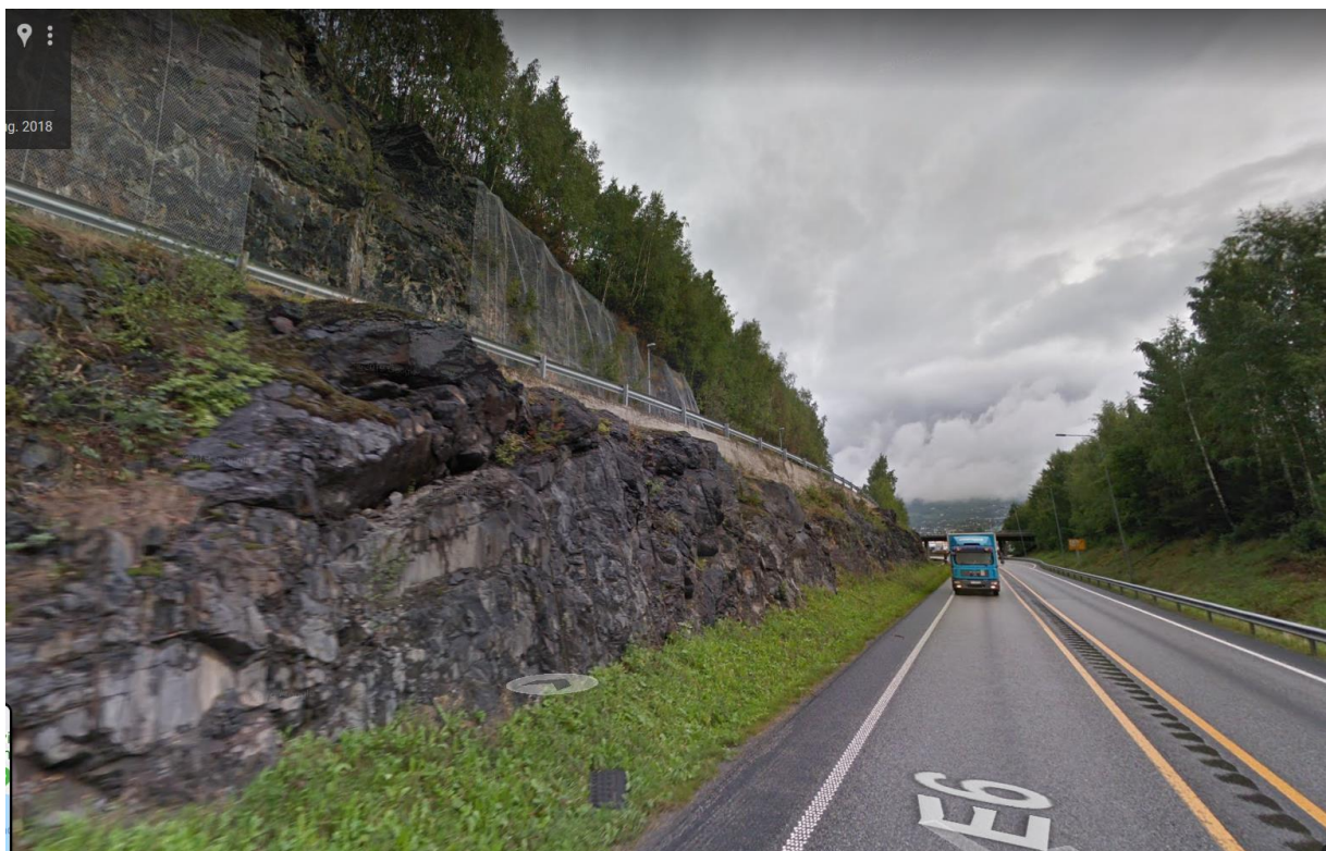
Figur 5.1: Bergskjæringer for Vingromsveien og E6.
